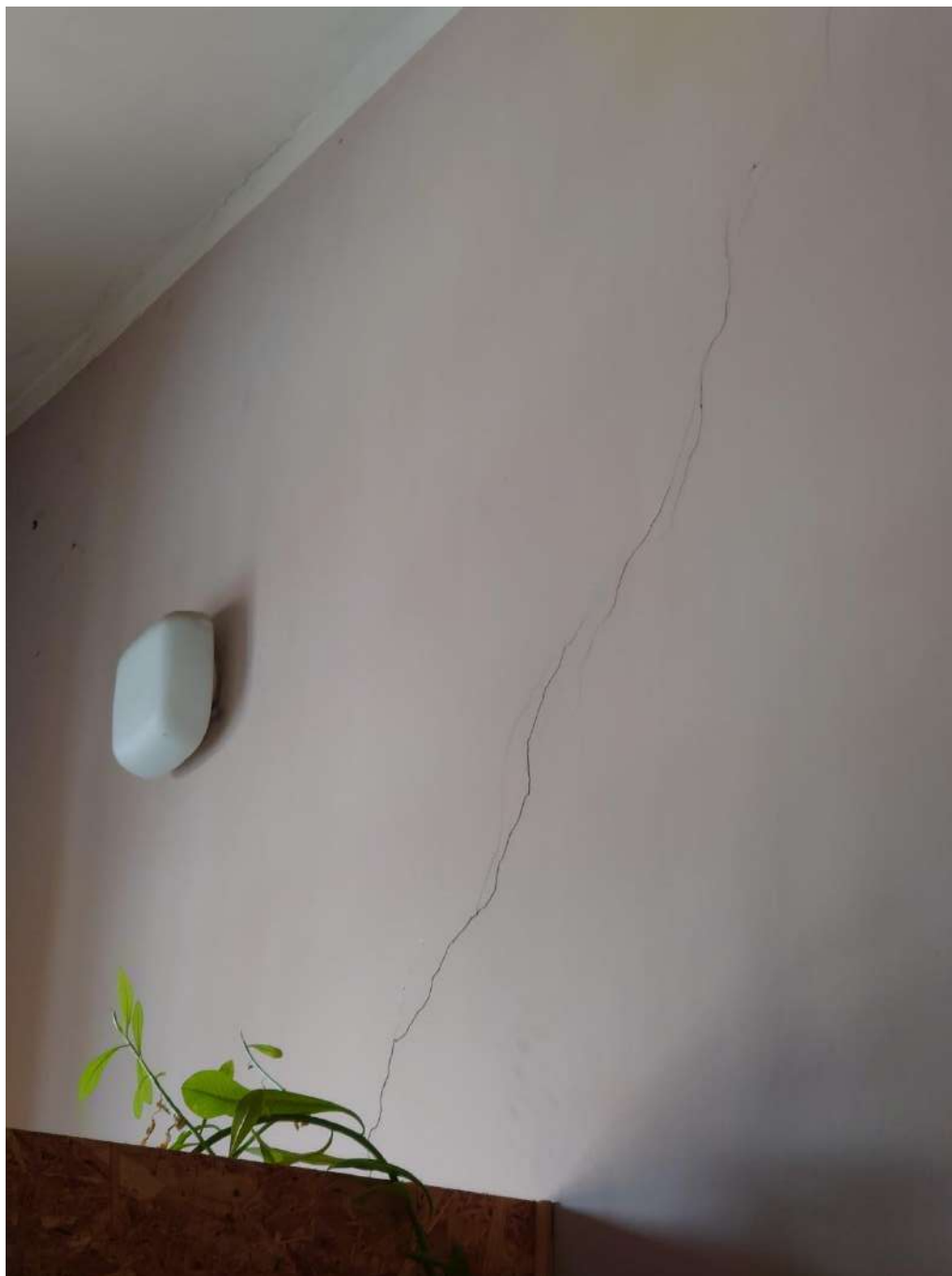
4 pav. Įtrūkimai vidinėje pastato sienoje
