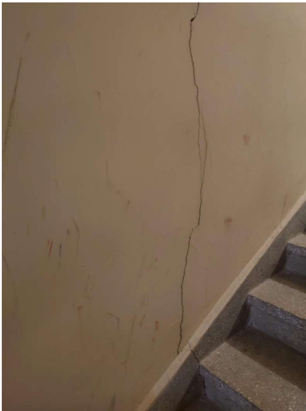
10 pav. Vidinių laiptų ir pertvarinės sienos įtrūkimas
