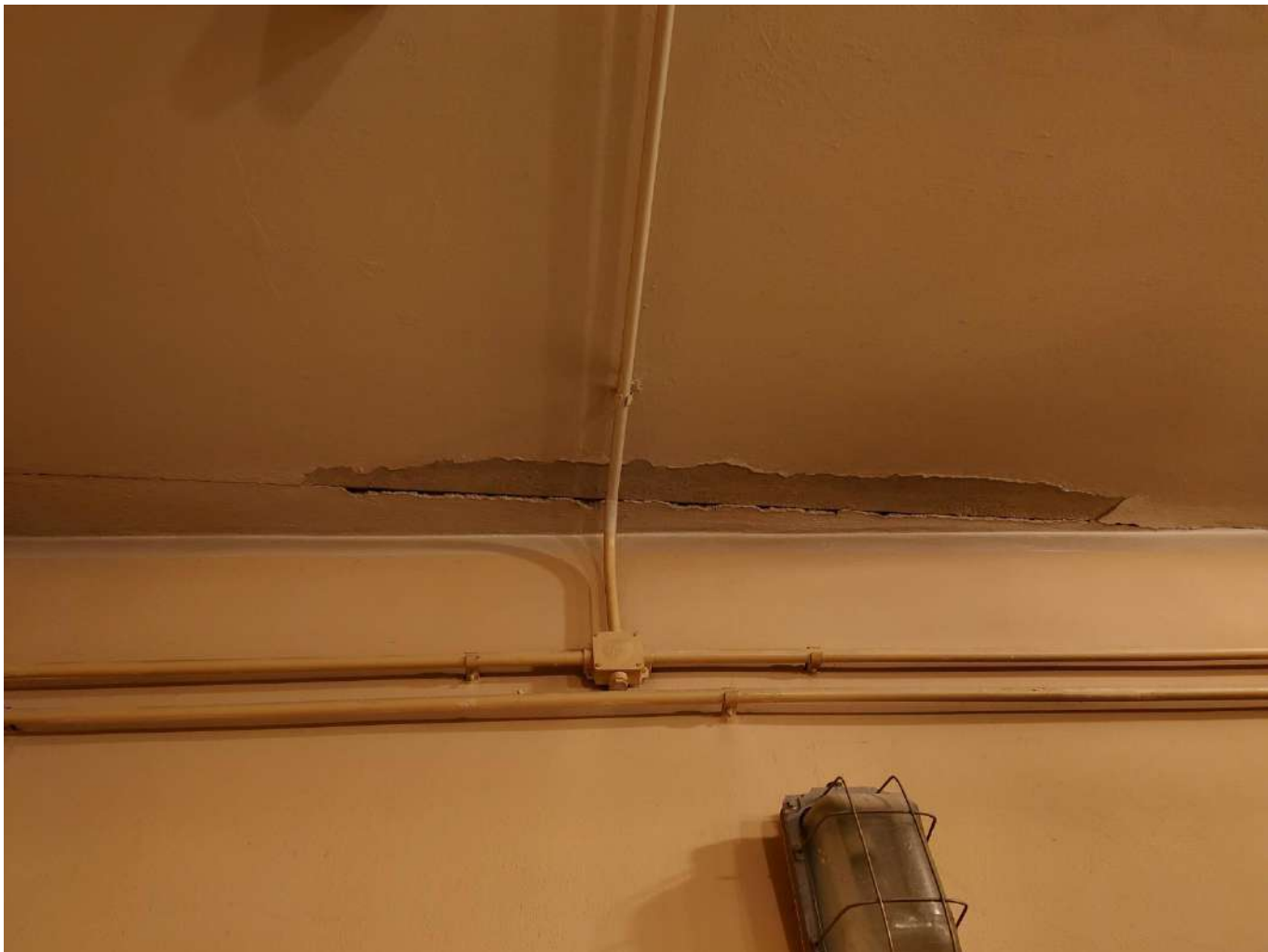
5 pav. Nutrūpėjęs perdangų tinkas
