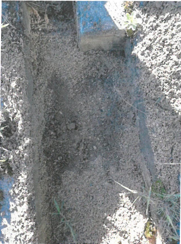
5 pav. Pusiau požeminių komunalinių atliekų konteinerių aikštelės Neravų g. 39B , Druskininkų mieste ( Nr. 28 ) pagrindas betoninių trinkelio dangų atstatymui.
