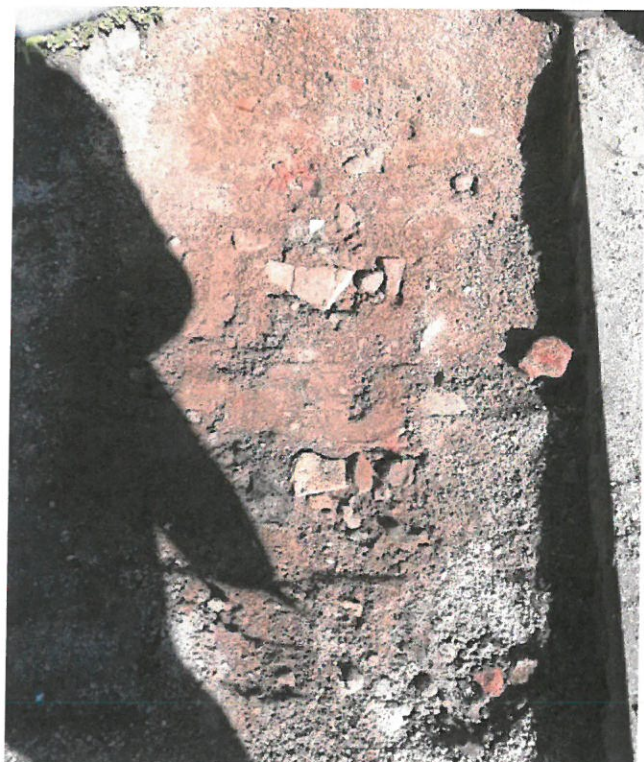
4 pav. Pusiau požeminių komunalinių atliekų konteinerių aikštelės Sodų g. 47 , Druskininkų mieste ( Nr. 31 ) pagrindas betoninių trinkelio dangų atstatymui.
