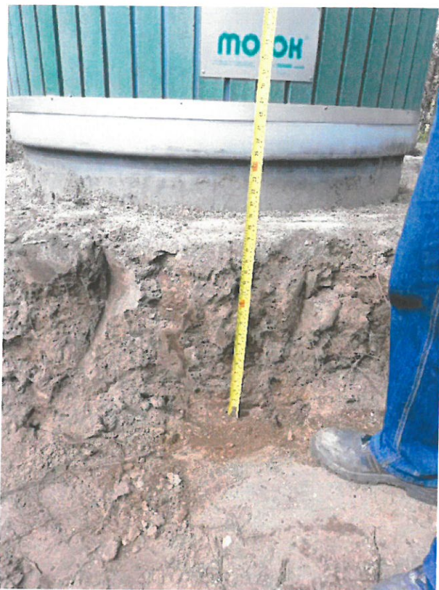
3 pav. Pusiau požeminių komunalinių atliekų konteinerių aikštelės Vilniaus al. 11 , Druskininkų mieste ( Nr. 50 ) pagrindas betoninių trinkelio dangų atstatymui.
