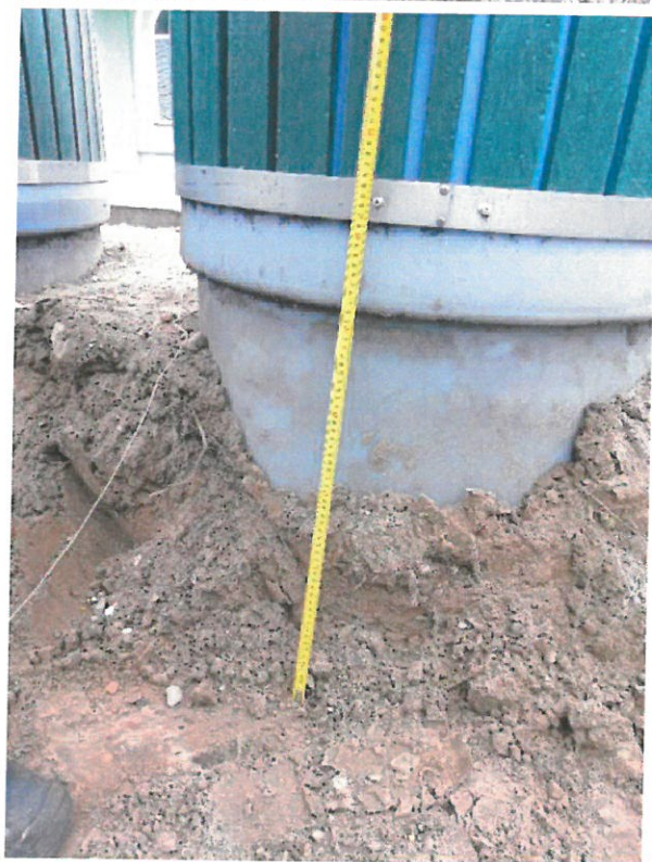
2 pav. Pusiau požeminių komunalinių atliekų konteinerių aikštelės Vilniaus al. 13 , Druskininkų mieste ( Nr. 49 ) pagrindas betoninių trinkelų dangų atstatymui
