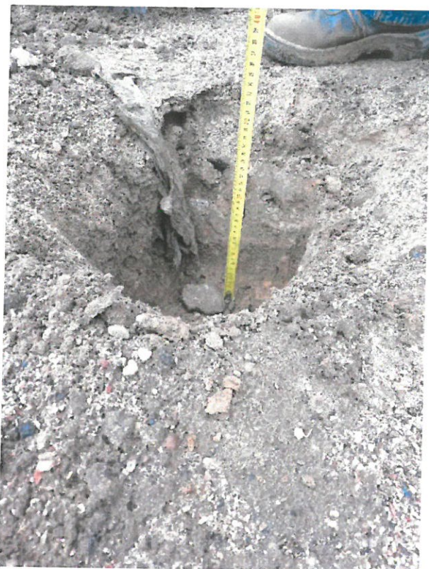
1 pav. Pusiau požeminių komunalinių atliekų konteinerių aikštelės Vilniaus al. 32 , Druskininkų mieste ( Nr. 44 ) pagrindas betoninių trinkelų dangų atstatymui.
