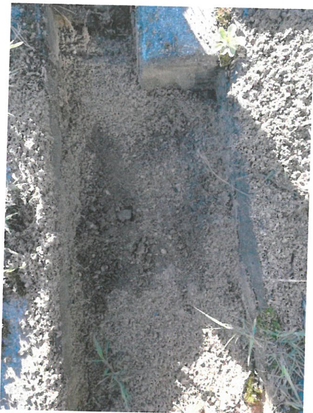
5 pav. Pusiau požeminių komunalinių atliekų konteinerių aikštelės Neravų g. 39B , Druskininkų mieste ( Nr. 28 ) pagrindas betoninių trinkelų dangų atstatymui.
