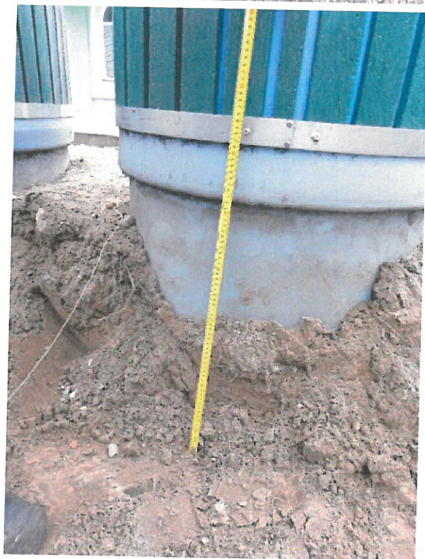
2 pav. Pusiau požeminių komunalinių atliekų konteinerių aikštelės Vilniaus al. 13 , Druskininkų mieste ( Nr. 49 ) pagrindas betoninių trinkelų dangų atstatymui
