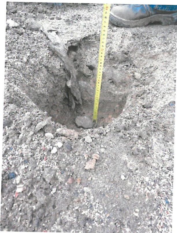
1 pav. Pusiau požeminių komunalinių atliekų konteinerių aikštelės Vilniaus al. 32 , Druskininkų mieste ( Nr. 44 ) pagrindas betoninių trinkelų dangų atstatymui.
