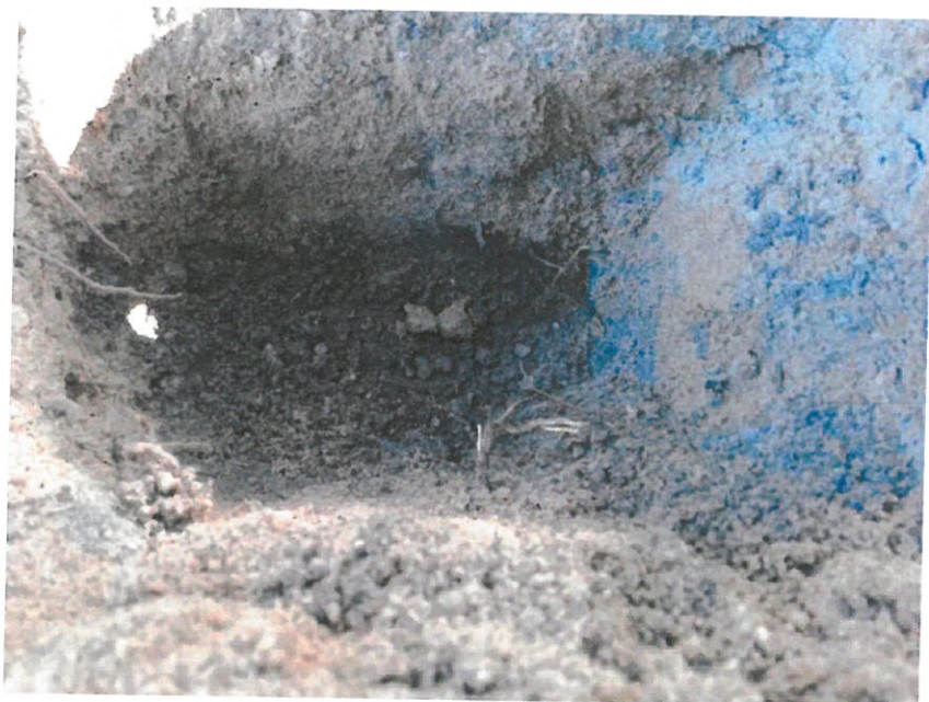
7 pav. Pusiau požeminių komunalinių atliekų konteinerių aikštelės Melioratorių g. 4, Leipalingio mstl. , Druskininkų sav. (Nr. 67) pagrindas betoninių trinkelio dangų atstatymui
