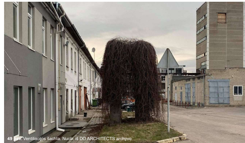
49 pav. Ventiliacijos šachta. Nuotr. iš DO ARCHITECTS archyvo
