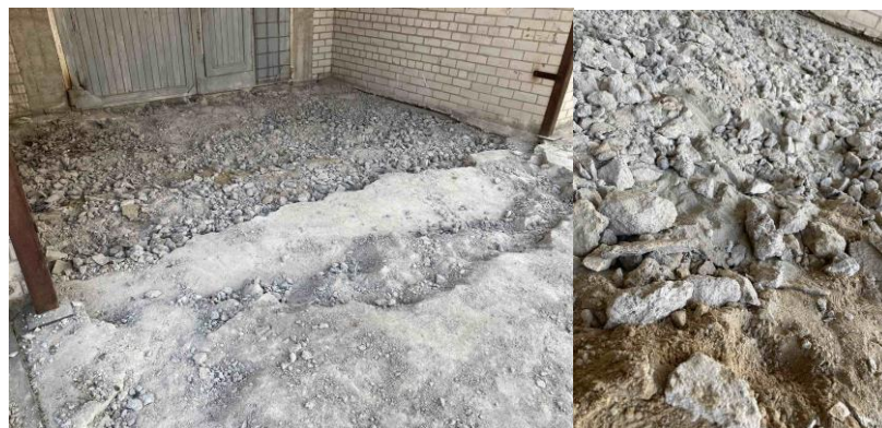
5 pav. Rampos pagrindo ardymo darbų etapas
