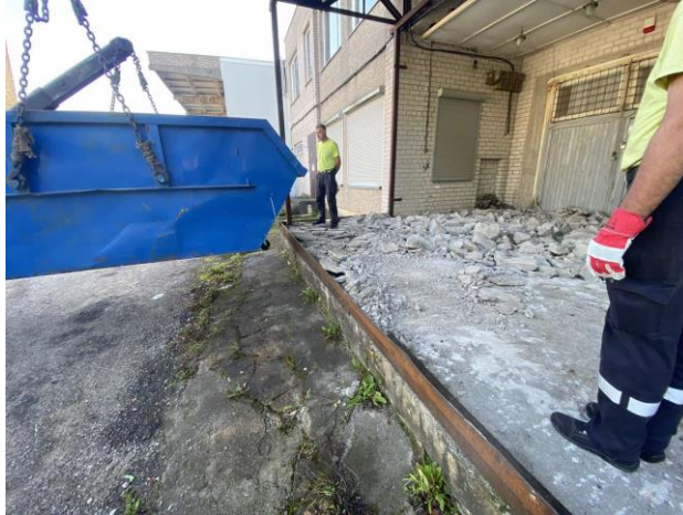
4 pav. Rampos pagrindo ardymo procesas
