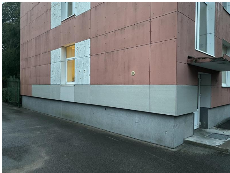
6 pav. Birutės g. 16, Klaipėda pastato plokščių keitimo etapas
