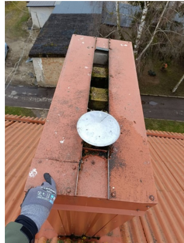
4 pav. Esama kamino kepurė
