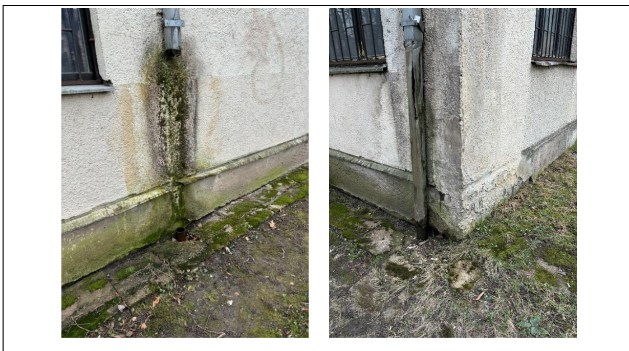
4 pav. 1B2p pastato išorės esamos cokolio būklės fotofiksacija
