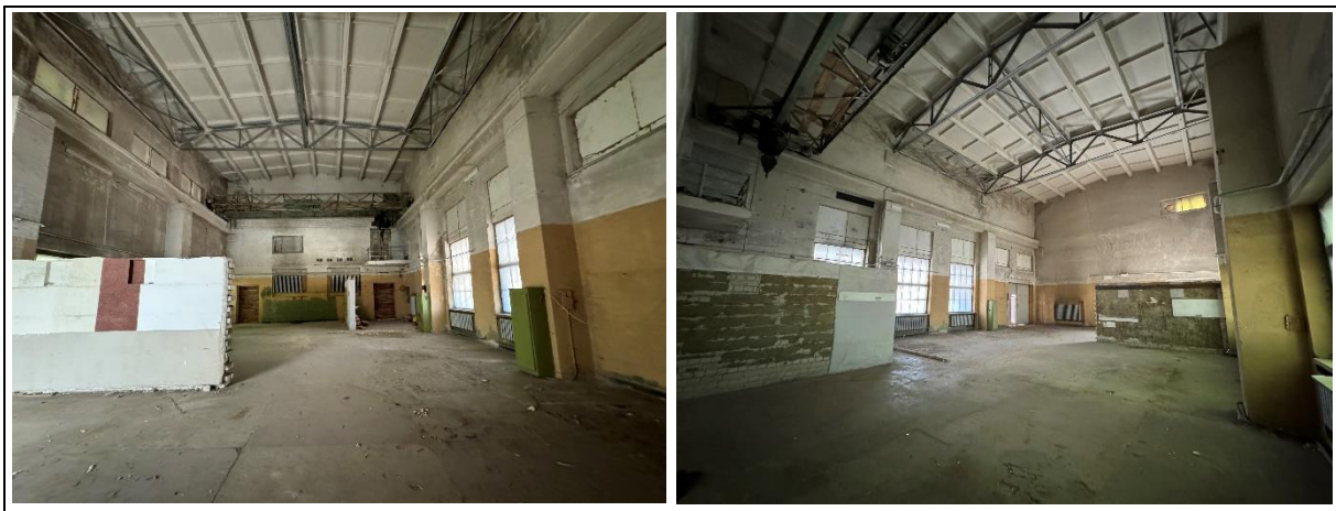
1 pav. 1-23 patalpos esamos būklės fotofiksacija
