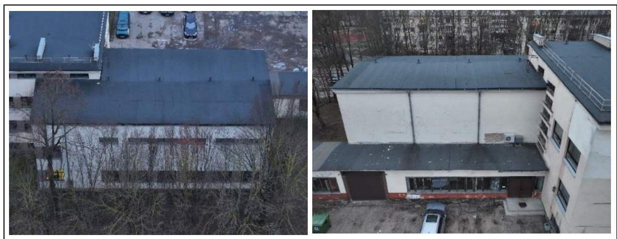
3 pav. 1B2p pastato išorės esamos būklės fotografacija
