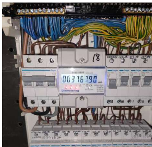
pav. 3 3F esamas elektros skaitiklis
