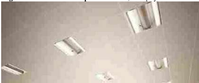
Segmentinės mineralinio pluošto lubos , kurių dydis 60 x 60 cm gali būti įrengiamos wc ir valytojos patalpose
