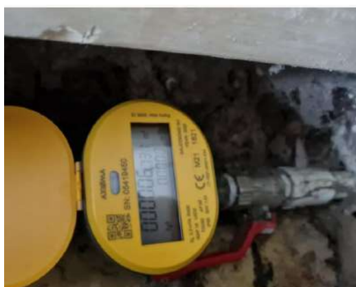
pav. 6 VS2.1 Pakeisto vandens skaitiklio vizualizacija
