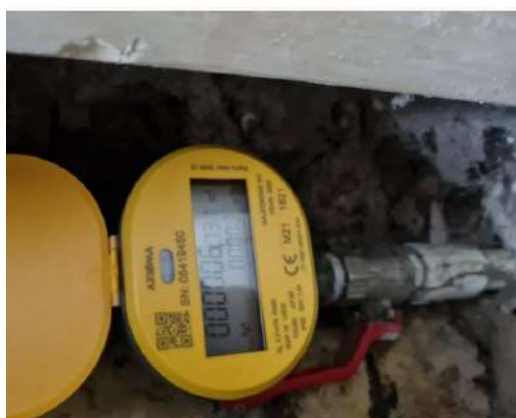
pav. 6 VS2.1 Pakeisto vandens skaitiklio vizualizacija
