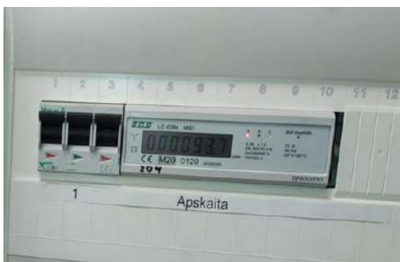
pav. 4 3F pakeistas elektros skaitiklis
