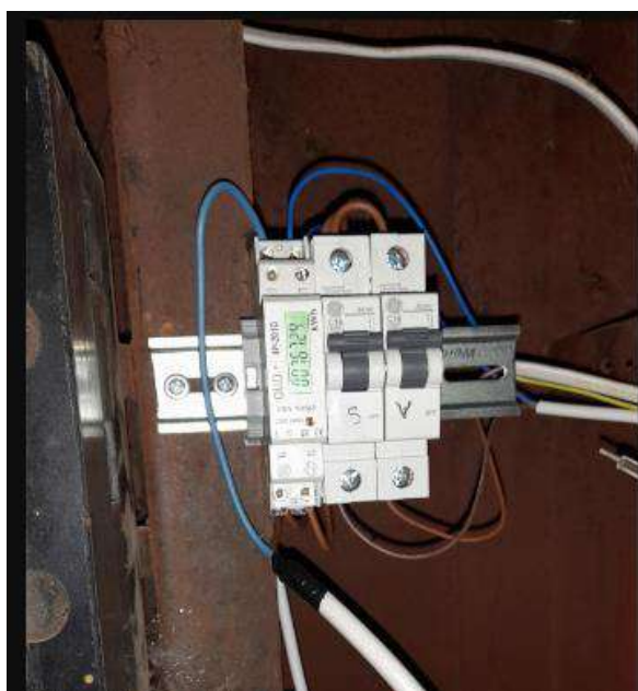
pav. 2 1F esamas elektros skaitiklis
