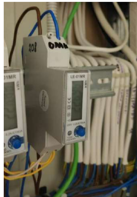
pav. 1 1F pakeistas elektros skaitiklis
