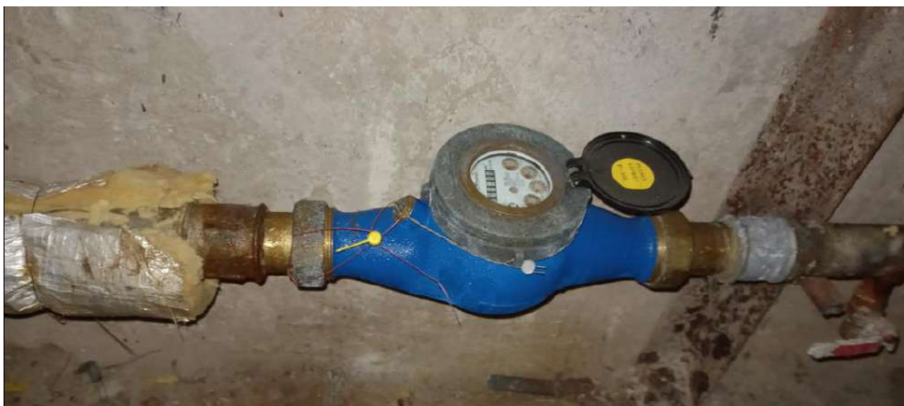
pav. 5 VS1.1 esamo vandens skaitiklio vizualizacija
