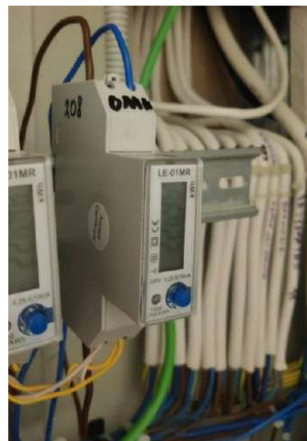
pav. 1 1F pakeistas elektros skaitiklis
