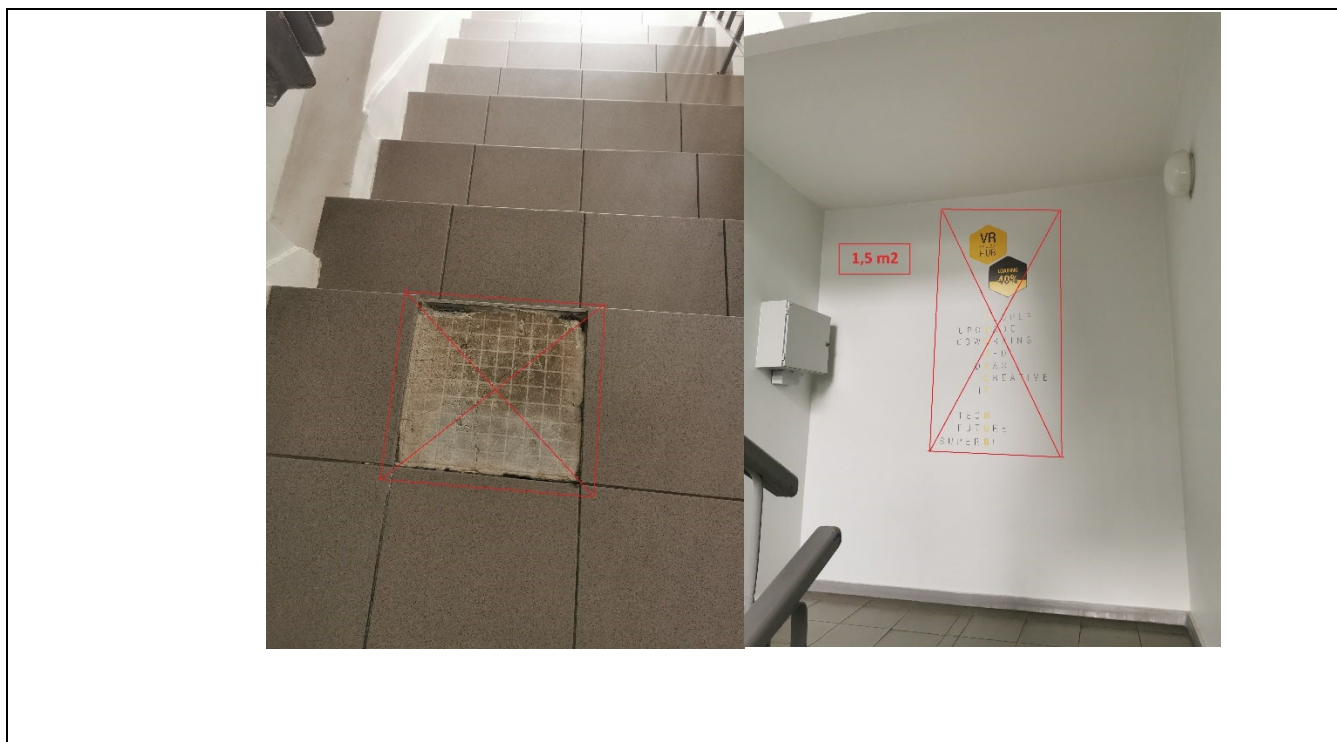
14 pav. laiptinės esamos būklės fotofiksacija
