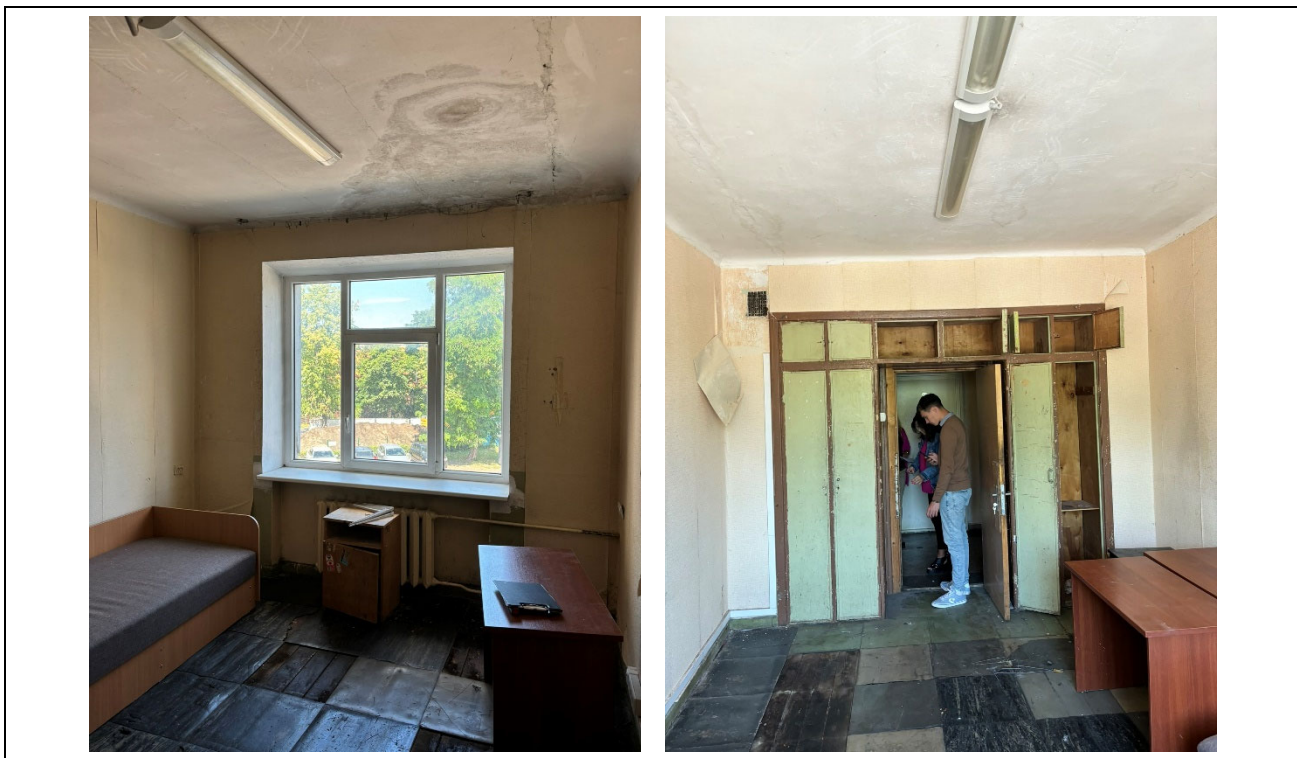
1 pav. 226 kambario esamos būklės fotofiksacija
