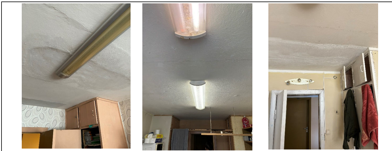
4 pav. 223,405,526 kambarių esamos būklės fotografavimas
