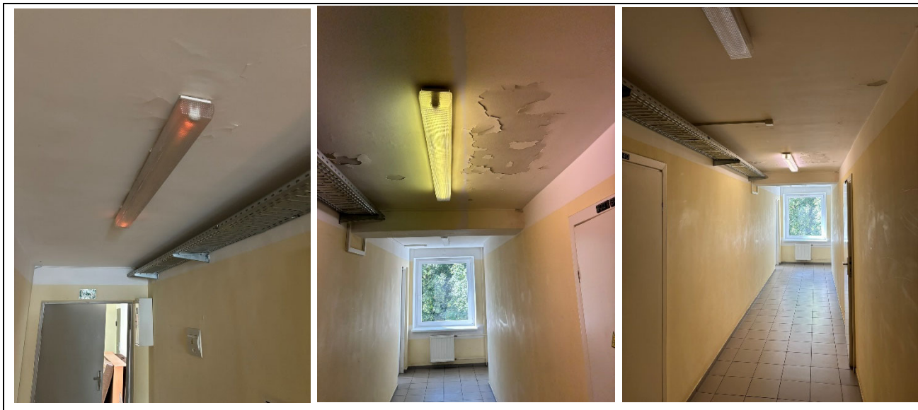
10 pav. 3a. 1 laiptinės esamos būklės fotofiksacija
