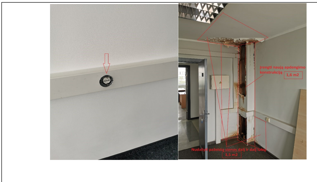
8 pav. 508 kab. esamos būklės fotofiksacija
