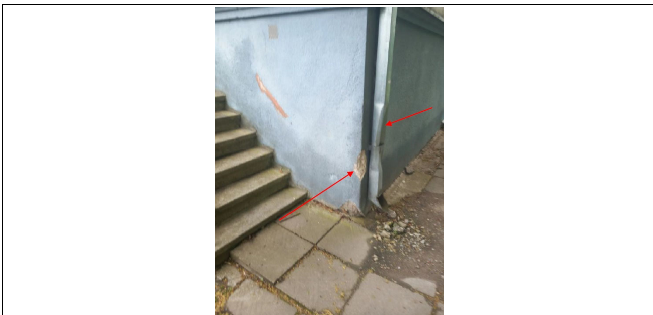
2 pav. cokolio ir lietašvaidžio esamos būklės fotofiksacija
