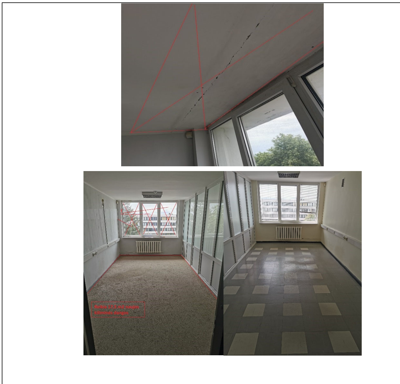
6 pav. 505 kab. esamos būklės fotofiksacija
