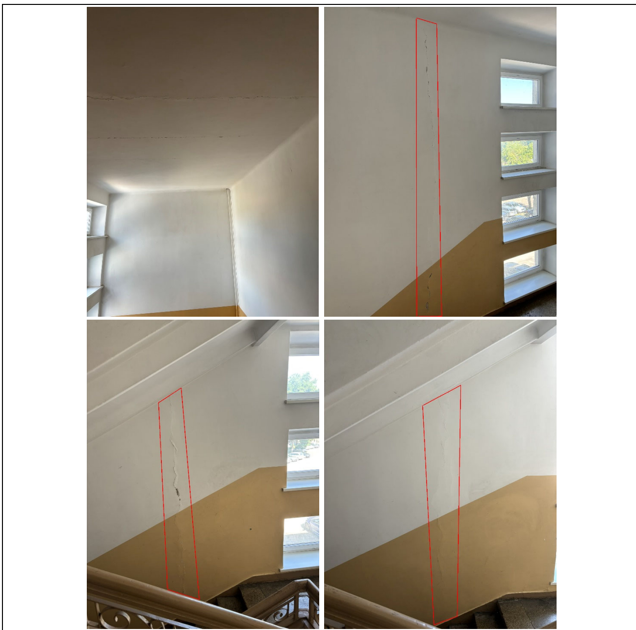
4 pav. kairės pusės laiptinės esamos būklės fotofiksacija
