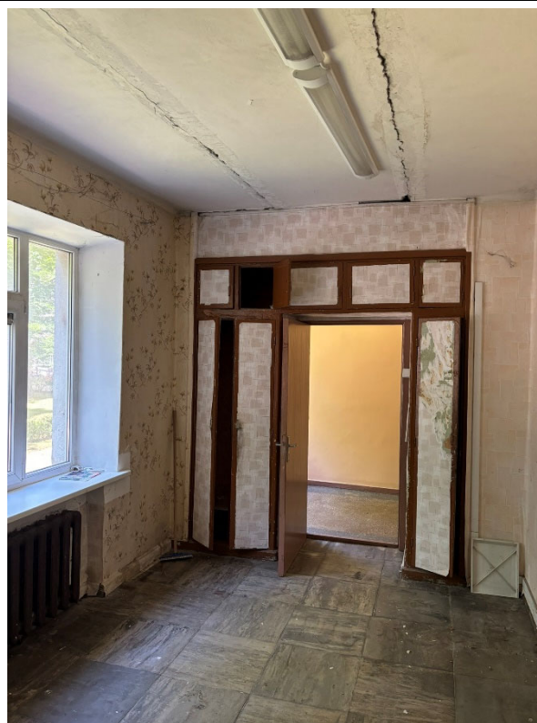
3 pav. 114 kambario esamos būklės fotofiksacija
