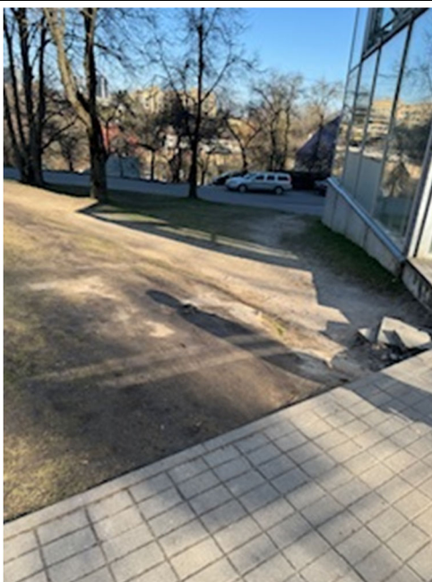
6 pav. projektuojamo pėsčijų tako esamos vietos būklės foto fiksacija
