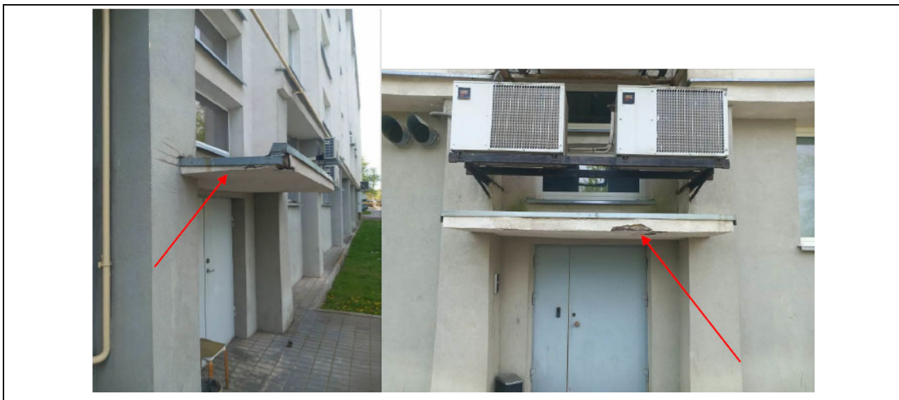
2 pav. stogelio esamos būklės fotofiksacija
