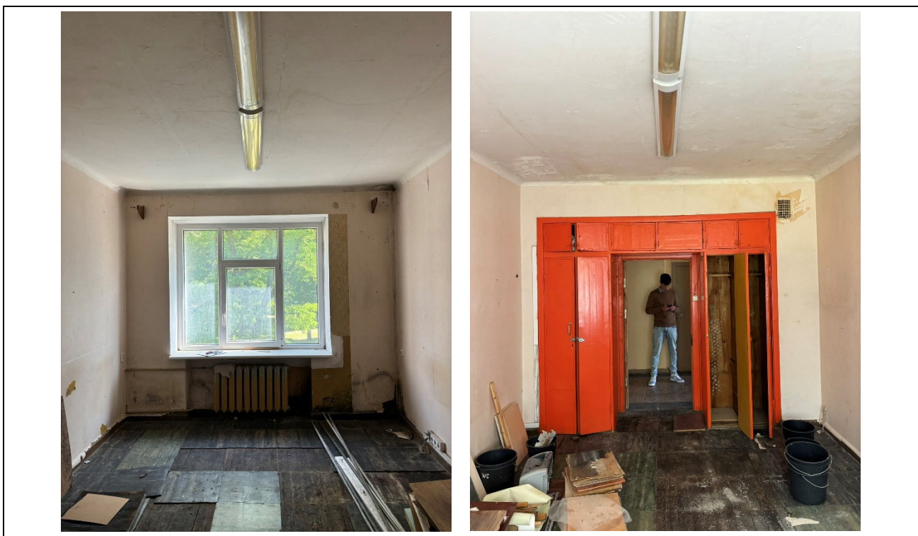
2 pav. 235 kambario esamos būklės fotofiksacija
