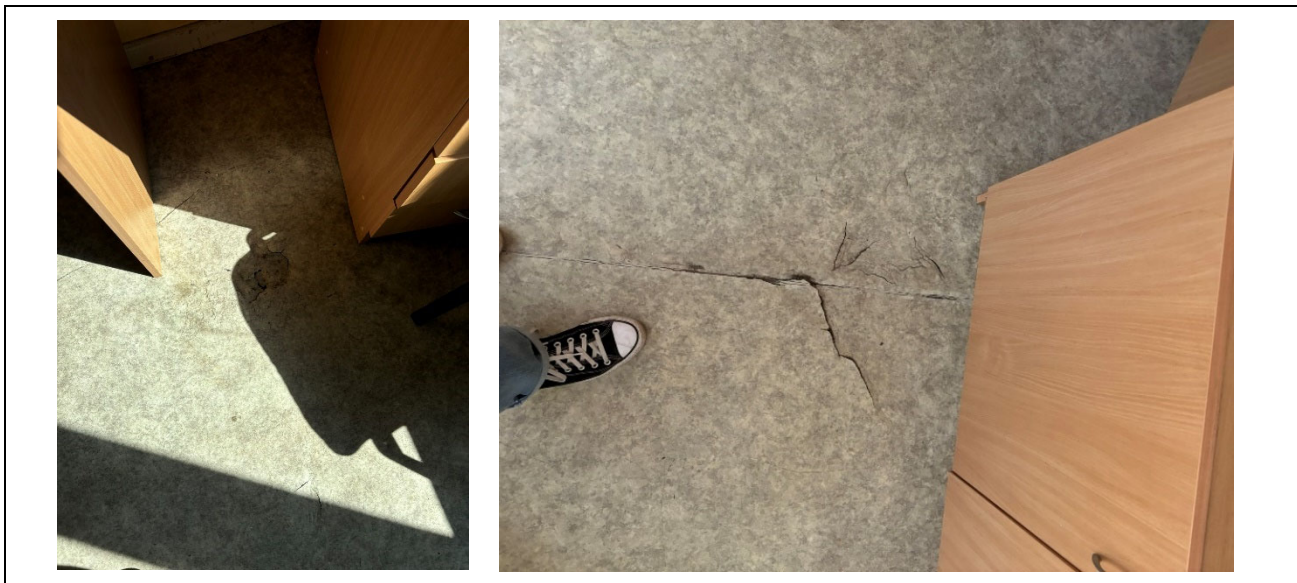
7 pav. 235 kambario grindų esamos būklės fotofiksacija
