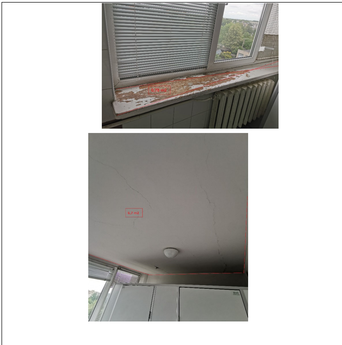
13 pav. 513 kab. esamos būklės fotofiksacija
