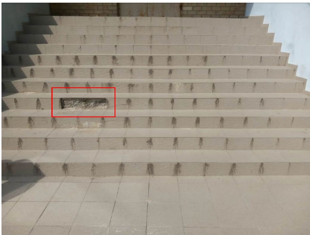
1 pav. lauko laiptų esamos būklės fotografacija
