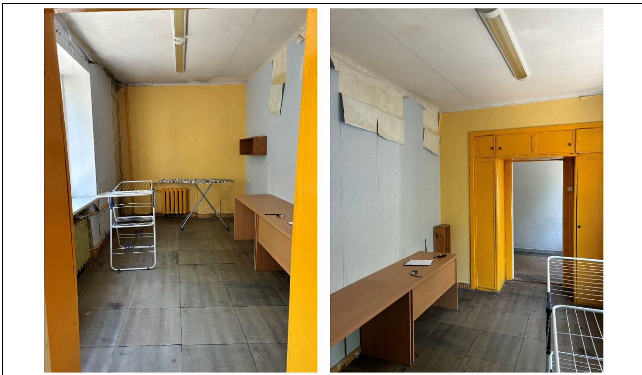
3 pav. 301 kambario esamos būklės fotofiksacija
