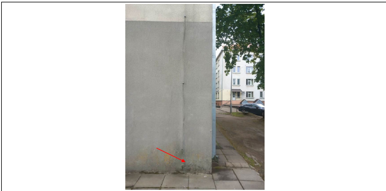
3 pav. žaibolaidžio esamos būklės fotografacija
