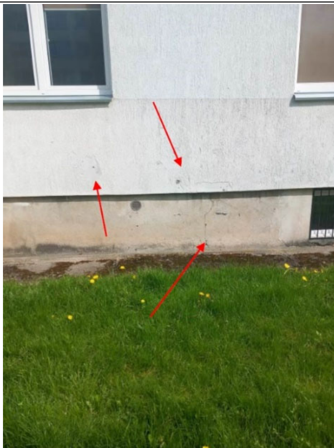
1 pav. cokolio ir fasado esamos būklės fotofiksacija
