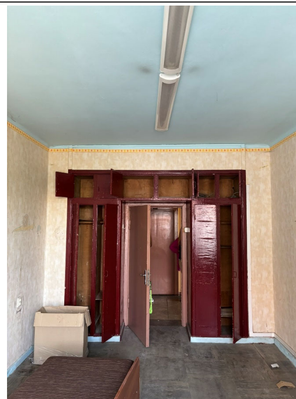
4 pav. 423 kambario esamos būklės fotofiksacija
