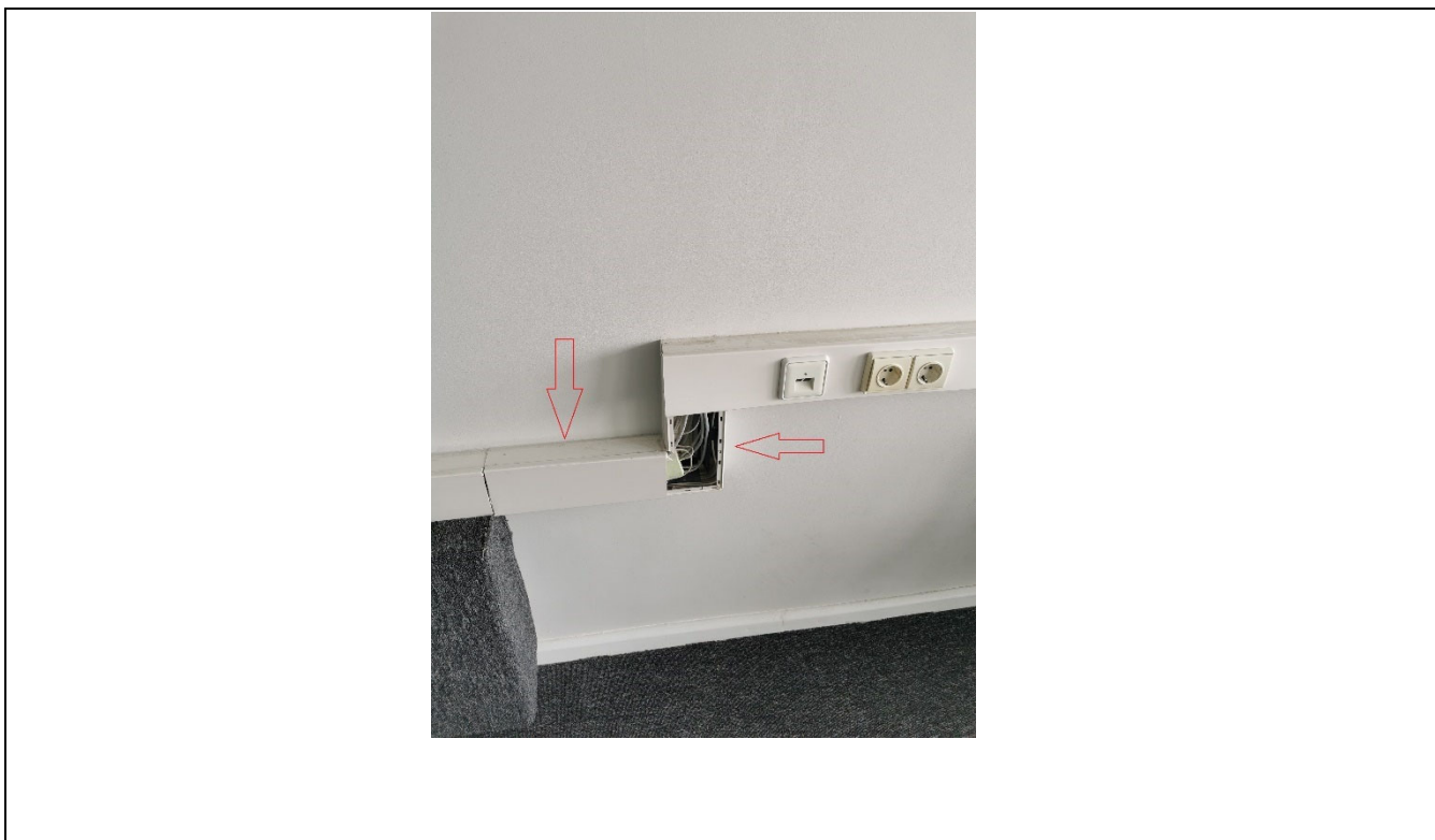
9 pav. 509 kab. esamos būklės fotofiksacija
