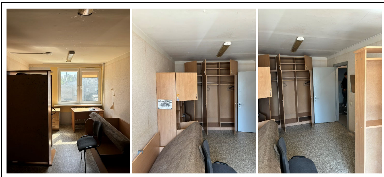
8 pav. 324 kambario esamos būklės fotofiksacija
