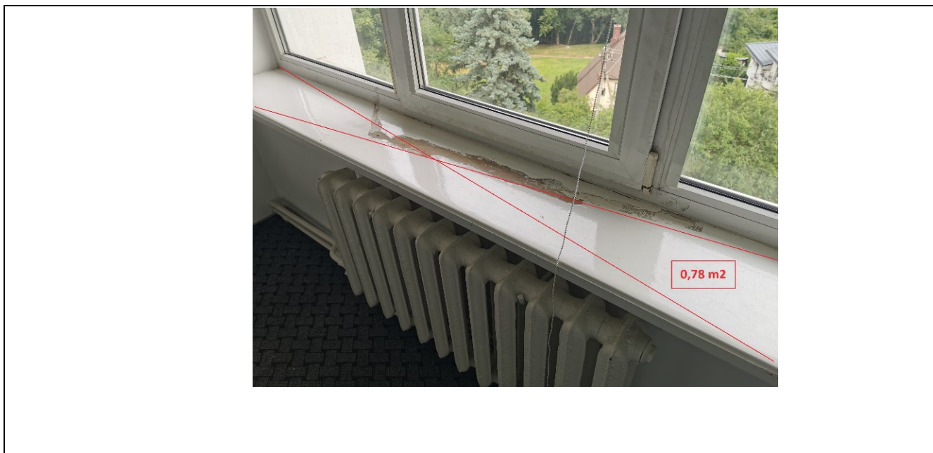
7 pav. 507 kab. esamos būklės fotofiksacija
