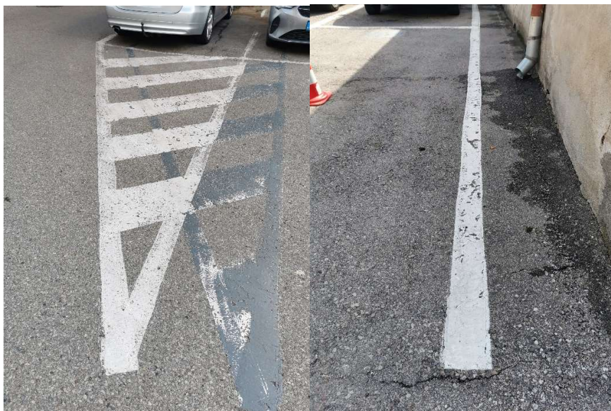
2 pav. atnaujinamų linijų ir ženklinių esamos būklės fotografacija
