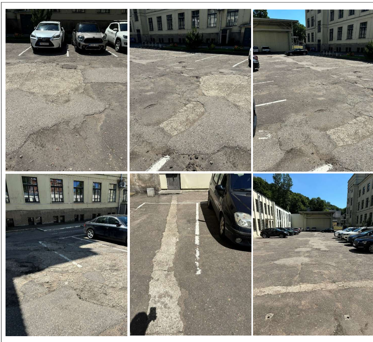
3 pav. atnaujinamų linijų ir ženklinių esamos būklės fotografacija
