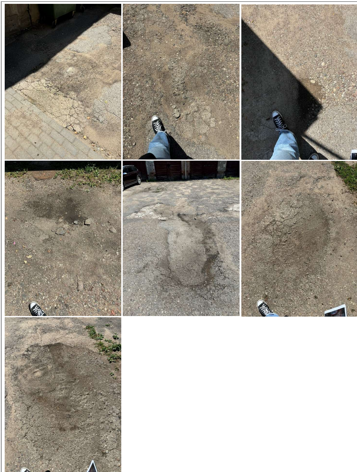
2 pav. užtaisomų duobių esamos būklės fotografacija
