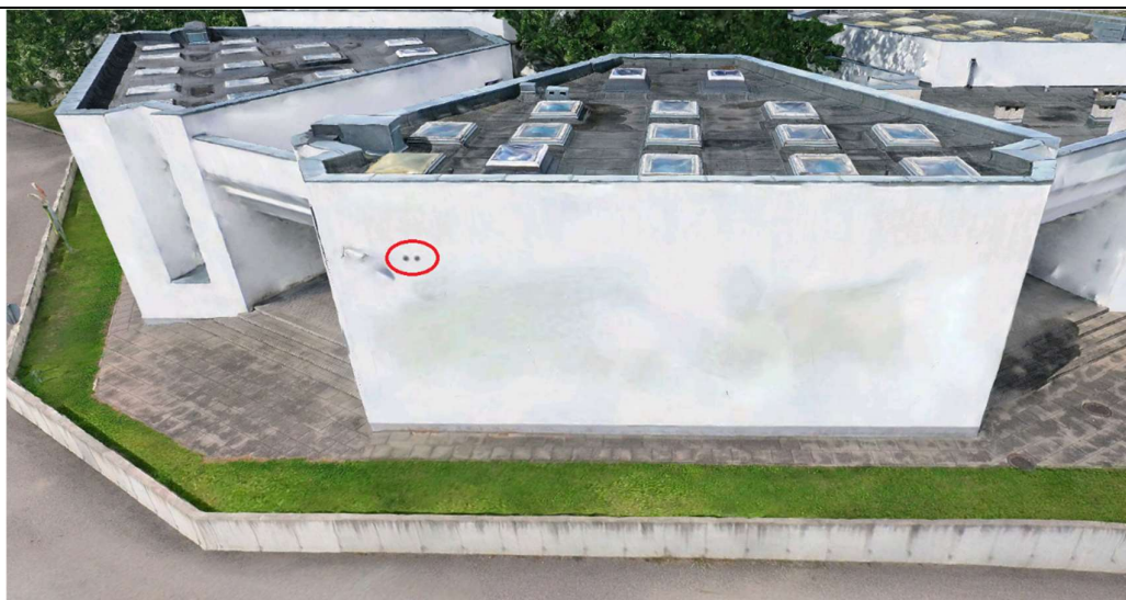
2 pav. ventiliacijos grotelių esamos būklės fotofiksacija
