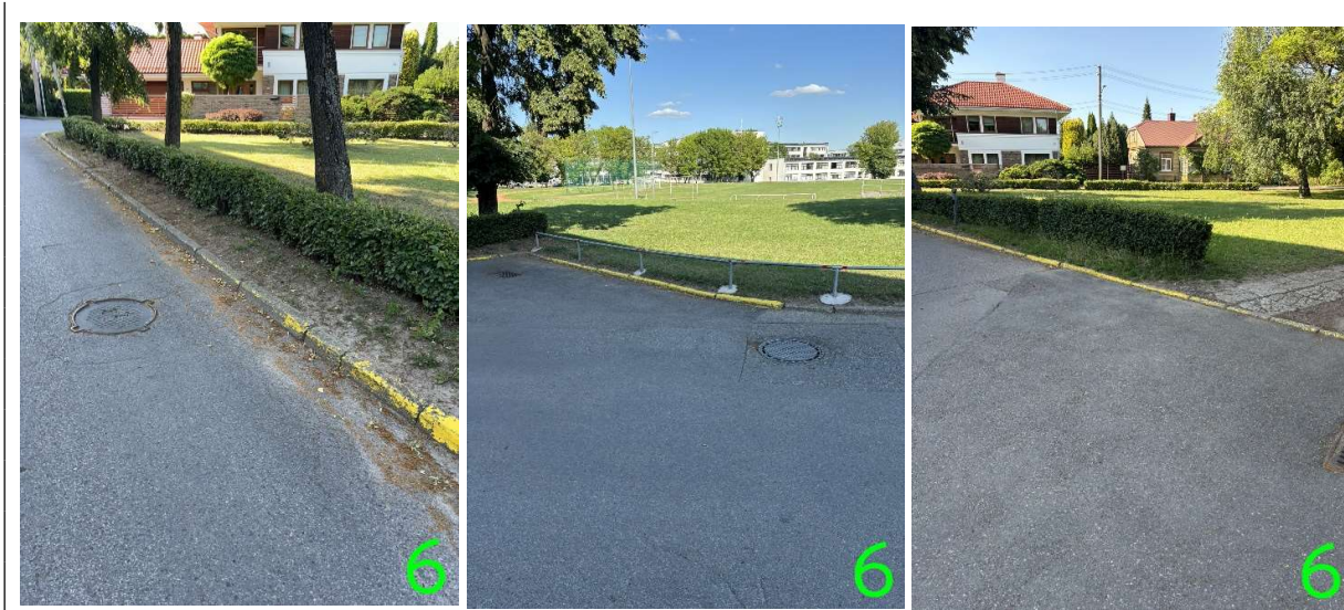
8 pav. atnaujinamų linijų ir ženklinių esamos būklės fotografacija
