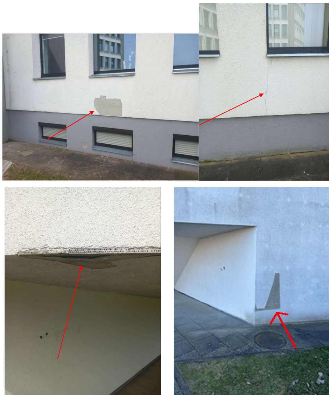
1 pav. fasado esamos būklės fotografacija
