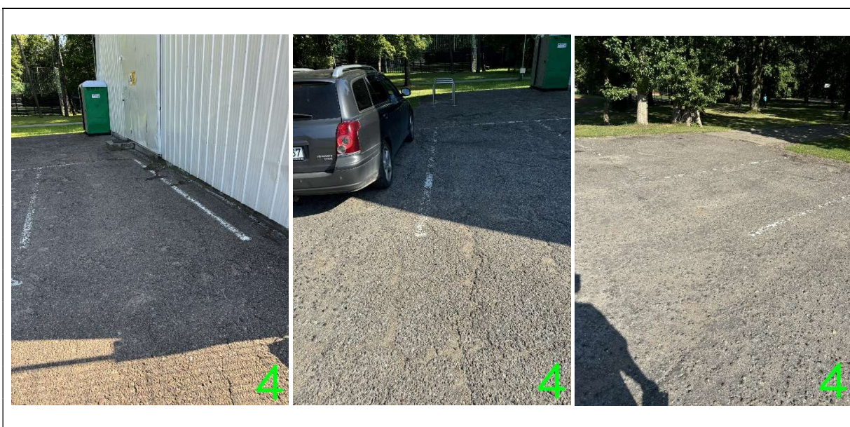
10 pav. atnaujinamų linijų ir ženklinių esamos būklės fotografacija
