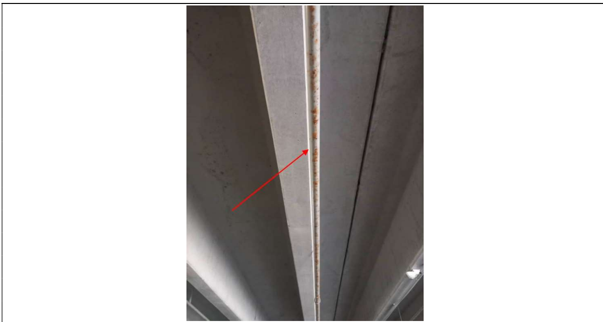
3 pav. metalinės konstrukcijos esamos būklės fotografacija
