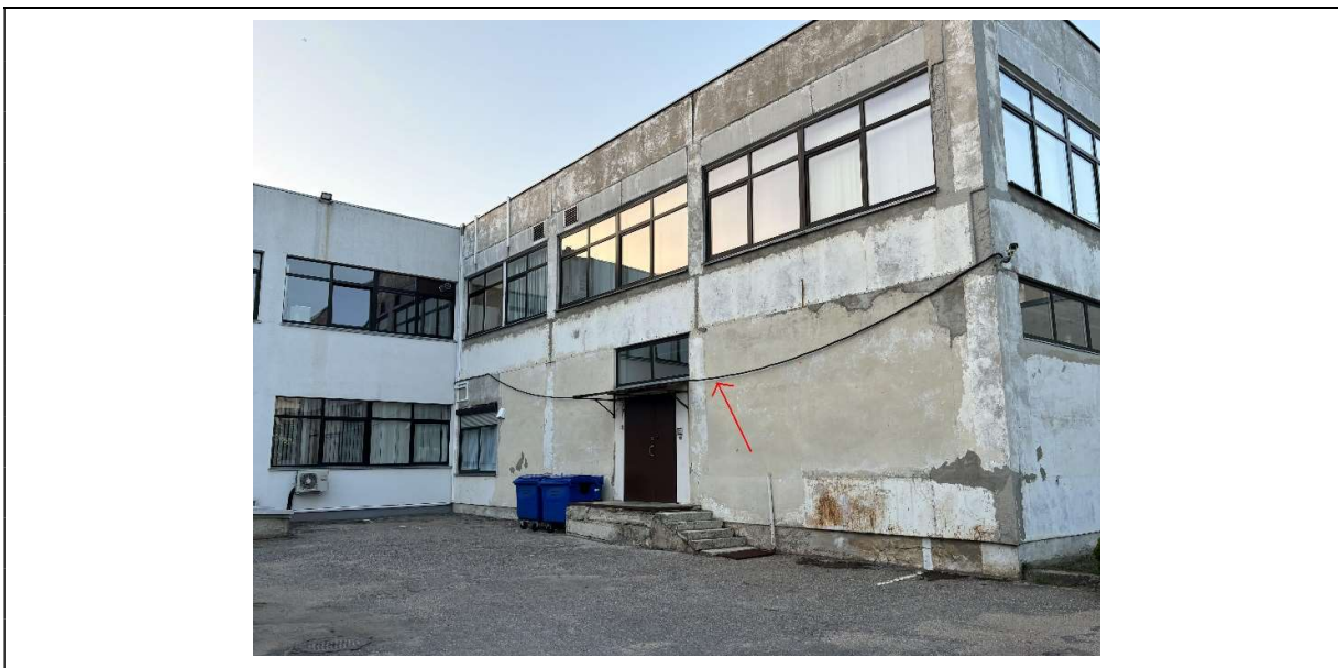
4 pav. kabančio laido esamos būklės fotografacija
