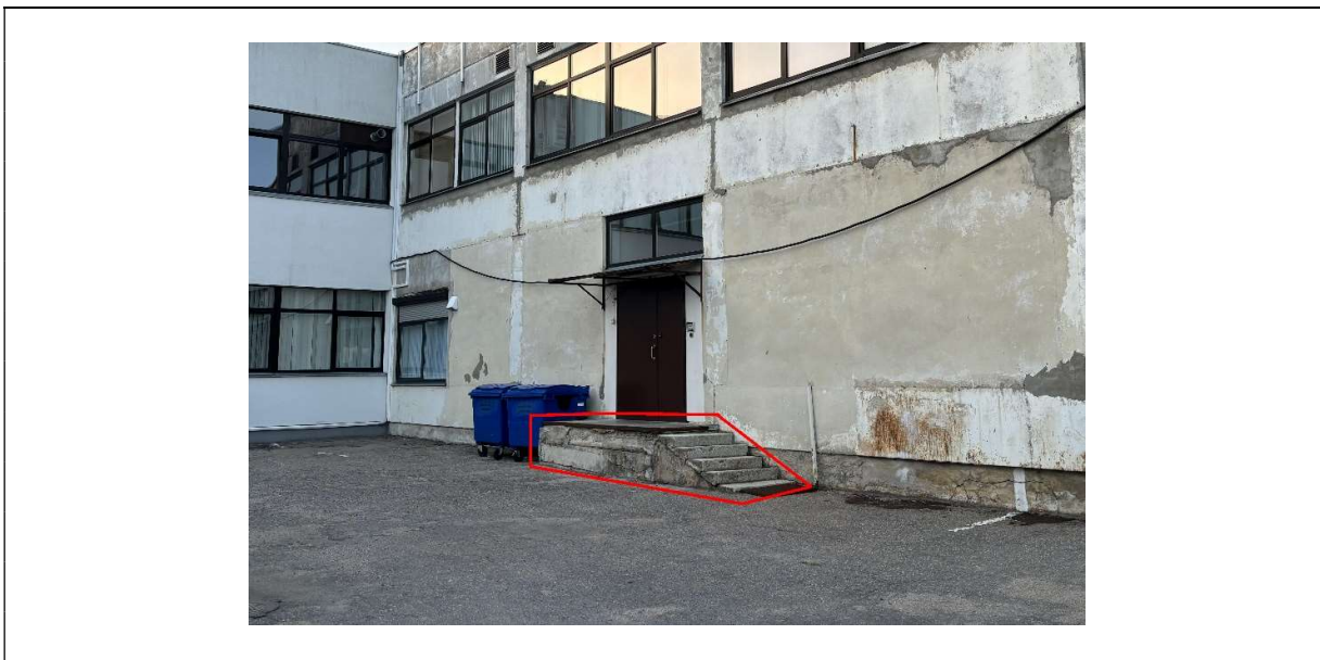
5 pav. lauko laiptų esamos būklės fotografacija
