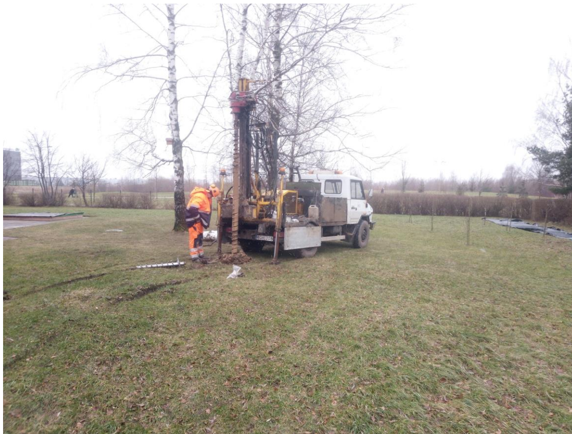
1 pav. Lauko darbai
