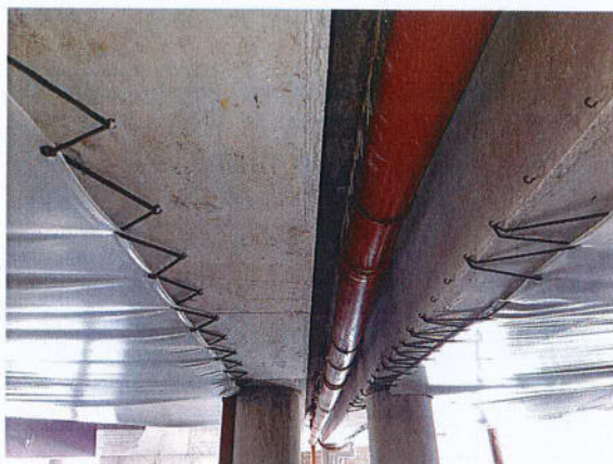
k) nesandari temperatūrinė deformacinė siūlė
