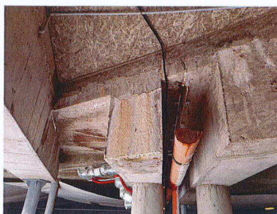
l) rūdija deformacinių siūlių metaliniai elementai
