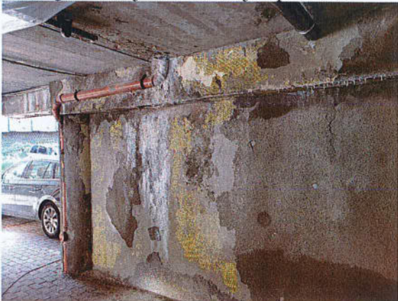
g) ašyje "17" parkingo sienos pažeistos drėgmės, įmirkusios
