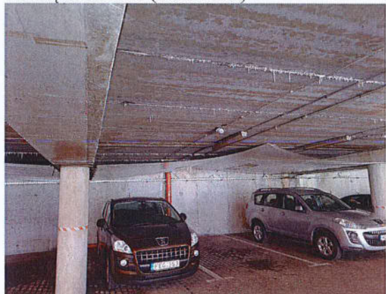
j) tuštymėtų plokščių paviršiuje susidariusios balkšvos kalkių nuosėdos, stalaktitai
