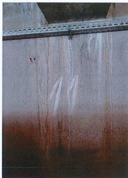
b) plyšiai atraminėje sienoje (ašių A/11 sankirta) perdangos sijos atrėmimo zonoje
