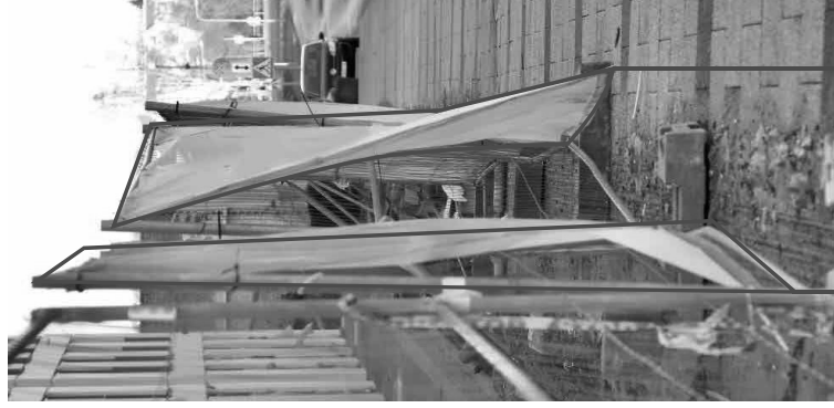
Netinkama medžiaga. Nėra vizualizacijos. Tvoros tvirtinimas išsikiša į pėsčiųjų zoną
