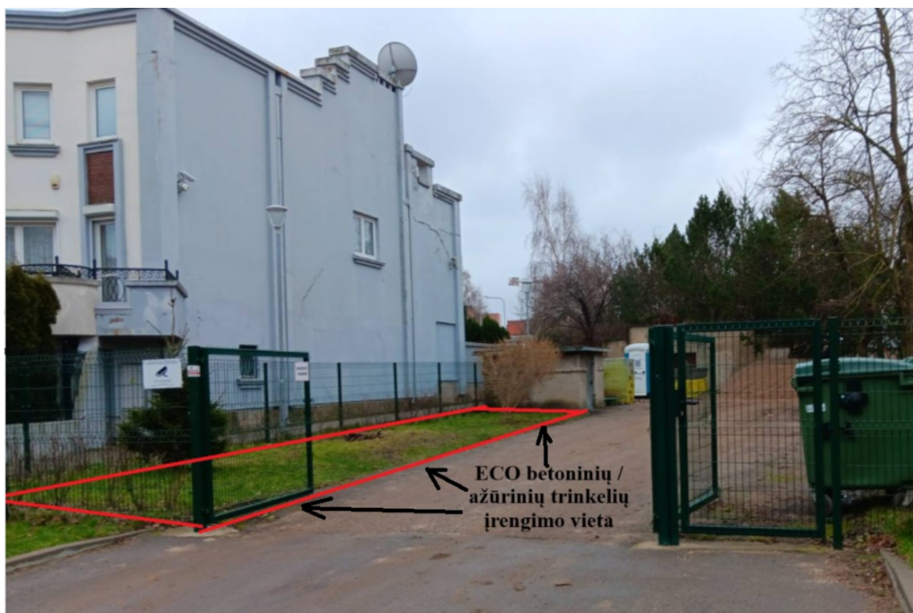
2 pav. ECO betoninių / azūrinių trinkelų įrengimo vieta
