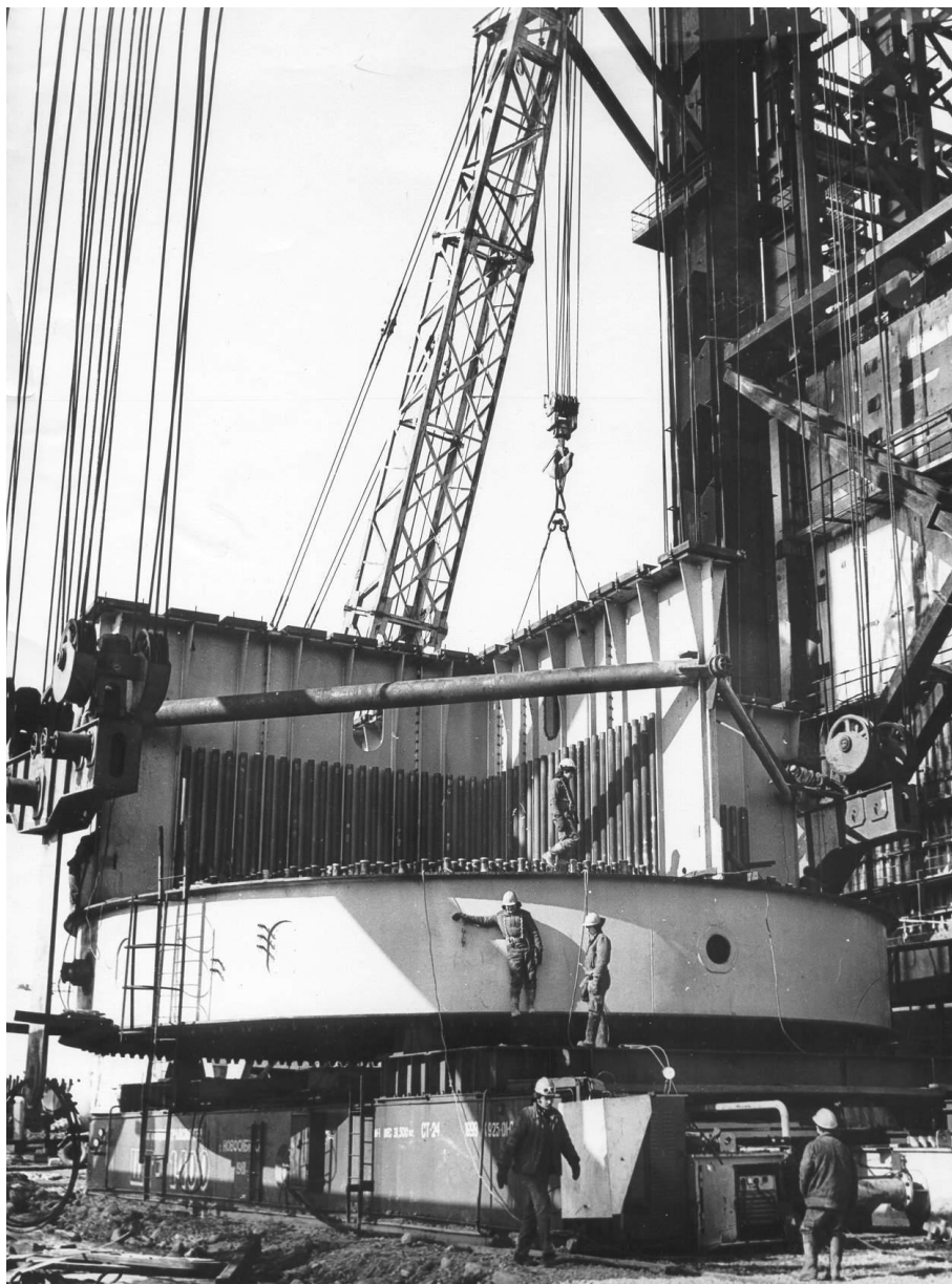
22 pav. „OR“ ir „C“ metalo konstrukcijų nuotrauka jų montavimo metu
