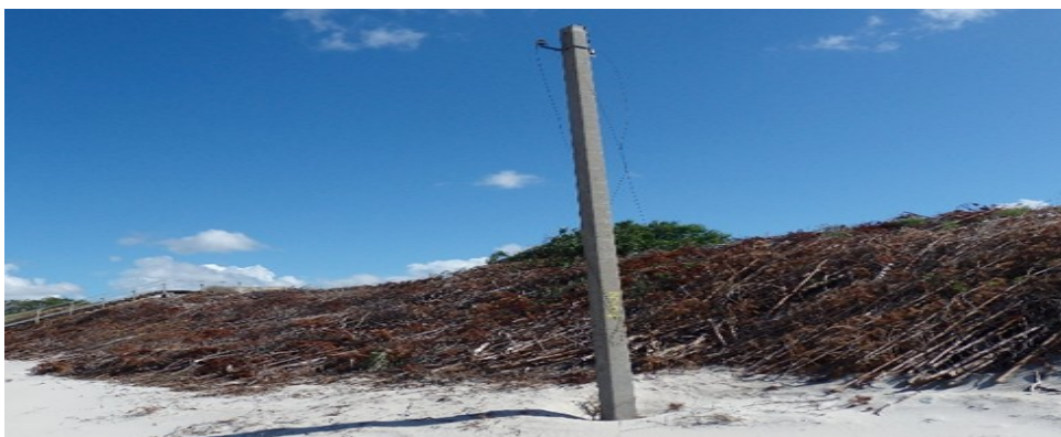
3 pav. Gelžbetoninių stulpų esančių Smiltynės paplūdimyje, Klaipėdoje, fotofiksacija
