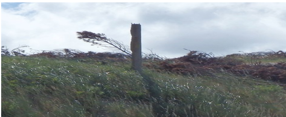
4 pav. Gelžbetoninių stulpų esančių Smiltynės paplūdimyje, Klaipėdoje, fotofiksacija
