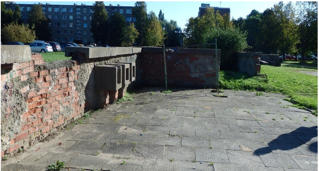
5 pav. Plytų mūro atitvarų, esančių Taikos pr. 103, Klaipėdoje, fotofiksacija
