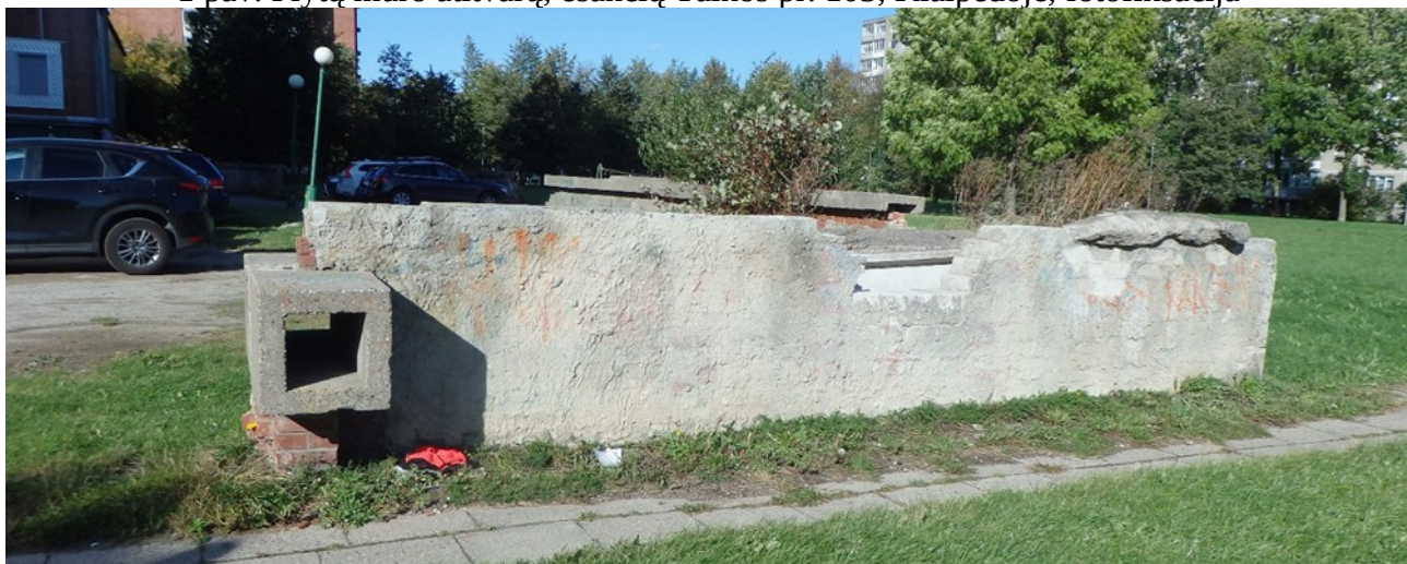
2 pav. Plytų mūro atitvarų, esančių Taikos pr. 103, Klaipėdoje, fotofiksacija
