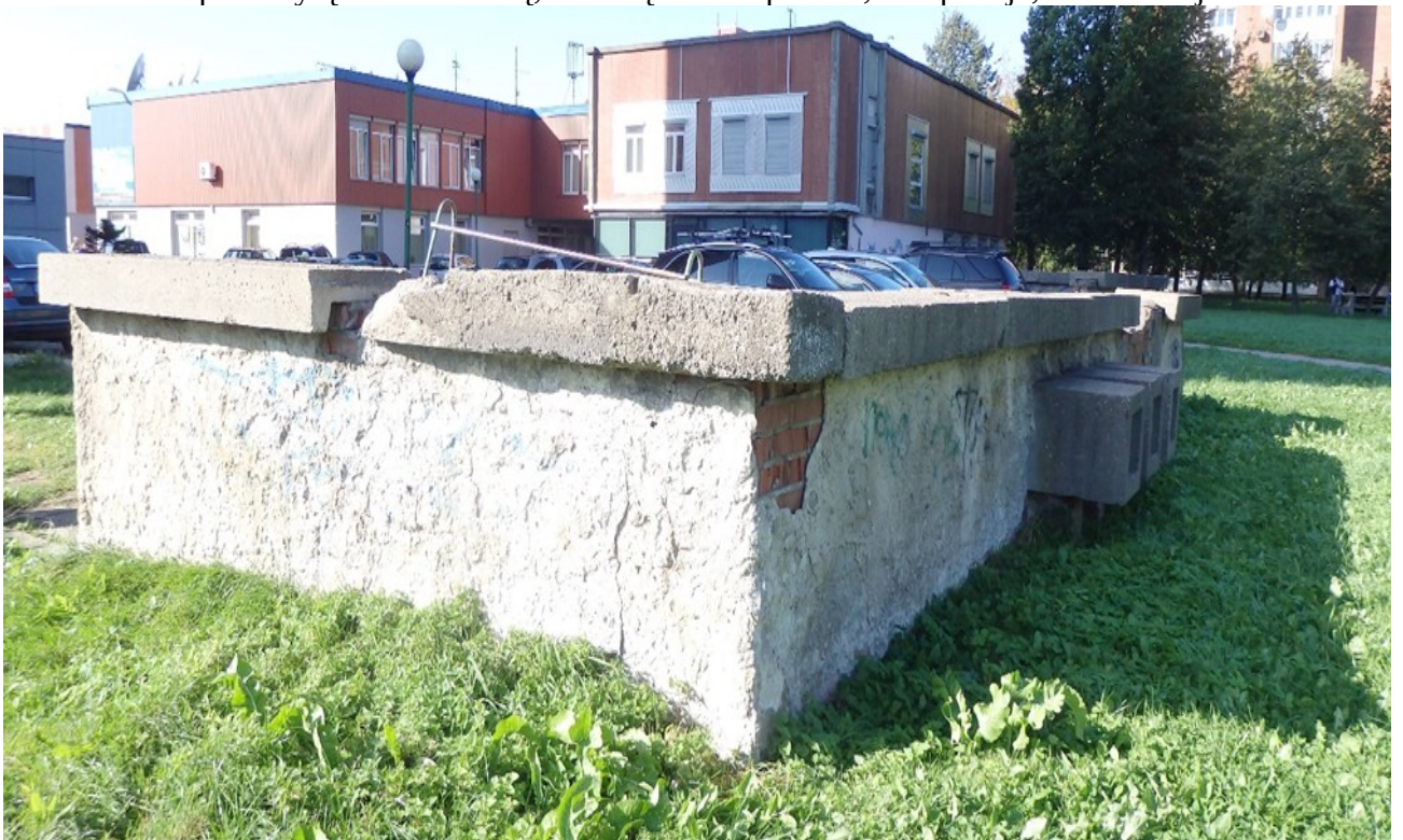
4 pav. Plytų mūro atitvarų, esančių Taikos pr. 103, Klaipėdoje, fotofiksacija
