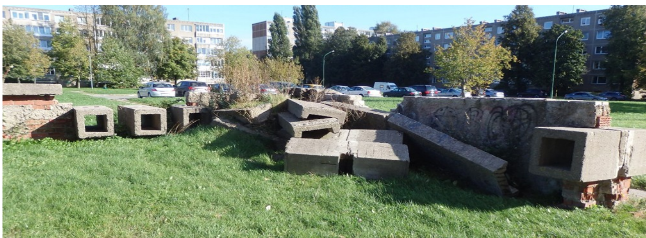
1 pav. Plytų mūro atitvarų, esančių Taikos pr. 103, Klaipėdoje, fotofiksacija
