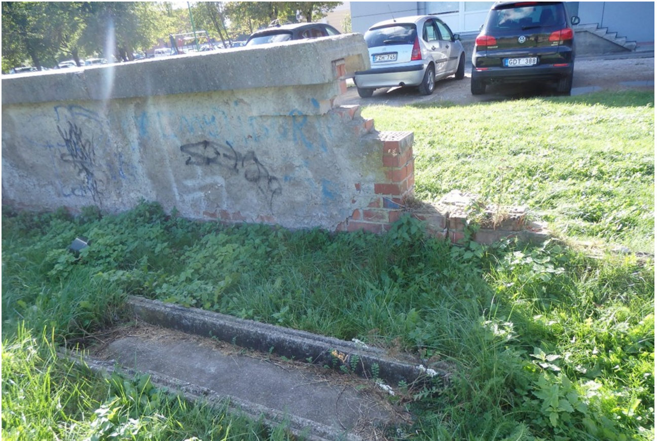
3 pav. Plytų mūro atitvarų, esančių Taikos pr. 103, Klaipėdoje, fotofiksacija
