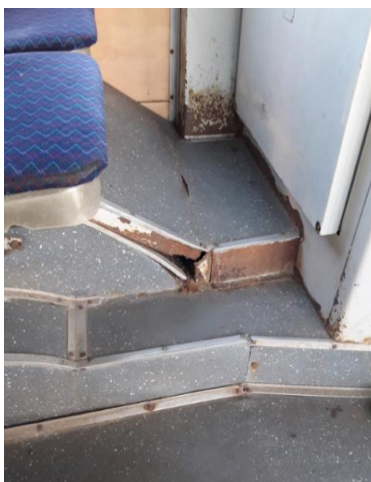
Transporto priemonės salono elementai paveikti korozijos, netvarkingi, blogos estetinės būklės
