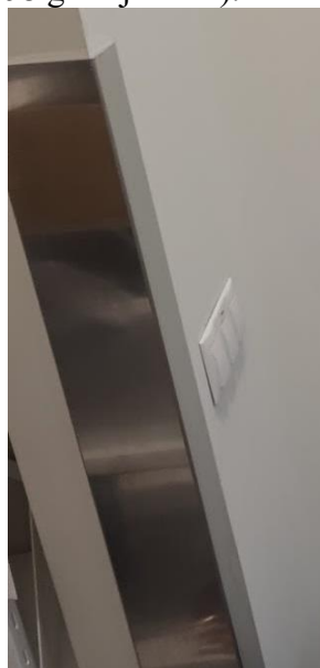
17 pav. Išorinių kampų aptaisymas metaliniais kampuočiais
