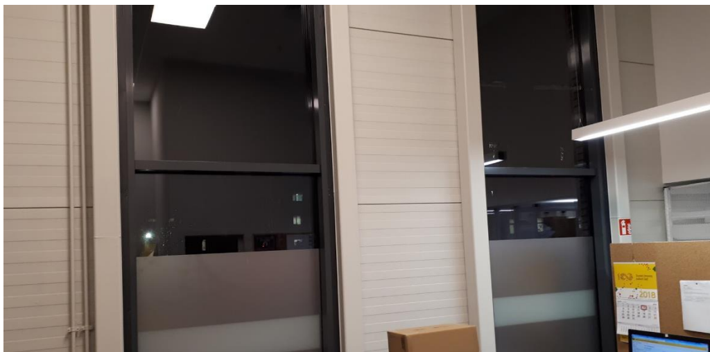
18 pav. „Sandwich“ tipo, daugiasluoksnių plokščių apdaila
