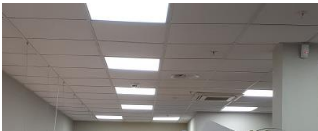
31 pav. šviestuvas montuojamas į segmentines lubas, kvadratinis
