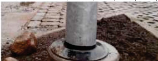
Apšvietimo atramos pamato ir pamato apsauginės gumos vaizdas
