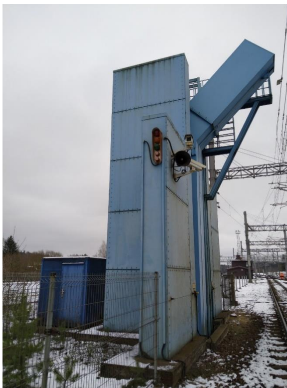
Gelžbetonio konstrukcijos (bokštas). (Metalų konstrukcija, gelžbetonio pamatai, ant išorinės konstrukcijos sienos sumontuoti vaizdo stebėjimo ir rentgeno kontrolės valdymo elementai, konstrukcijos sienų tarpai pripildyti smėlio). (Techninės specifikacijos 3.1.8 p)
