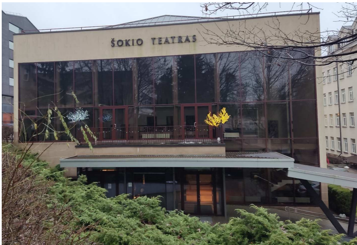
7 pav. Šiaurės-rytų fasadas
