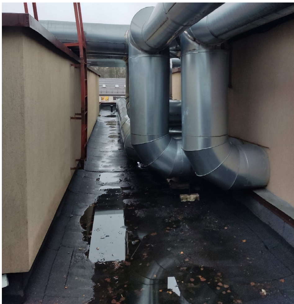
9 pav. Plokščiojo stogo su netinkamai suformuotais nuolydžiais fragmentas
