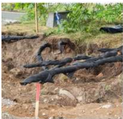
Medžio šaknų nuo 5cm Ø aprišimas geotekstile.
