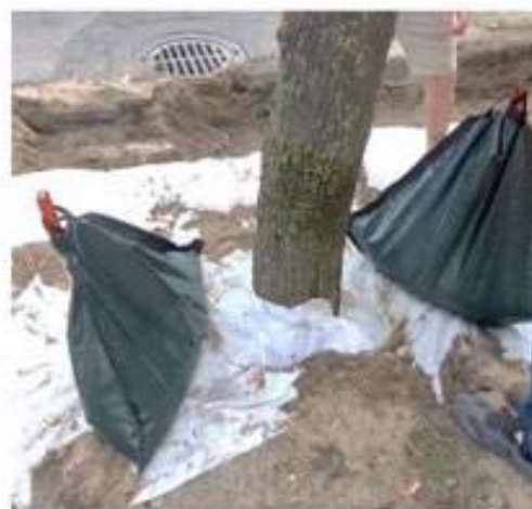
Medžio šaknų dengimas geotekstile ir nuolatinio laistymo užtikrinimas.
