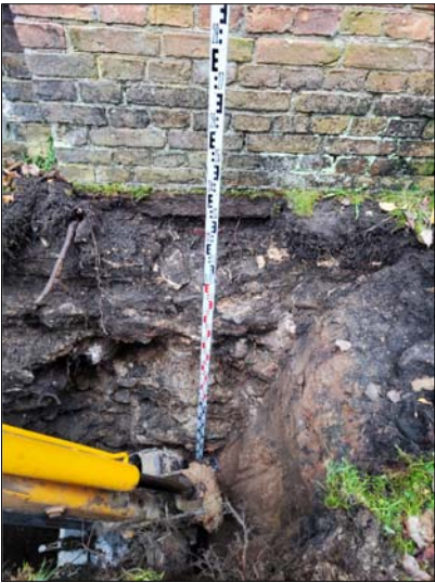
1. pav. Pastato pamatai šurfe ŠR. 1.
