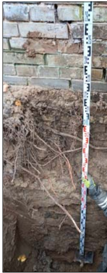
3. pav. Pastato pamatai šurfe ŠR. 3.
