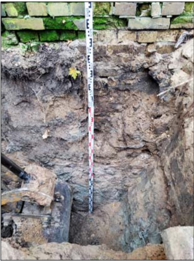
2. pav. Pastato pamatai šurfe ŠR. 2.
