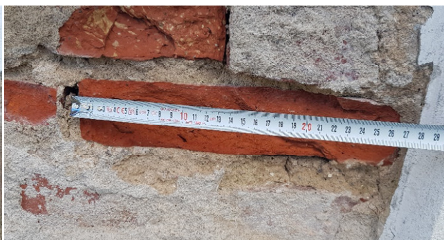
FF-13. V fasado fragmentas: nutrupėjęs tinkas, atsidengęs plytų mūras I tarpsnio nišoje
