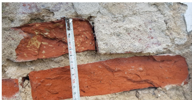
FF-12. V fasado fragmentas: nutrupėjęs tinkas, atsidengęs plytų mūras I tarpsnio nišoje
