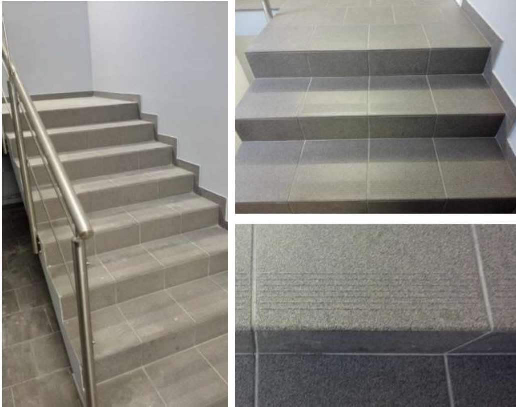
Laiptinės su akmens masės plytelių danga įrengimo pavyzdys. Pakopų apklijavimas plytelėmis.
