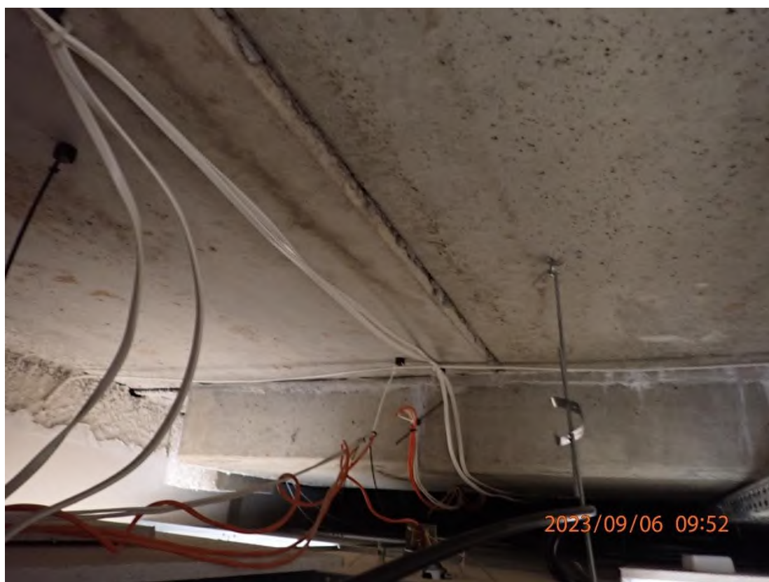
Nuotrauka Nr. 2. Pastato denginio konstrukcijų vaizdas
