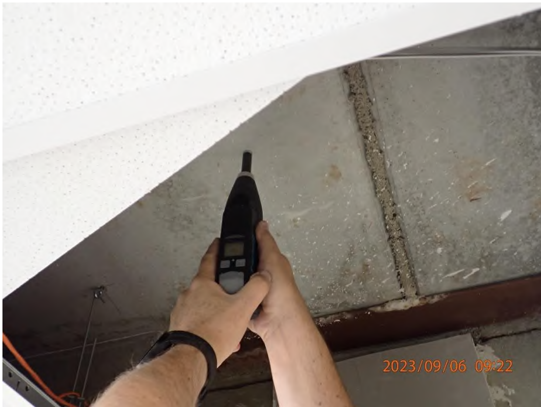
Nuotrauka Nr. 5. Denginio plokščių betono stiprio nustatymas
