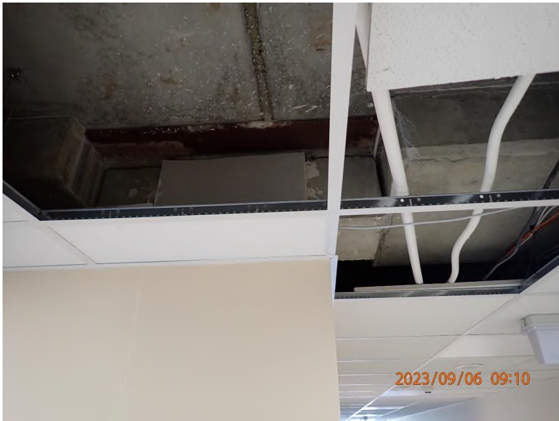
Nuotrauka Nr. 3. Pastato denginio konstrukcijų vaizdas
