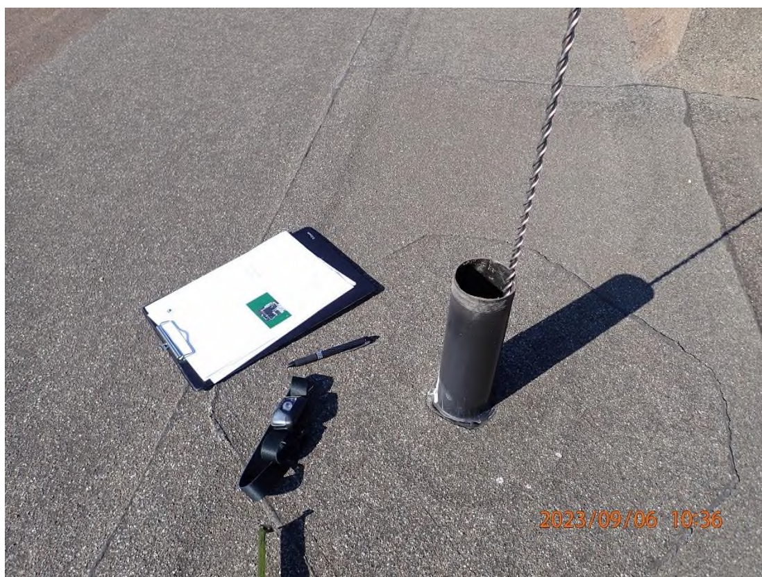
Nuotrauka Nr. 8. Stogo konstrukcijos sluoksnių nustatymas
