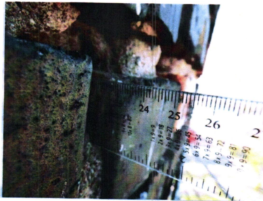
Viršūnės mūras įtrūkės 2 vnt. vertikaliais įtrūkiais 1,0-1,7 m ilgio, 2-10 mm pločio.
