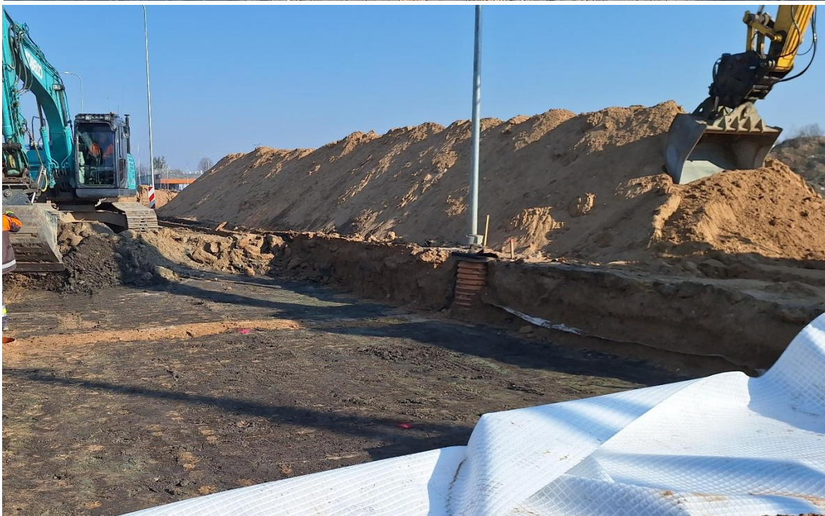
Ipav. Iškasus esamus pagrindus iki projektinės altitudės, nuo Pk 1+90 iki Pk 2+40, rastas vidutiniškai 15 cm storio juodžemio sluoksnis
