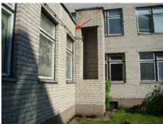
16. Nuo pastato iki 10 mm pasviręs priestatas ties ašimis 4-E
