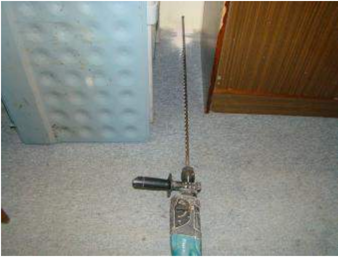
23. Vėdinimo šachtų sienose tyrimas 4-to aukšto patalpoje nr. 4-96
