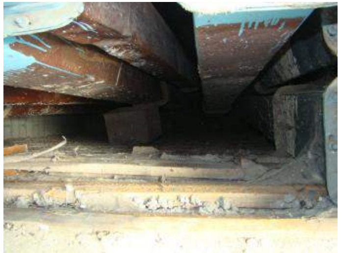
26. Nuotraukoje nr. 25 fiksuota šachta 5-to aukšto patalpoje 5-105
