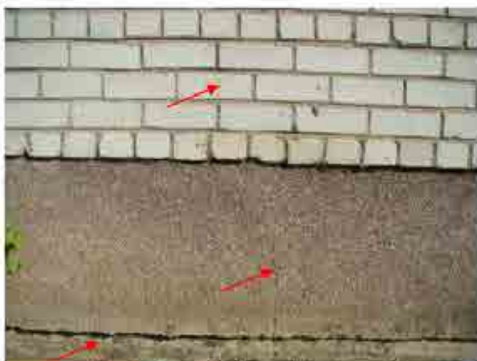
7. Įtrūkinimas sienoje; nusėdusi nuogrinda
