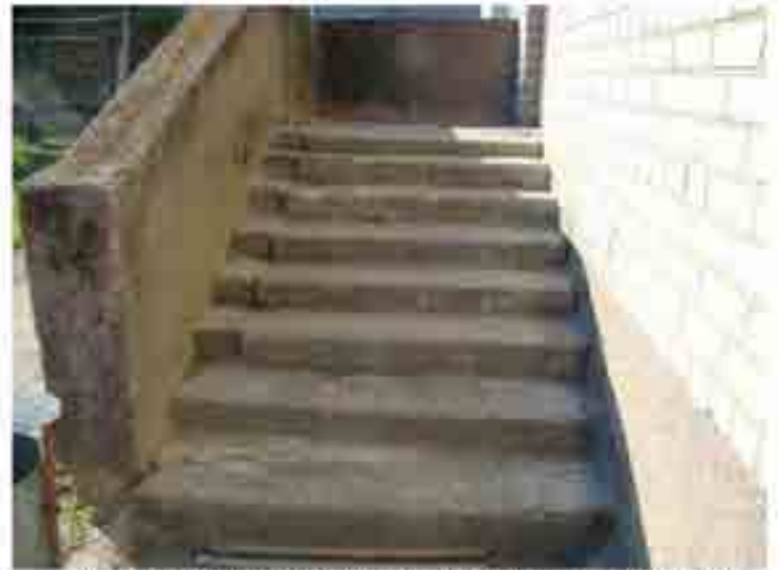
18. Laiptų pakopos nelygios, aptrupėjusios, nevientisos, neįrengtas porankis
