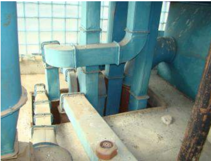
25. Šachta 5-to aukšto patalpoje 5-105
