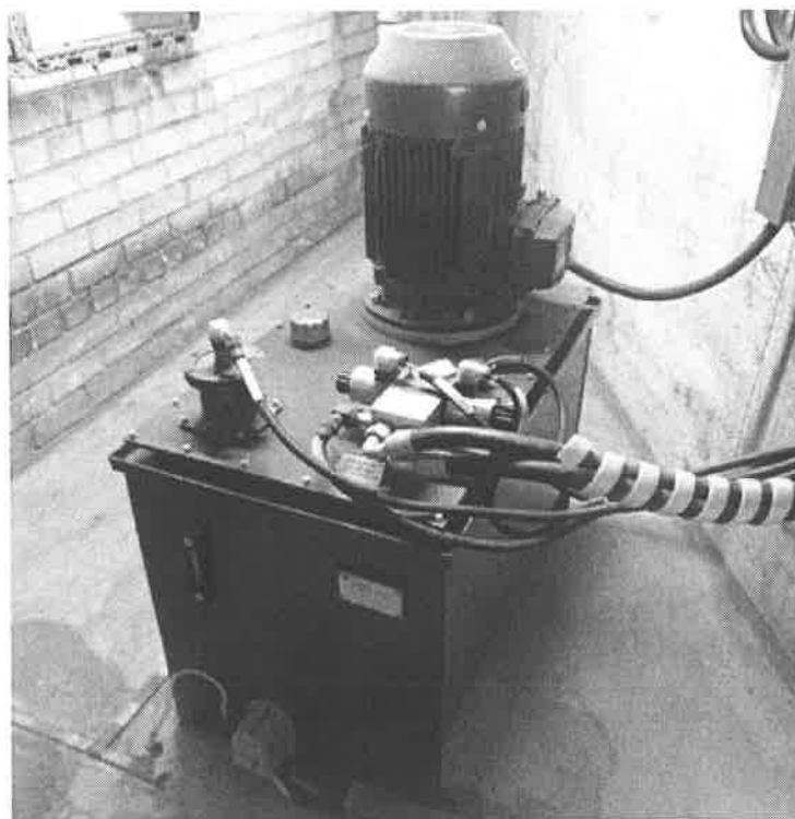
5 pav. BVŠK-2 biokuro sandėlio Nr.2 hidrostatas Nr. 1
