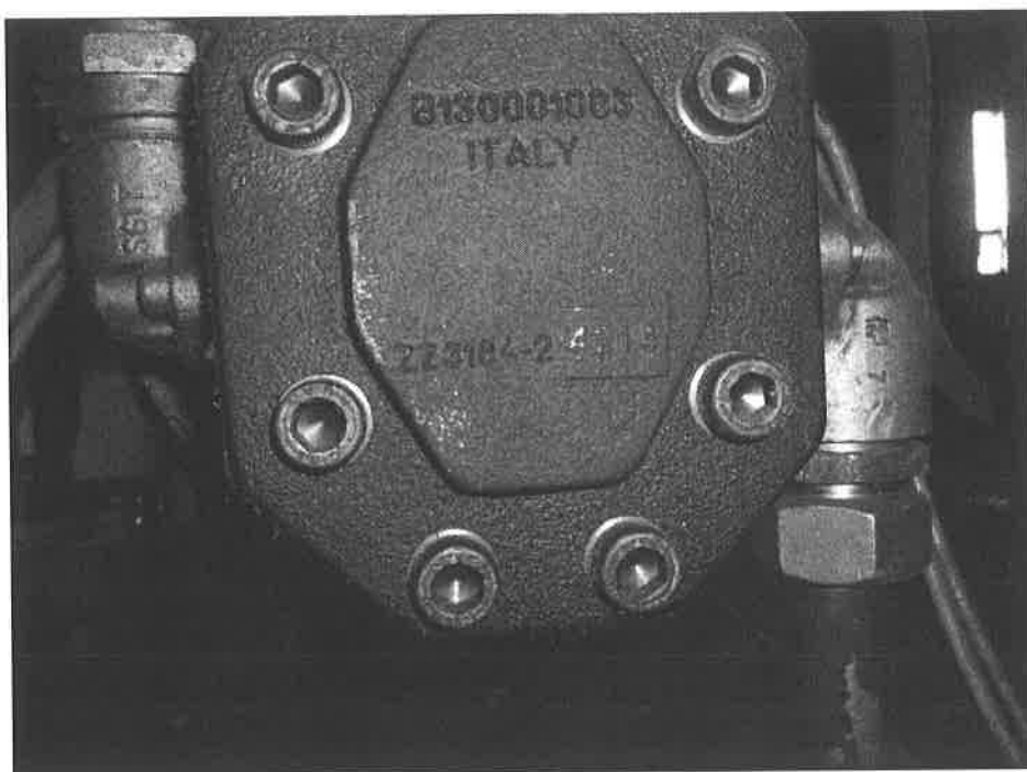
2 pav. Biržų filialo katilo VŠK-2 kuro hidrosiurblys
