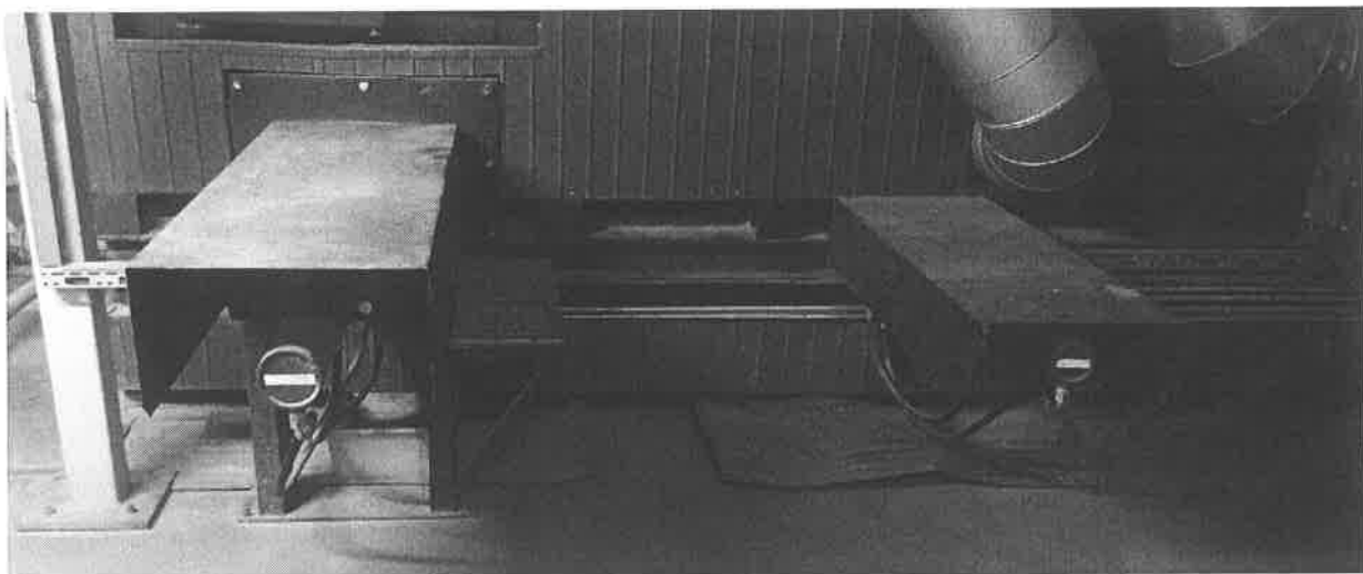
6 pav. Druskininkų filialo katilų BVŠK-4, BVŠK-1 pelenų iš pakuros išstūmimo cilindrai viso 8 vienetų
