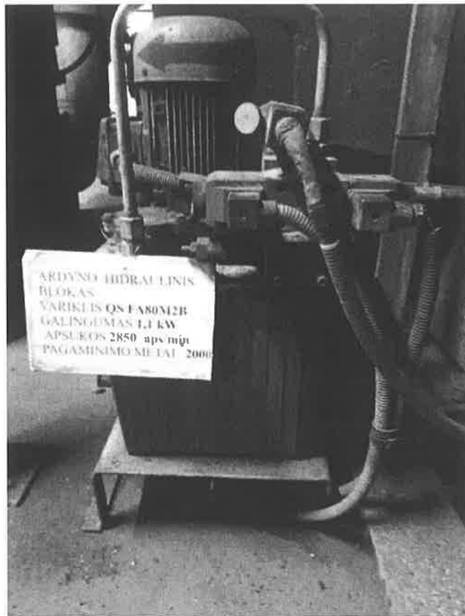
3 pav. Kelmės filialo katilo BVŠK-7 ardyno hidraulinė stotis. Variklio galingumas 1,1 kW apsukos 2850 aps/min
