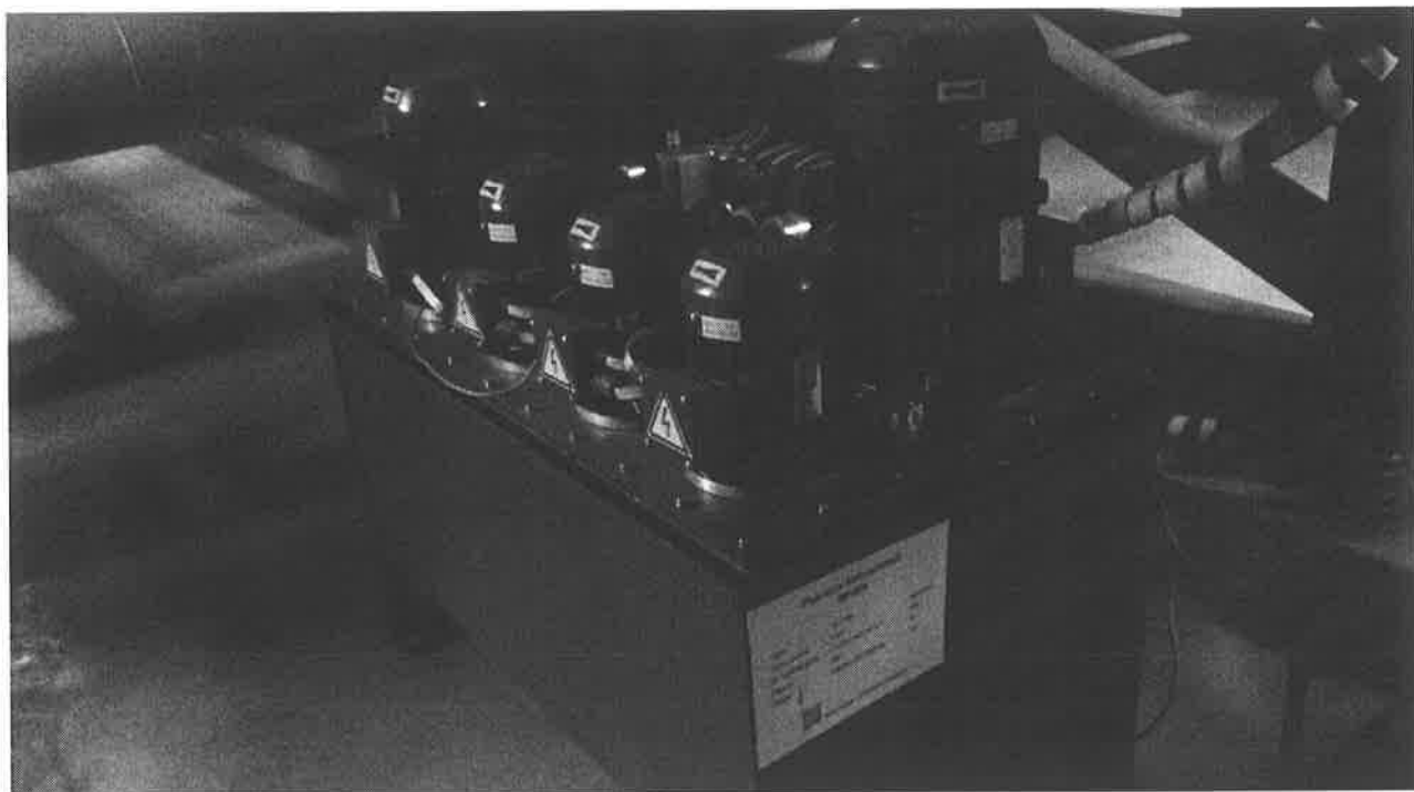
4 pav. Druskininkų filialo katilo BVŠK-4 pakuros hidrostotis. Tipas 19-390. Elektros variklių galingumas: 11; 1,1; 1,1; 0,75; 2,2 kW slėgis 100/100/100/100/100 bar (5 hidrosiurbiai)
