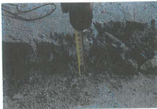
2 pav. Grindų konstrukcijos sluoksniai ant perdangos
