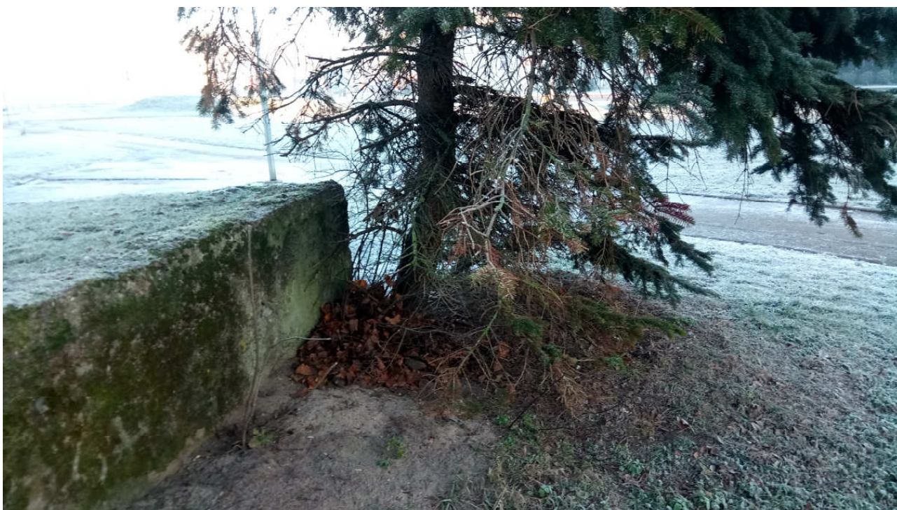
Atraminės sienelės rytų pusės vaizdas.
