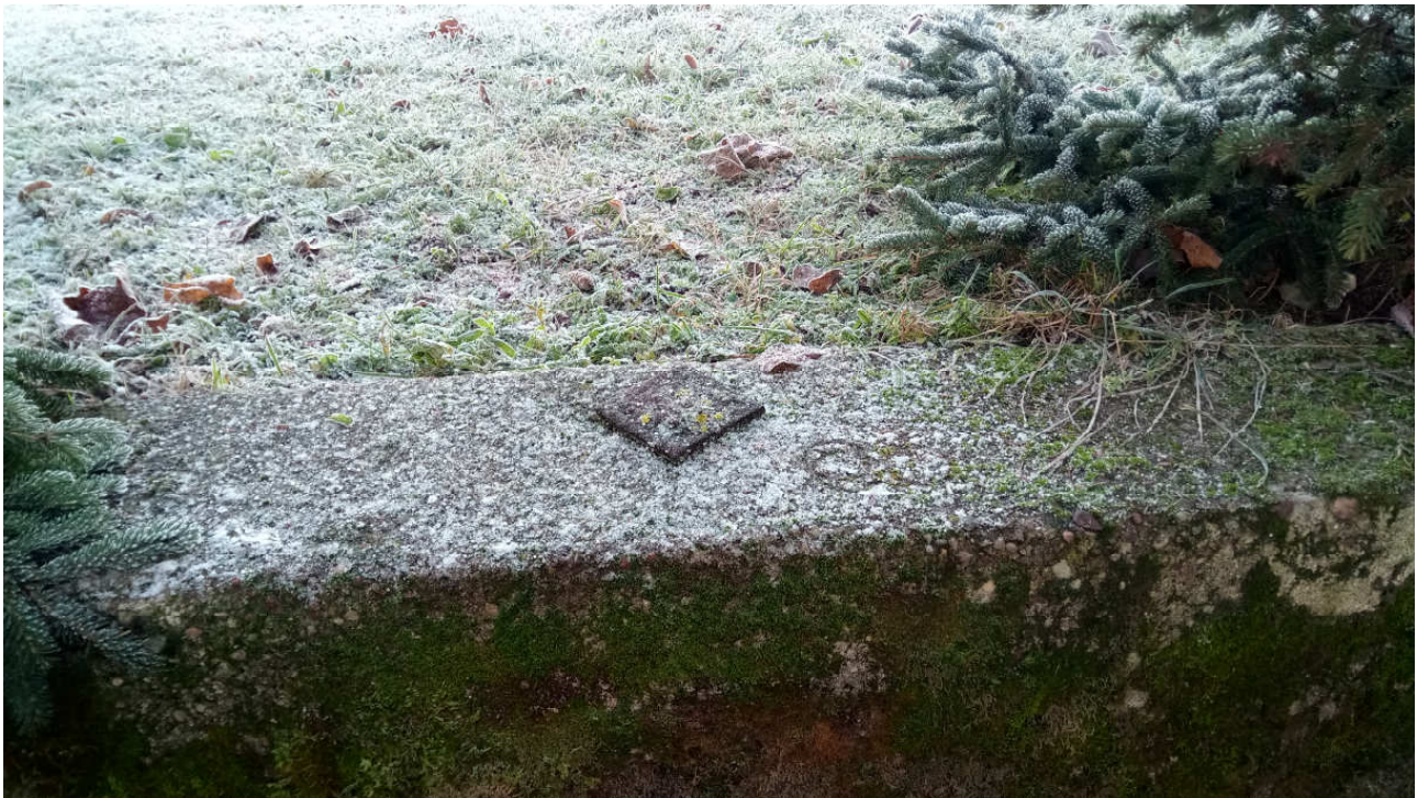
Atraminės sienutės rytų pusės vaizdas. Matomas buvusios tvorelės tvirtinimo elementas.
