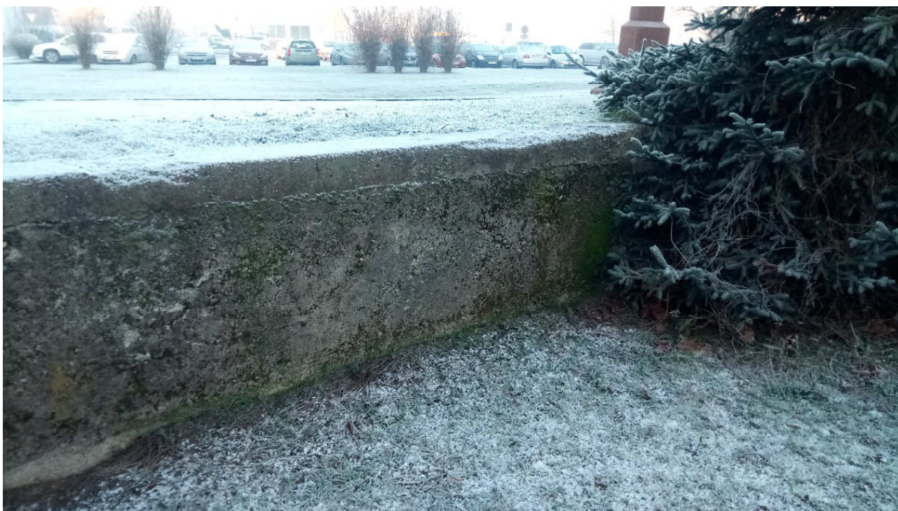
Atraminės sienelės rytų pusės vaizdas.
