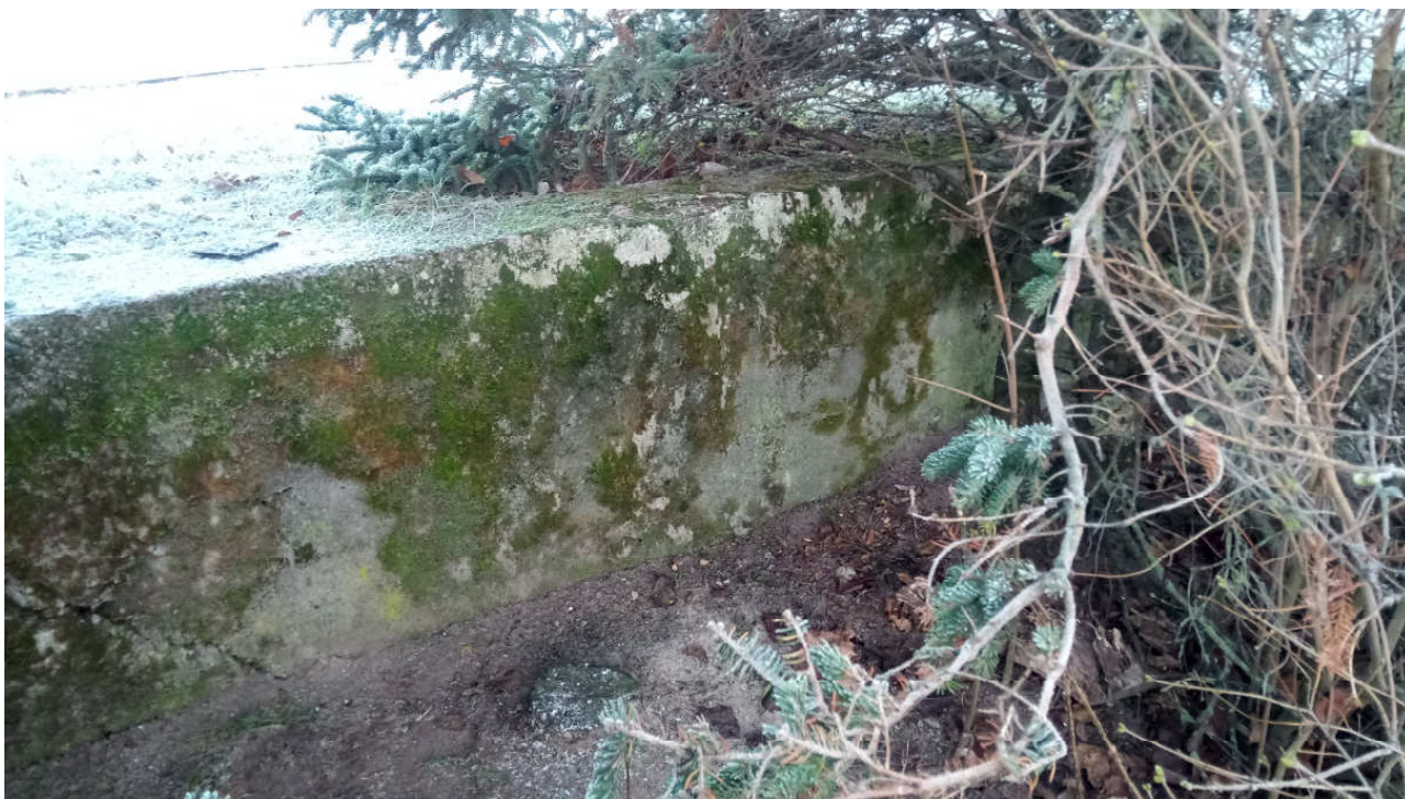
Atraminės sienelės rytų pusės vaizdas.
