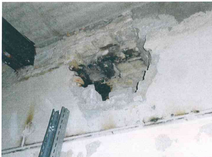
11 pav. Atidengta tuštuma mūre.
