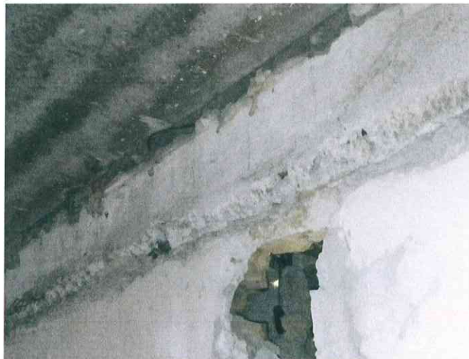
12 pav. Atidengta tuštuma mūre.
