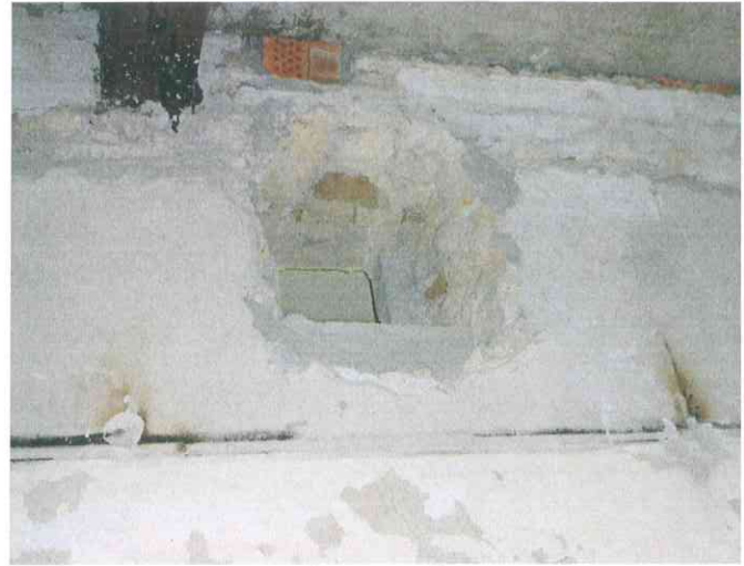
4 pav. Atidengta tuštuma mūre.
