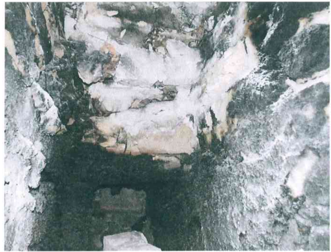
6 pav. Tuštuma mūre iš vidaus.
