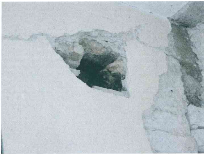
5 pav. Atidengta tuštuma mūre.
