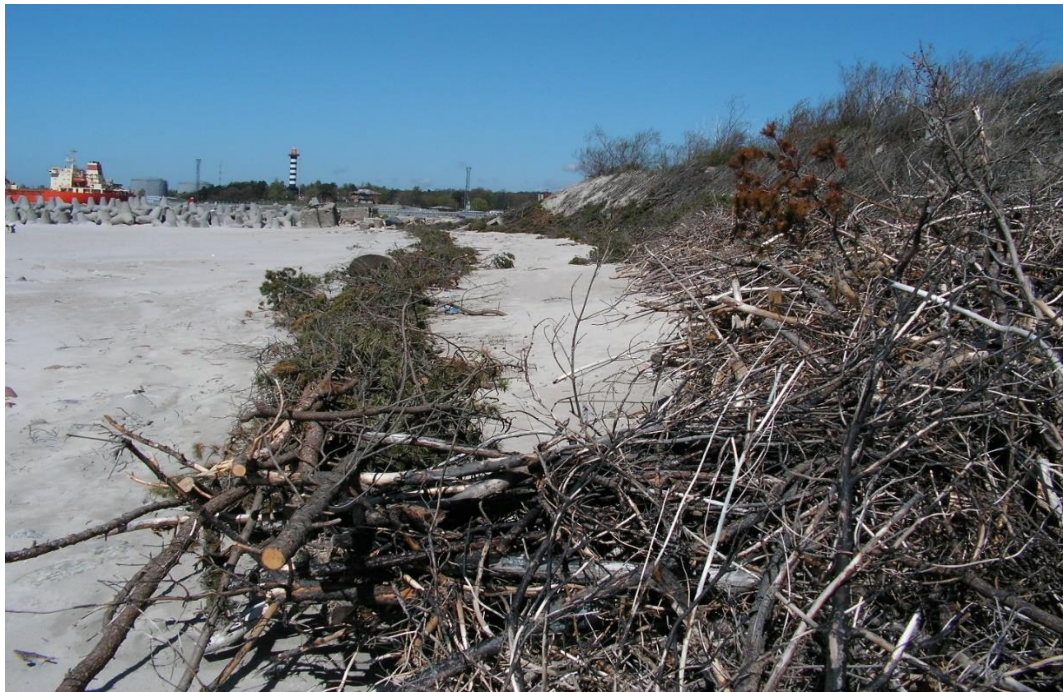
3.4 pav. Kopagūbrio tvirtinimo šakų volu ties Kopgaliu pavyzdys.
