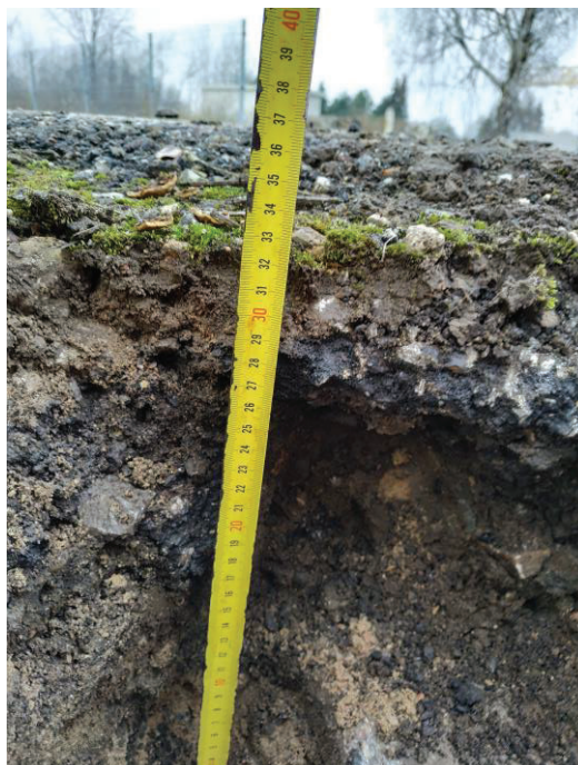
2 pav. Asfaltbetonio dangos storis 10 cm
