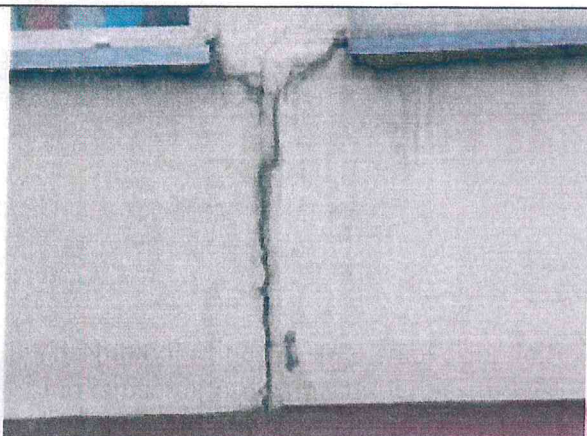
Pav. 5 Sutrūkinėjusios panelių jungimosi siūlės, vietomis išbyrėjęs tinkas. Per siūles į keletą grupių prasiskverbia vanduo.
