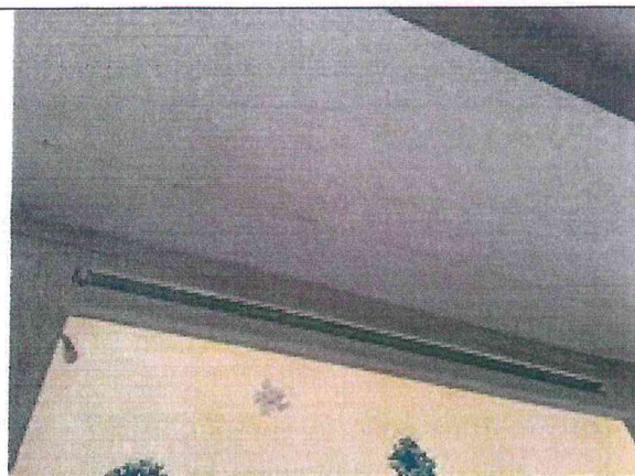
Pav. 36 Laiptinėse ir grupėse, sutrūkinėjusios virš lango esančių sąramų siūlės.
