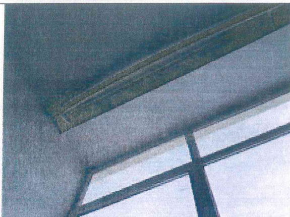
Pav. 31 Laiptinėse ir grupėse, sutrūkinėjusios virš lango esančių sąramų siūlės.
