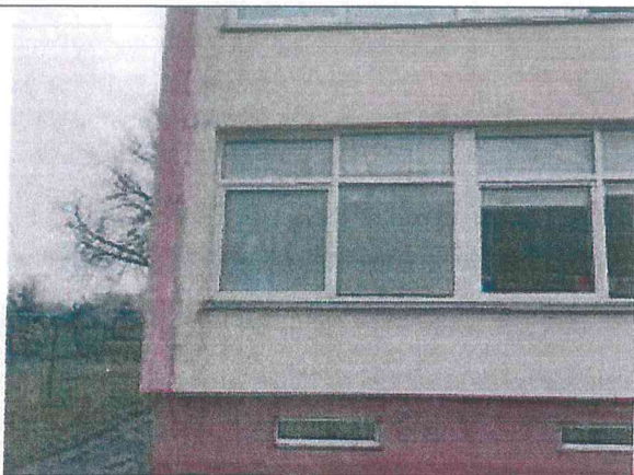
Pav. 7 Sutrūkinėjusios panelių jungimosi siūlės, vietomis išbyrėjęs tinkas. Per siūles į keletą grupių prasiskverbia vanduo.
