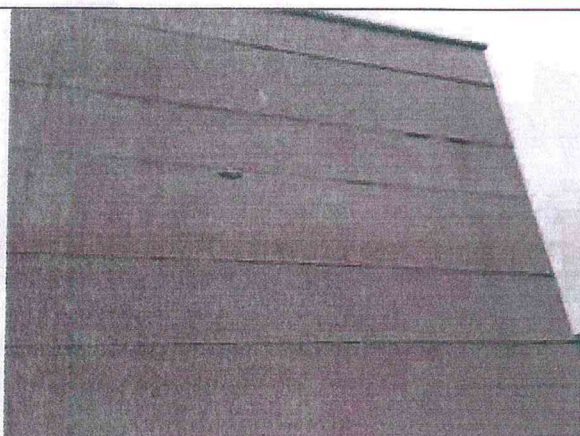
Pav. 9 Sutrūkinėjusios panelių jungimosi siūlės, vietomis išbyrėjęs tinkas. Per siūles į keletą grupių prasiskverbia vanduo.
