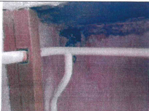
Pav. 17 Į keletą grupių, per sieninių panelių jungimosi vietas, prasiskverbia vanduo.
