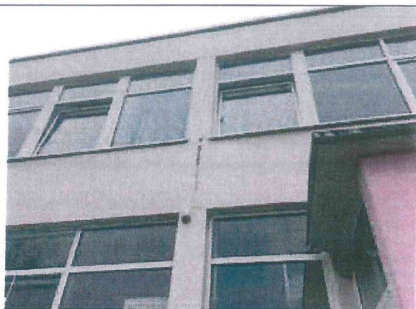
Pav. 8 Sutrūkinėjusios panelių jungimosi siūlės, vietomis išbyrėjęs tinkas. Per siūles į keletą grupių prasiskverbia vanduo.
