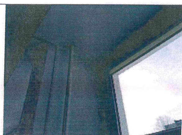
Pav. 28 Keletoje grupių ir kabinetų, ties langų kraštais prasiskverbia vanduo.
