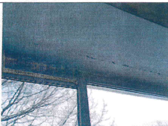
Pav. 33 Laiptinėse ir grupėse, sutrūkinėjusios virš lango esančių sąramų siūlės.
