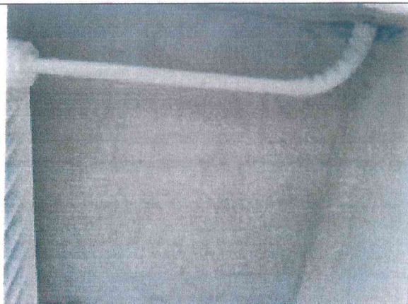
Pav. 20 Į keletą grupių, per sieninių panelių jungimosi vietas, prasiskverbia vanduo.
