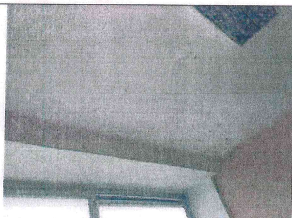
Pav. 29 Keletoje grupių ir kabinetų, ties langų kraštais prasiskverbia vanduo.
