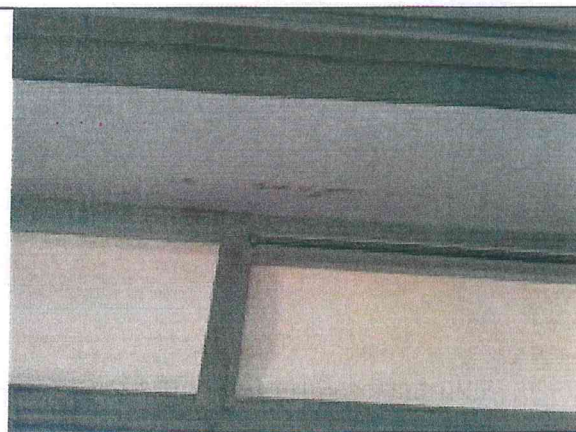
Pav. 34 Laiptinėse ir grupėse, sutrūkinėjusios virš lango esančių sąramų siūlės.
