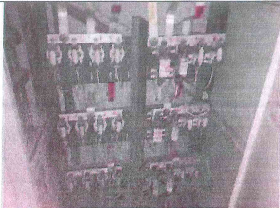
Pav. 55 El. skydinėje ant saugiklio uždėta viela, esant didesniai apkrovai gali kilti gaisras. Skirstomuosiuose el. skydeliuose dalis automatinų jungiklių seni, dalis instaliacijos likusi sena.
