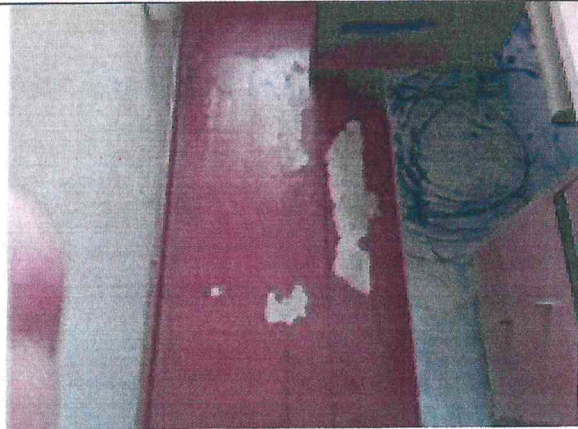
Pav. 42 Viename kabinete, nuo medinių grindų paviršiaus atšokę dažai.
