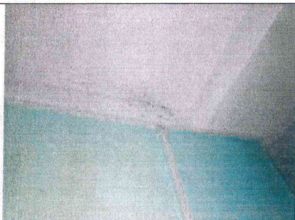
Pav. 23 Grupėje Nr. 9, prie elektros laidų sujungimo dėžutės sudrėkusi siena.
