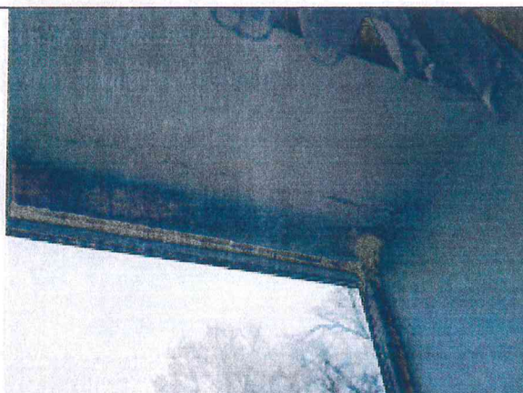
Pav. 35 Laiptinėse ir grupėse, sutrūkinėjusios virš lango esančių sąramų siūlės.
