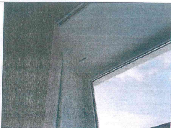
Pav. 25 Keletoje grupių ir kabinetų, ties langų kraštais prasiskverbia vanduo.
