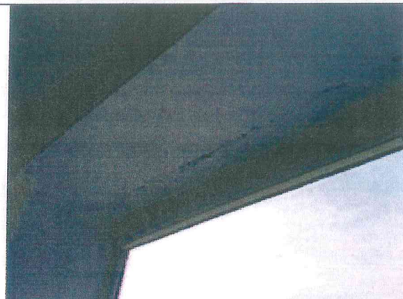
Pav. 32 Laiptinėse ir grupėse, sutrūkinėjusios virš lango esančių sąramų siūlės.
