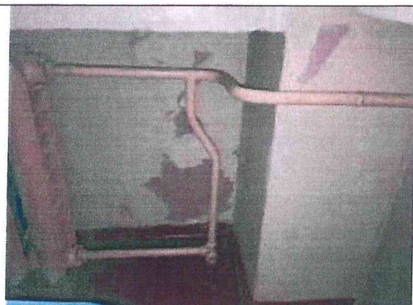
Pav. 18 Į keletą grupių, per sieninių panelių jungimosi vietas, prasiskverbia vanduo.
