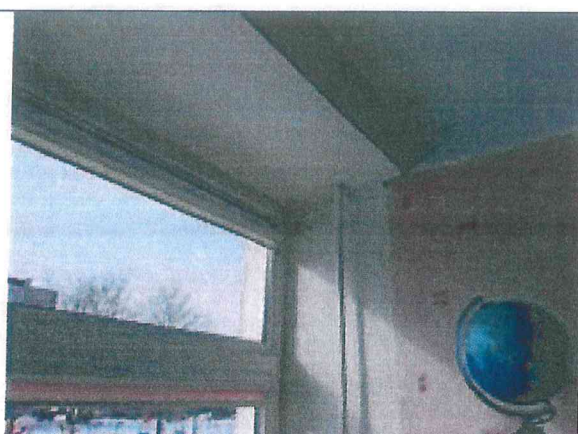
Pav. 26 Keletoje grupių ir kabinetų, ties langų kraštais prasiskverbia vanduo.
