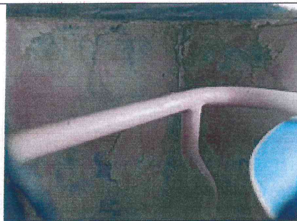
Pav. 22 Į keletą grupių, per sieninių panelių jungimosi vietas, prasiskverbia vanduo.
