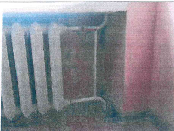
Pav. 19 Į keletą grupių, per sieninių panelių jungimosi vietas, prasiskverbia vanduo.
