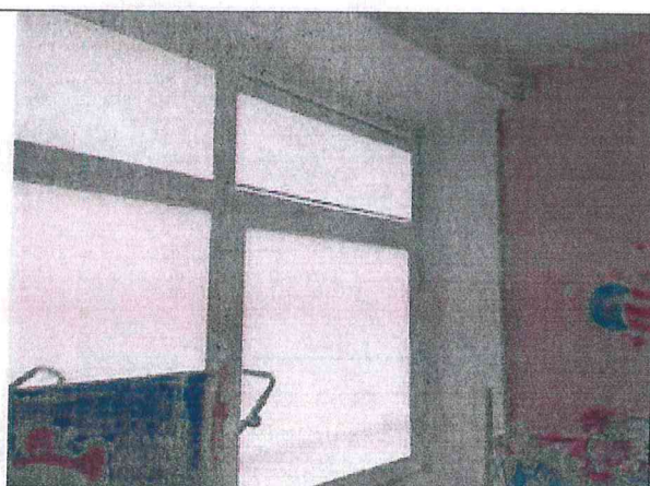
Pav. 27 Keletoje grupių ir kabinetų, ties langų kraštais prasiskverbia vanduo.
