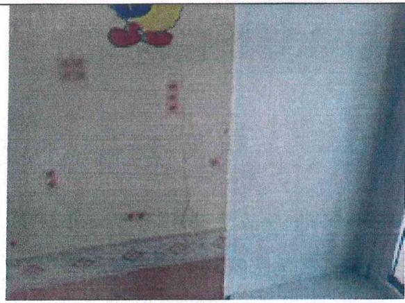
Pav. 24 Vertikaliai įtrūkusi grupės Nr. 2 siena.
