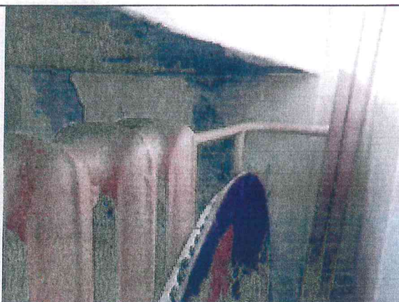
Pav. 21 Į keletą grupių, per sieninių panelių jungimosi vietas, prasiskverbia vanduo.
