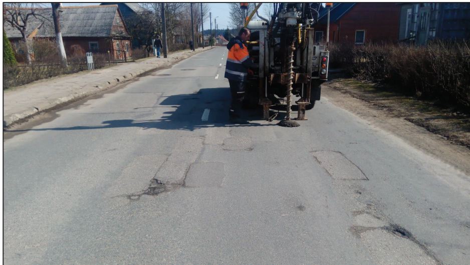
Nuotrauka 1. Gręžimo agregatas H-20SR tyrimų taške Nr. 2. Čia gatvės dangos būklė prasta abiejose gatvės usėse (D. Grigaliūno nuotrauka)
