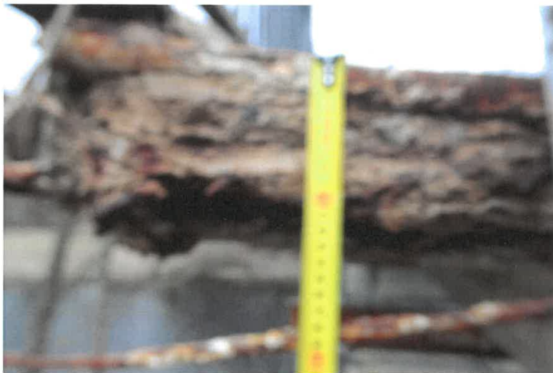
Pav. 25 Galinės sijos stipriai pažeistos konsolės betono pažaidos dėl armatūros intensyvios korozijos
