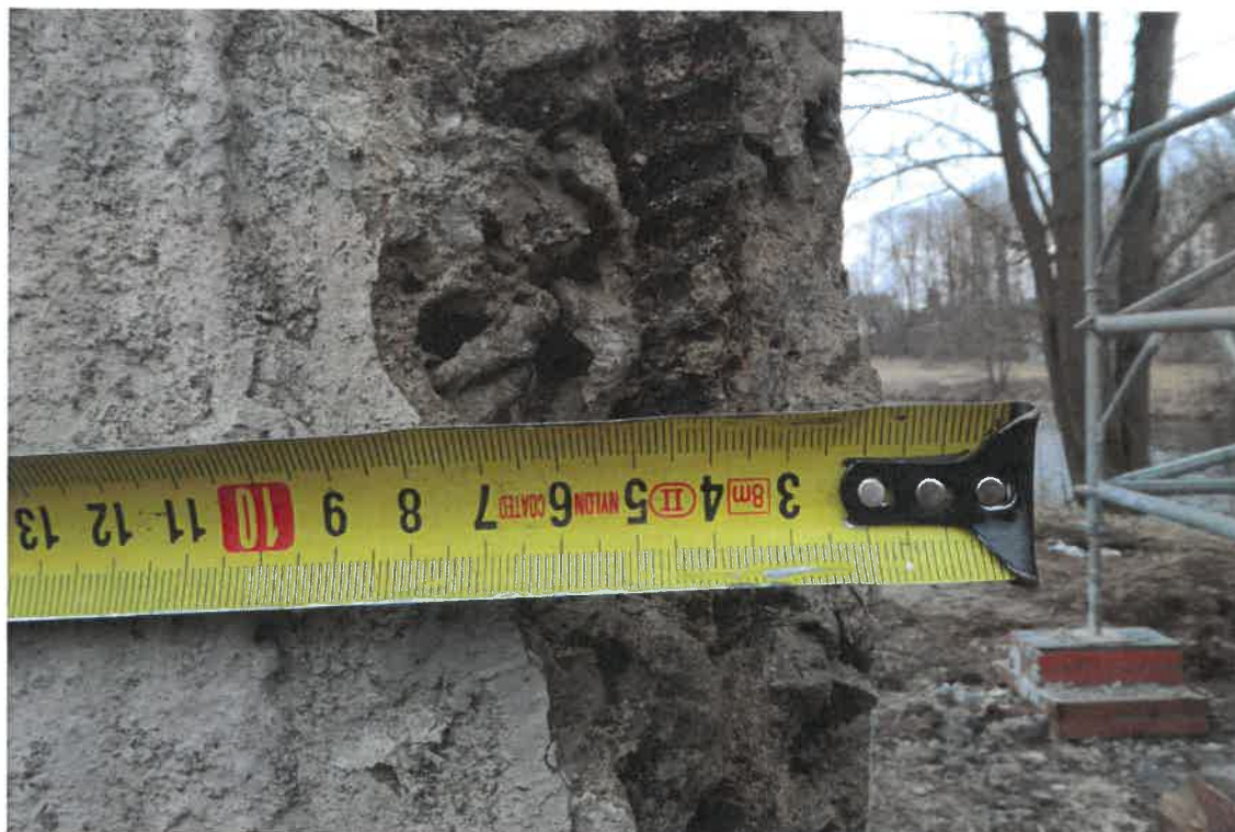
Pav. 13 Tilto kolonų krante su išilginės armatūros korozija ir betono pažaidomis vaizdas
