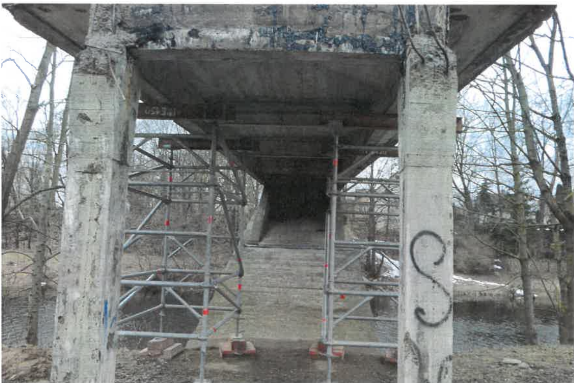
Pav. 5 Tilto galinės sijos atramos kolonų krante su paviršiaus ir atraminio mazgo pažaidomis vaizdas
