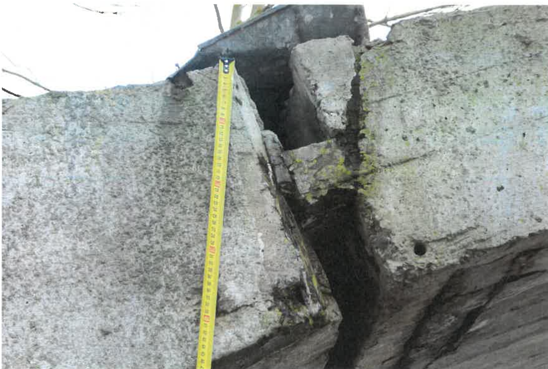
Pav. 17 Tilto kolonų krante su betono korozijos pažaidomis ir plyšiais vaizdas
