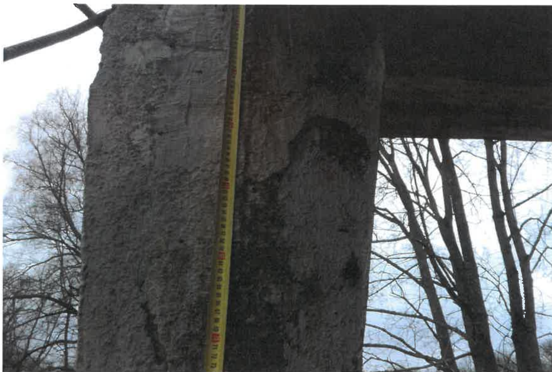
Pav. 17 Tilto kolonų krante su betono korozijos pažaidomis ir plyšiais vaizdas
