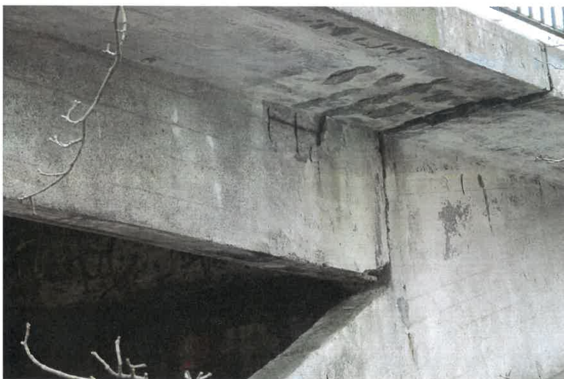
Pav. 7 Tilto centrinės arkos ir galinės sijos atramos su betono korozijos pažaidomis fragmentas
