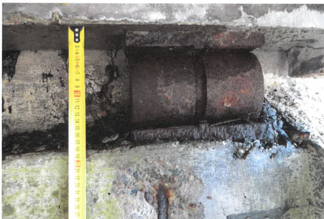
Pav. 23 Sijos atramos pažaidos (betono glemžimo požymiai, plieno korozija)
