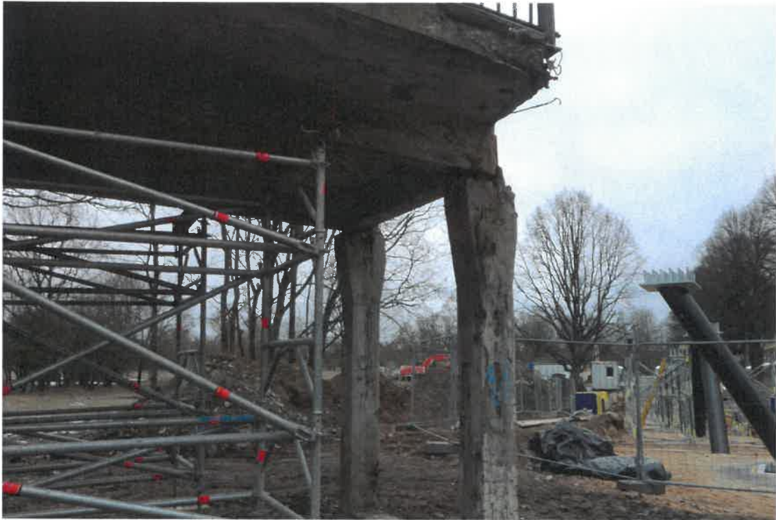
Pav. 5 Tilto galinės sijos atramos kolonų krante su paviršiaus ir atraminio mazgo pažaidomis vaizdas
