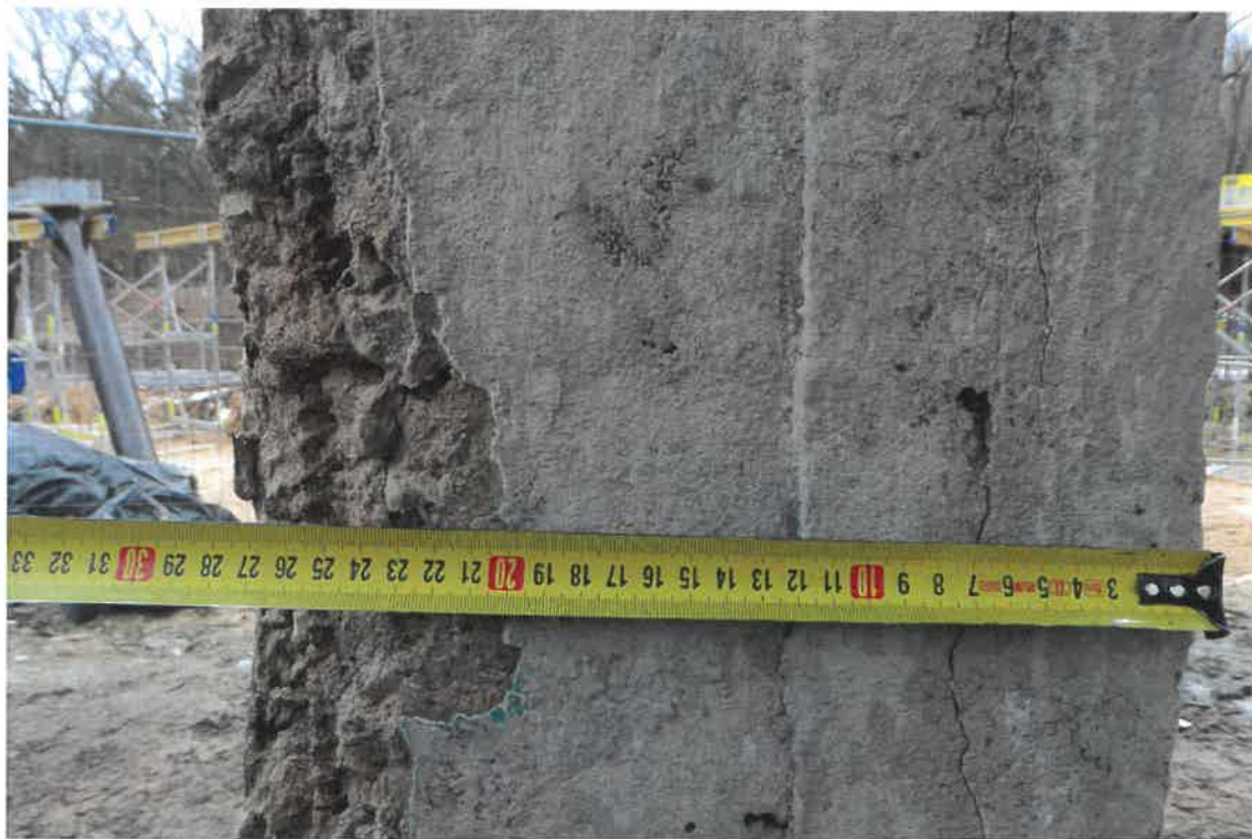
Pav. 11 Tilto galinės sijos atramos kolonų krante su išilginiais plyšiais ir betono pažaidomis vaizdas
