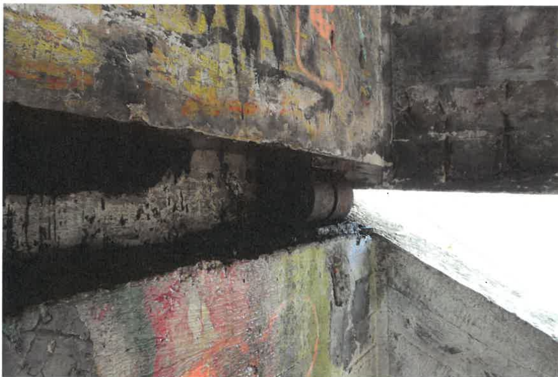
Pav. 21 Sijos atramos pažeidimas (betono glemžimo požymiai, plieno korozija)
