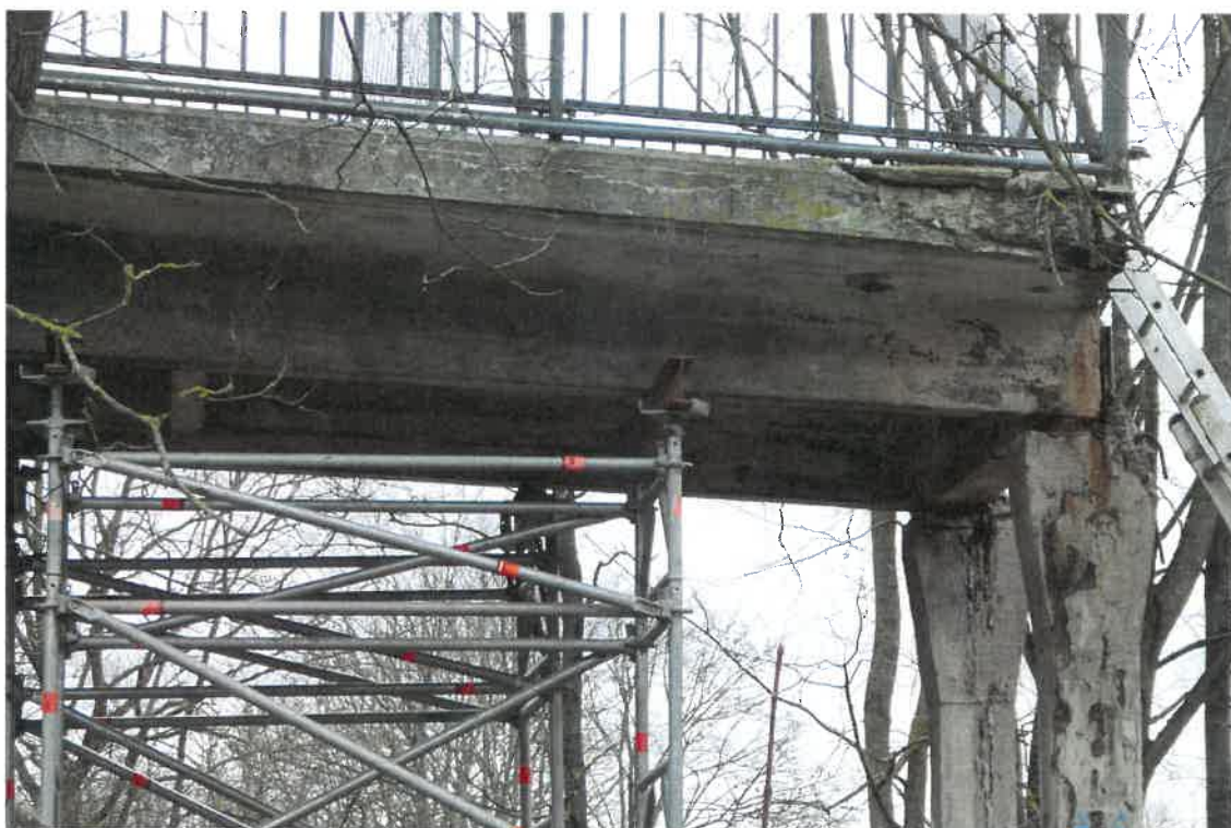
Pav. 25 Galinės sijos stipriai pažeistos konsolės betono pažaidos dėl armatūros intensyvios korozijos
