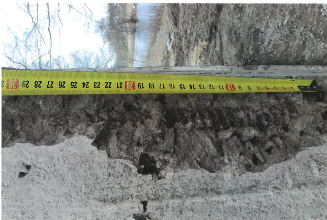
Pav. 13 Tilto kolonų krante su išilginės armatūros korozija ir betono pažaidomis vaizdas
