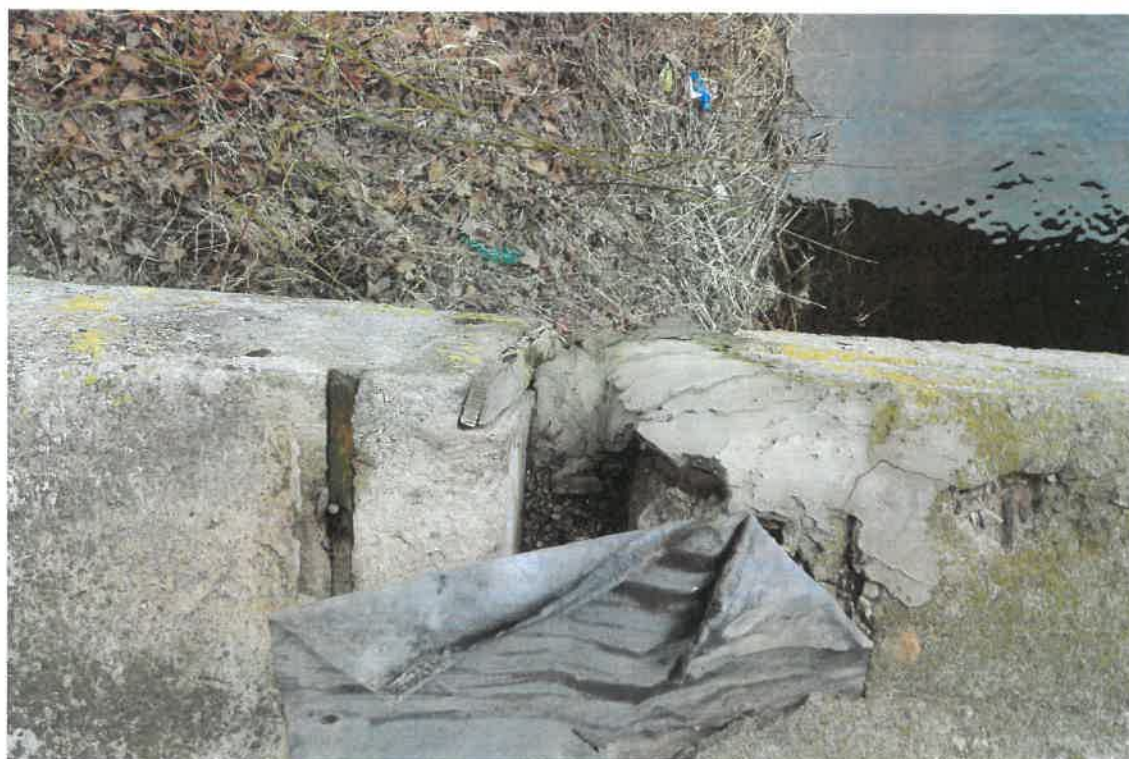
Pav. 19 Tilto centrinės arkos galinės atramos ir sijos su betono korozijos pažaidomis vaizdas
