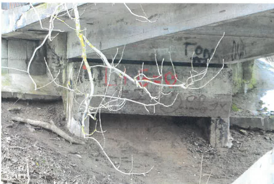
Pav. 27 Sijos kranto gelžbetonio atramos pažaidos (betono korozijos požymiai)
