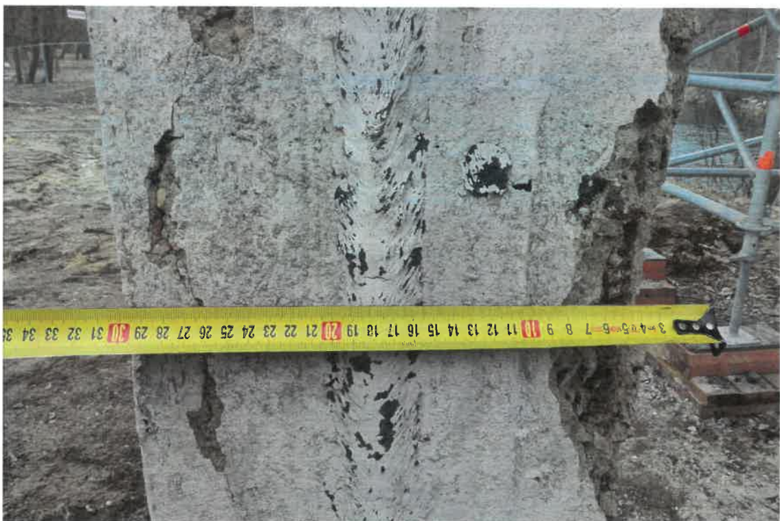
Pav. 11 Tilto galinės sijos atramos kolonų krante su išilginiais plyšiais ir betono pažaidomis vaizdas
