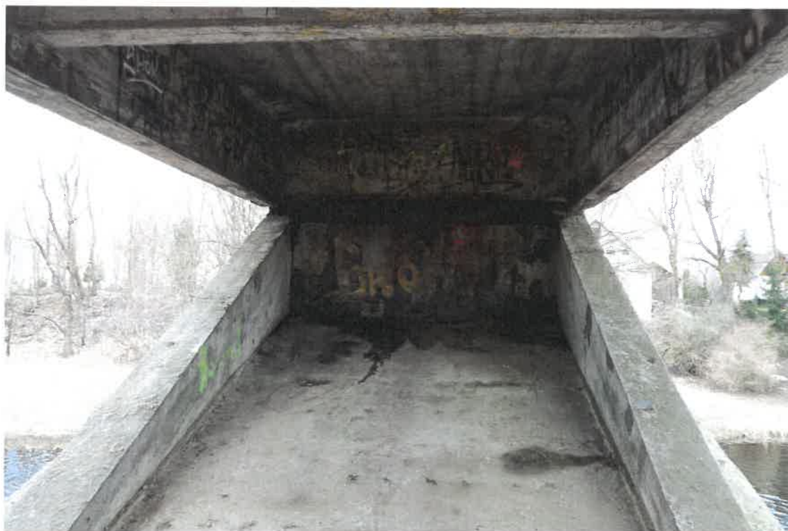
Pav. 19 Tilto centrinės arkos galinės atramos ir sijos su betono korozijos pažaidomis vaizdas
