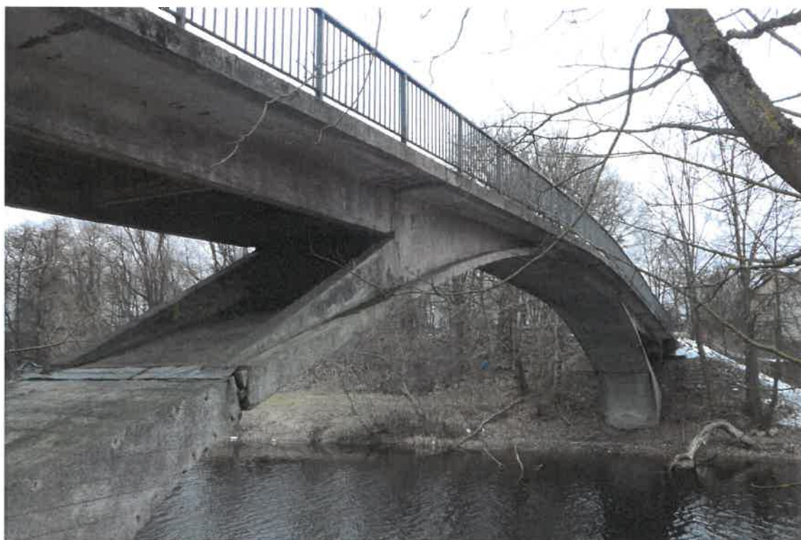
Pav. 7 Tilto centrinės arkos ir galinės sijos atramos su betono korozijos pažaidomis fragmentas
