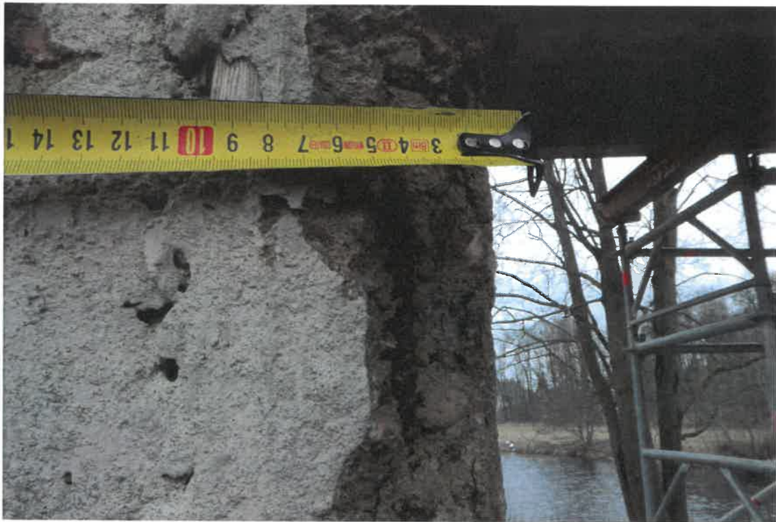
Pav. 15 Tilto kolonų krante atraminio mazgo su armatūros korozija ir betono pažaidomis vaizdas
