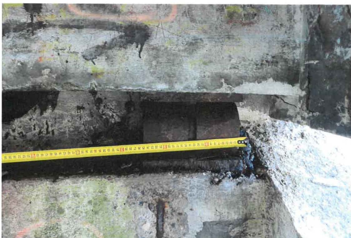
Pav. 21 Sijos atramos pažeidimas (betono glemžimo požymiai, plieno korozija)
