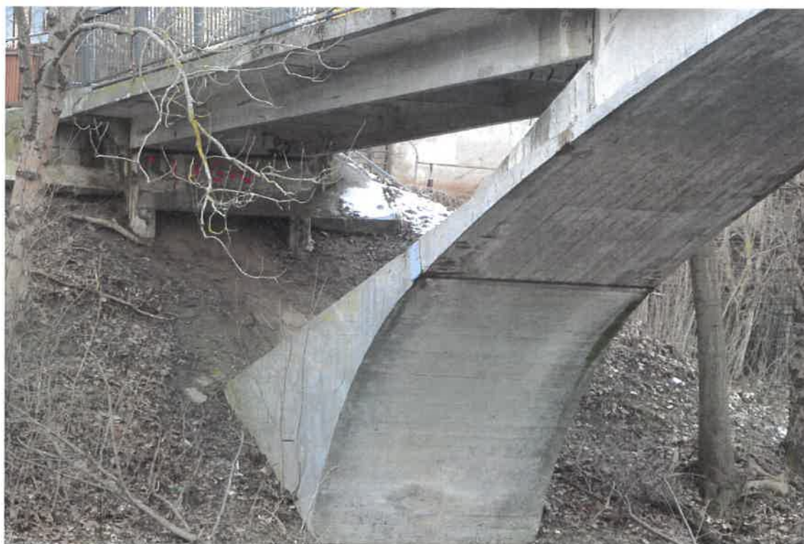
Pav. 27 Sijos kranto gelžbetonio atramos pažaidos (betono korozijos požymiai)
