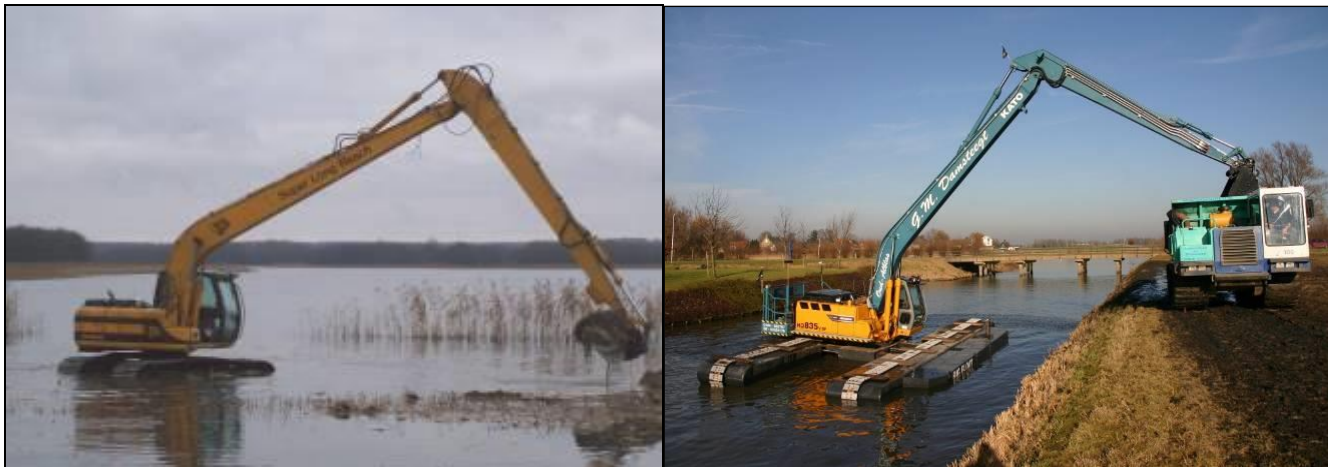
Pav. 7. Vandens telkinių valymas ilgastreliu ir amfibiniu ekskavatoriais (A. Balevičiaus ir www.gmdamsteegt.nl nuotr.)
