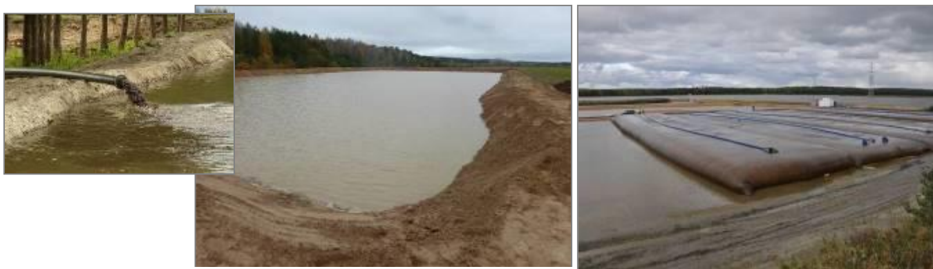
Pav. 10. Žemsiurbe išsiurbto grunto pylimas į sėsdintuvus ir geomaišus (A. Balevičiaus nuotr.)
