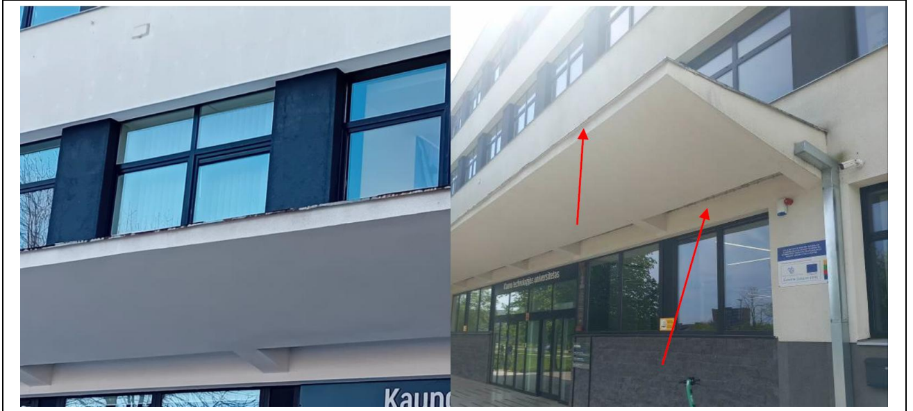
1 pav. stogelio esamos būklės fotografacija
