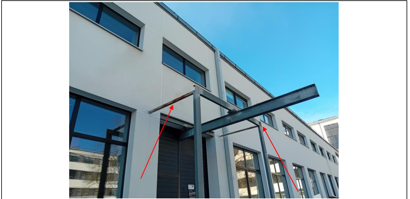
11 pav. metalinės konstrukcijos esamos būklės fotografacija
