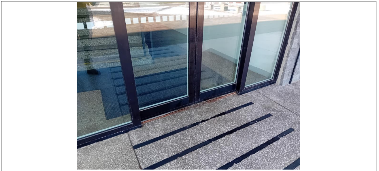
2 pav. lauko durų esamos būklės fotografacija
