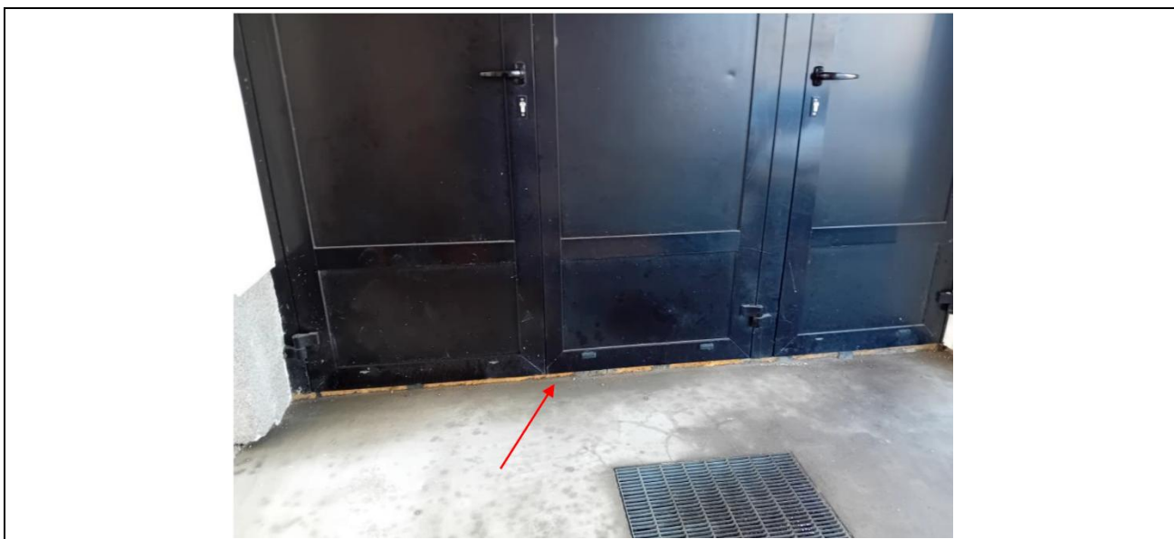
8 pav. durų slenksčio esamos būklės fotografacija
