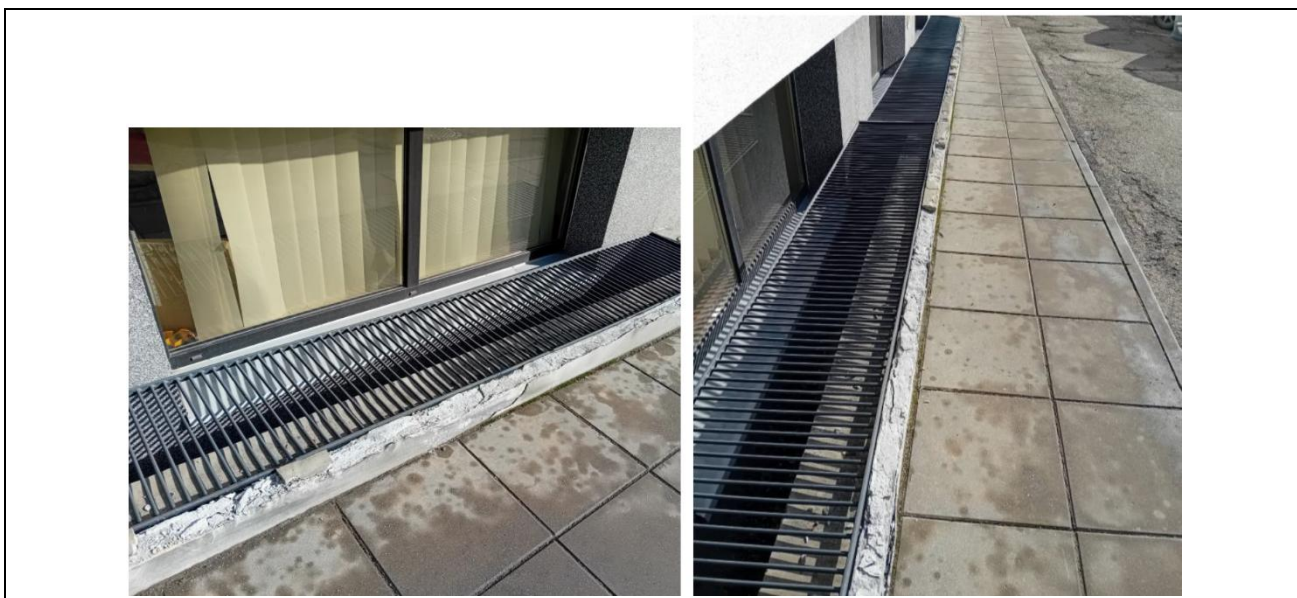
4 pav. šviesduobių esamos būklės fotografacija
