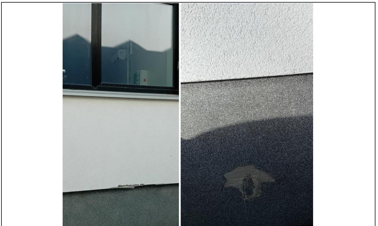
12 pav. fasado apdailos esamos būklės fotografacija
