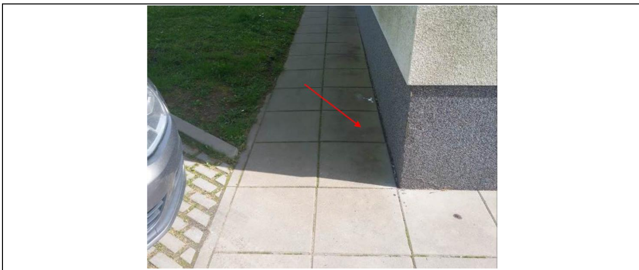
7 pav. nuogrindos esamos būklės fotografacija
