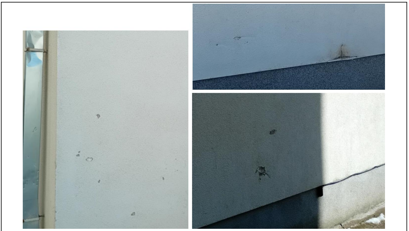
10 pav. fasado apdailos esamos būklės fotografacija
