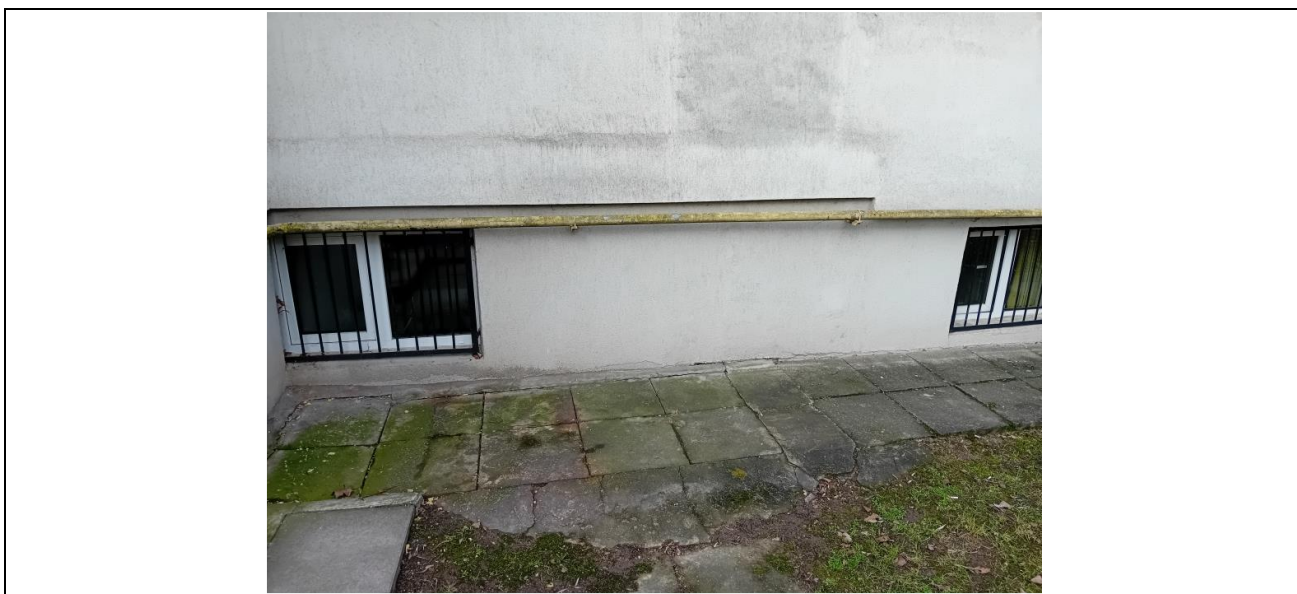
4 pav. nuogrindos esamos būklės fotografacija
