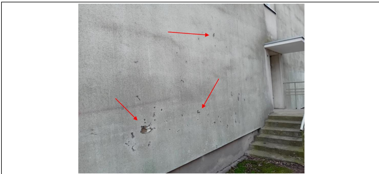
3 pav. fasado esamos būklės fotografacija
