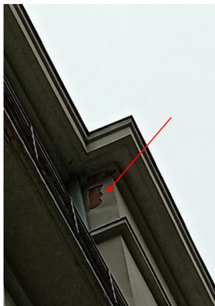
1 pav. fasado konstrukcijų esamos būklės fotofiksacija
