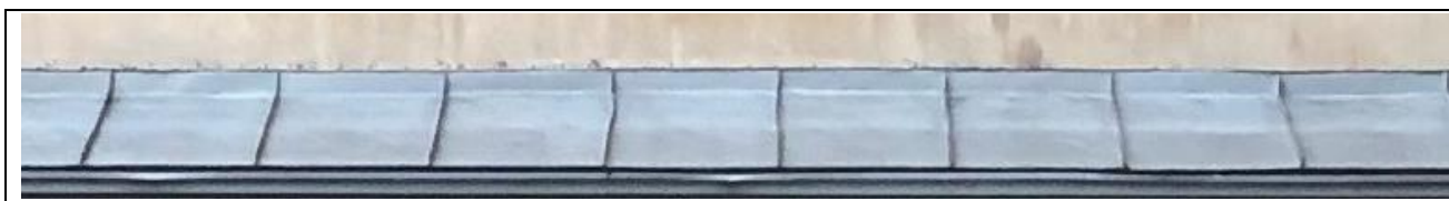
12 pav. skardų sujungimo pavyzdys
