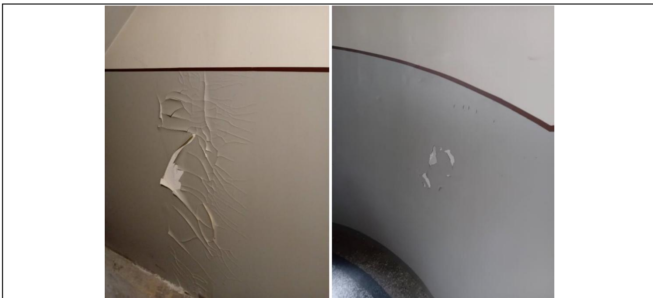
3 pav. vidaus sienų esamos būklės fotografacija
