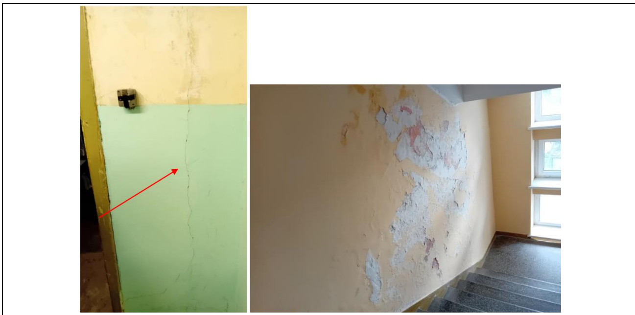
3 pav. vidaus sienų esamos būklės fotografacija
