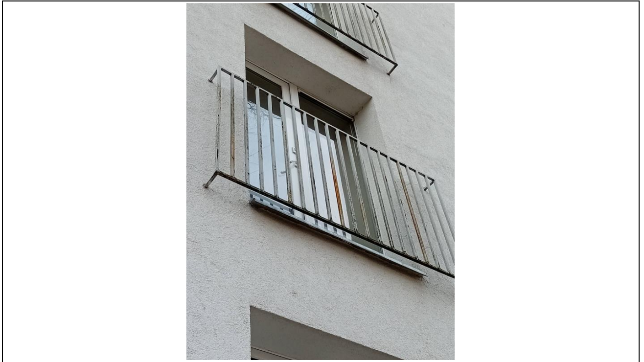
1 pav. metalinių turėklų esamos būklės fotografacija
