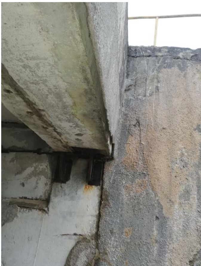
10 pav. Aprišimo sijų ir rygelių atrėmimas. Vaizdas įvažiavimo zonoje.
