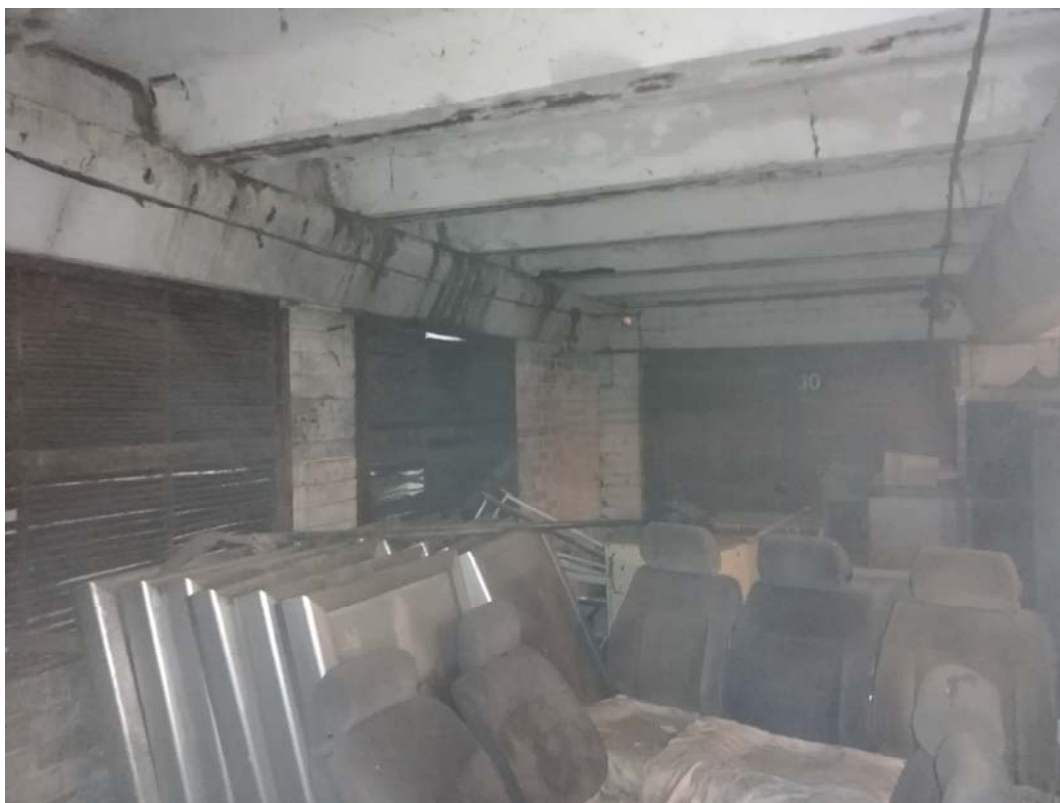
25 pav. Galinėse ašyse (vaizdas poliklinikos pusėje) g/b konstrukcijos (rygeliai ir plokštės) paveiktos drėgmės. Armatūros apsauginis sluoksnis atsisluoksniavęs
