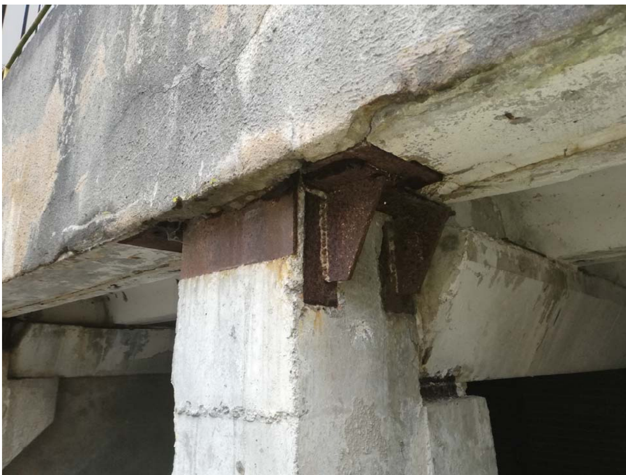
11 pav. Aprišimo sijų ir rygelių atrėmimas. Vaizdas įvažiavimo zonoje.
