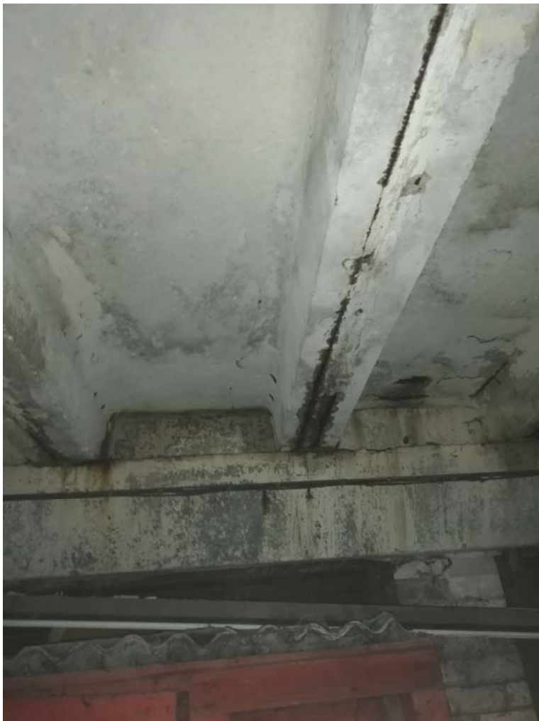
28 pav. Galinėse ašyse (vaizdas administracijos pusėje) g/b konstrukcijos (rygeliai ir plokštės) paveiktos drėgmės. Armatūros apsauginis sluoksnis atsisluoksniavęs
