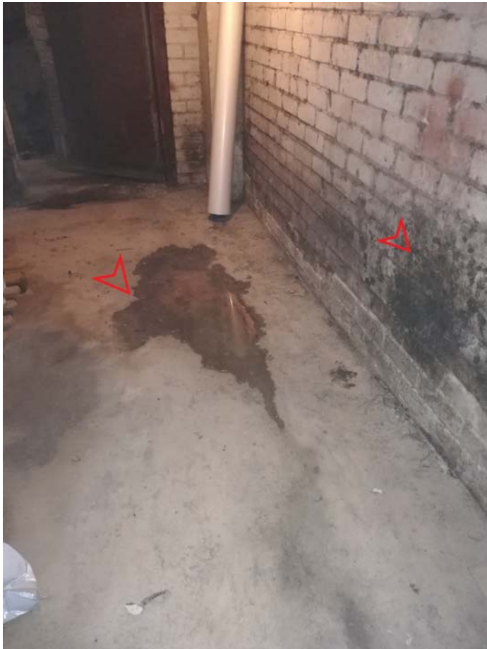
22 pav. Galinės sienos mūras paveiktas drėgmės pelija. Gruntinis vanduo skverbiasi per grindis. Vaizdas paskutiniame garaže (poliklinikos pusėje)
