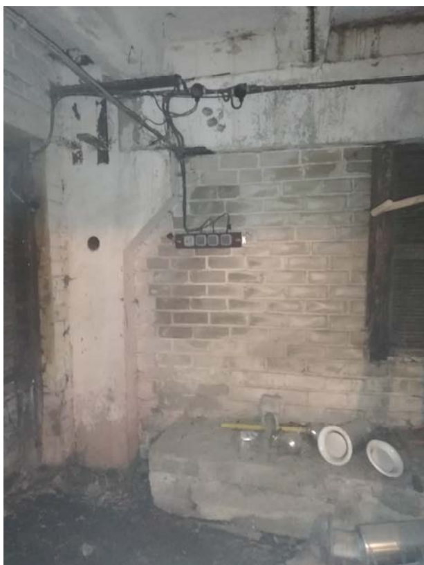
27 pav. Galinėse ašyse (vaizdas administracijos pusėje) g/b konstrukcijos (rygeliai ir plokštės) paveiktos drėgmės. Armatūros apsauginis sluoksnis atsisluoksniavęs
