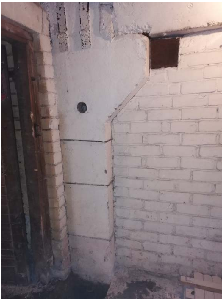
19 pav. Kasinio ties vidurine kolona vieta. Garažų vartai įstatyti į save laikantį mūrą (38cm storio , silikatinių plytų). Mūras sumūrytas ant kolonos stulpinio pamato.
