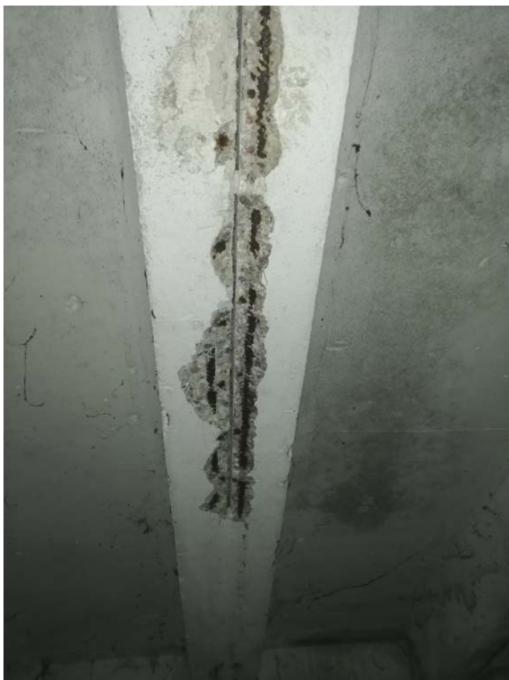
26 pav. Galinėse ašyse (vaizdas poliklinikos pusėje) g/b konstrukcijos (rygeliai ir plokštės) paveiktos drėgmės. Armatūros apsauginis sluoksnis atsisluoksniavęs
