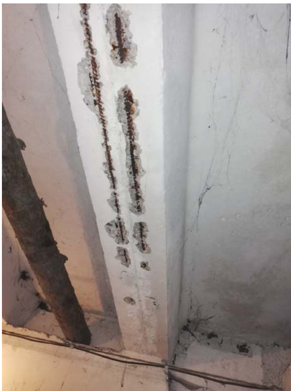
29 pav. Galinėse ašyse (vaizdas administracijos pusėje) g/b konstrukcijos (rygeliai ir plokštės) paveiktos drėgmės. Armatūros apsauginis sluoksnis atsisluoksniavęs
