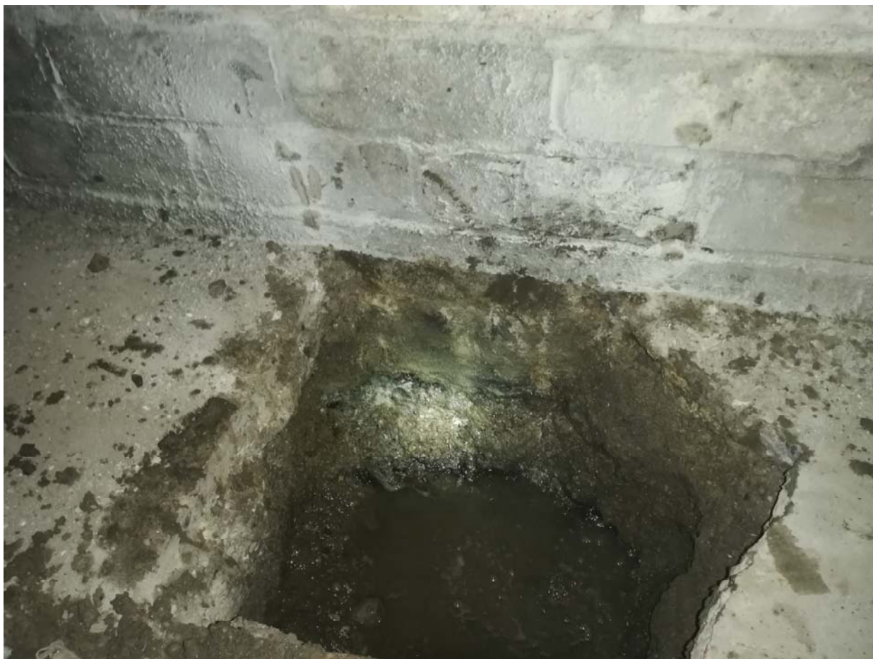
20 pav. Kasinio ties galine siena (į poliklinikos pusę) vaizdas. Mūro apačia apie 10cm žemiau grindų. Tuomet 40cm aukščio pamatų sija. Vandens lygis 20-25cm žemiau esamų grindų.
