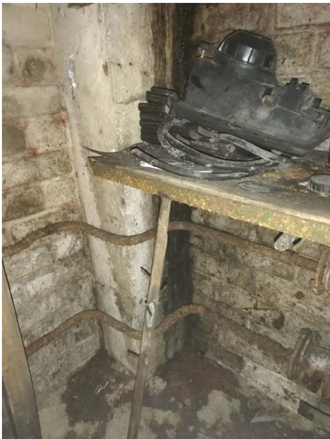
23 pav. Galinės sienos, išilginės sienos ir kolonos sandūra. Skverbiasi gruntinis vanduo.
