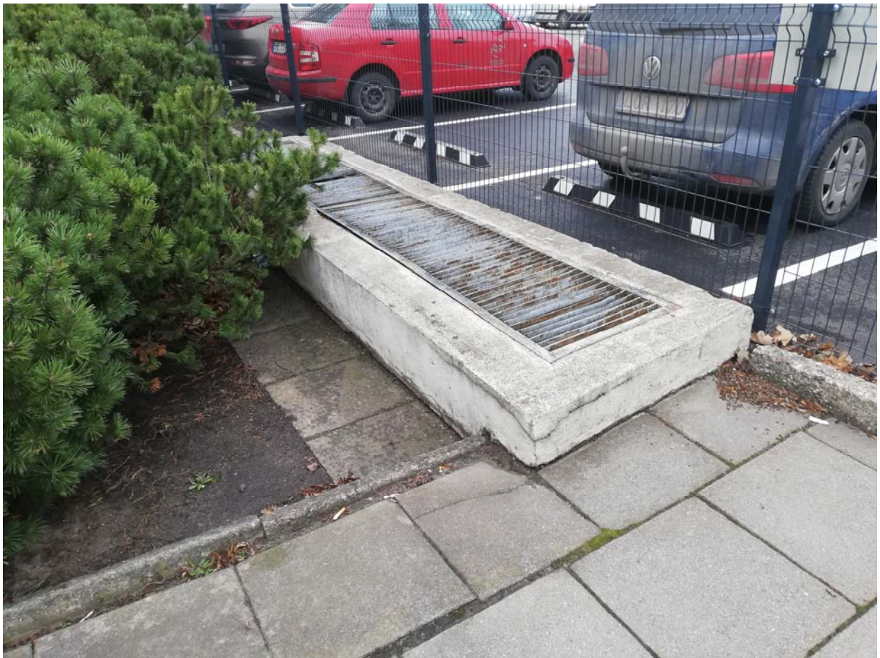
16 pav. Ventiliacijos šachtos į poliklinikos pusę ir virš požeminio garažo įrengta antžeminė stovėjimo aikštelė
