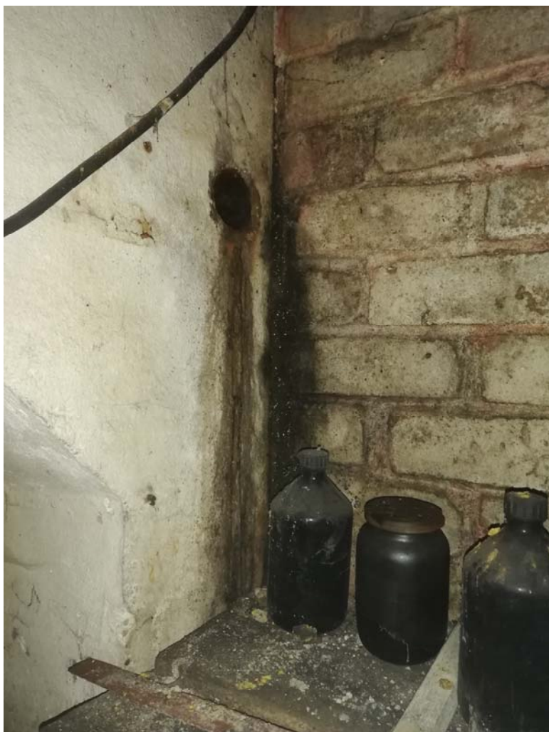
24 pav. Galinės sienos, išilginės sienos ir kolonos sandūra. Skverbiasi gruntinis vanduo.
