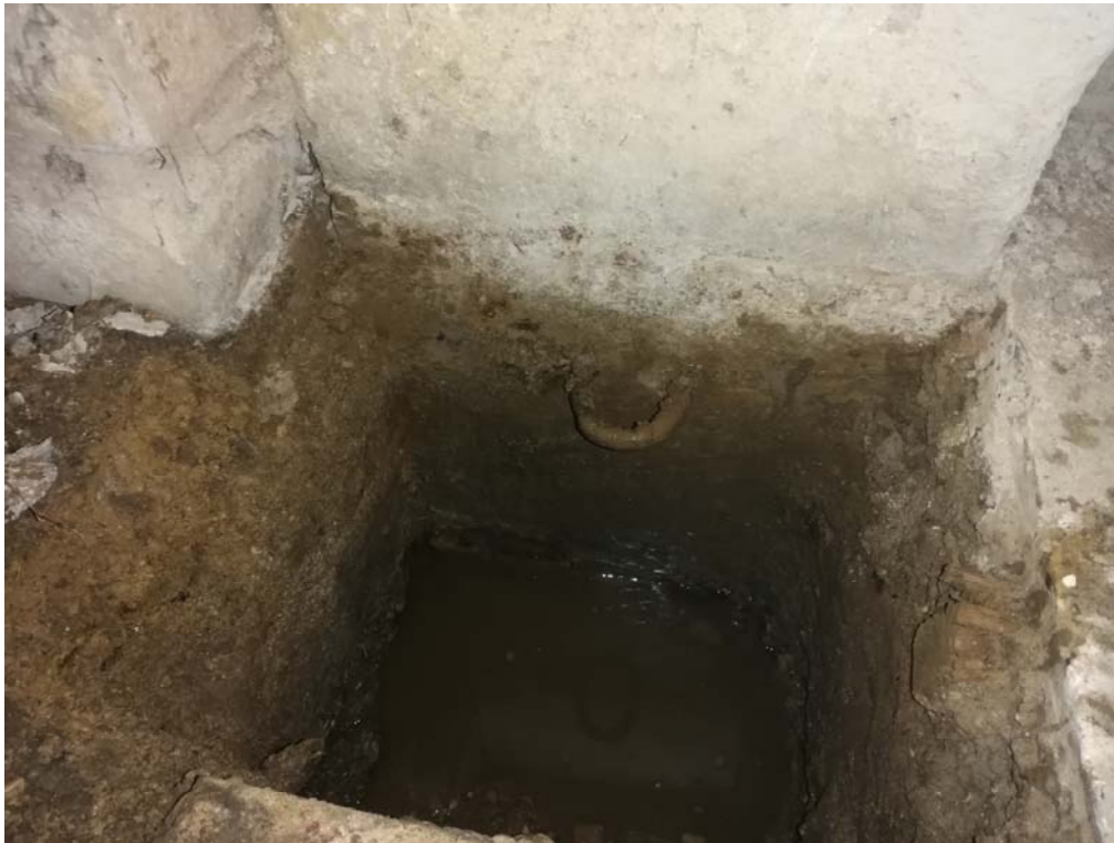
18 pav. Kasinio ties vidurine kolona vaizdas. Pamato viršus apie 50cm žemiau grindų. Vandens horizontas apie 20-25cm žemiau grindų. Išsėmus per keletą minučių duobė vėl užsipildo vandeniu. Grindų storis 15-20cm nearmuoto betono
