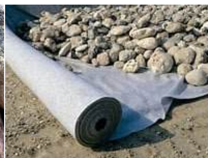
Pav. 19. Ant vejų klojamas atskiriamosios geotekstilės sluoksnis, reljefo nelygumai gali būti išlyginami nedideliu skaldos sluoksniu
