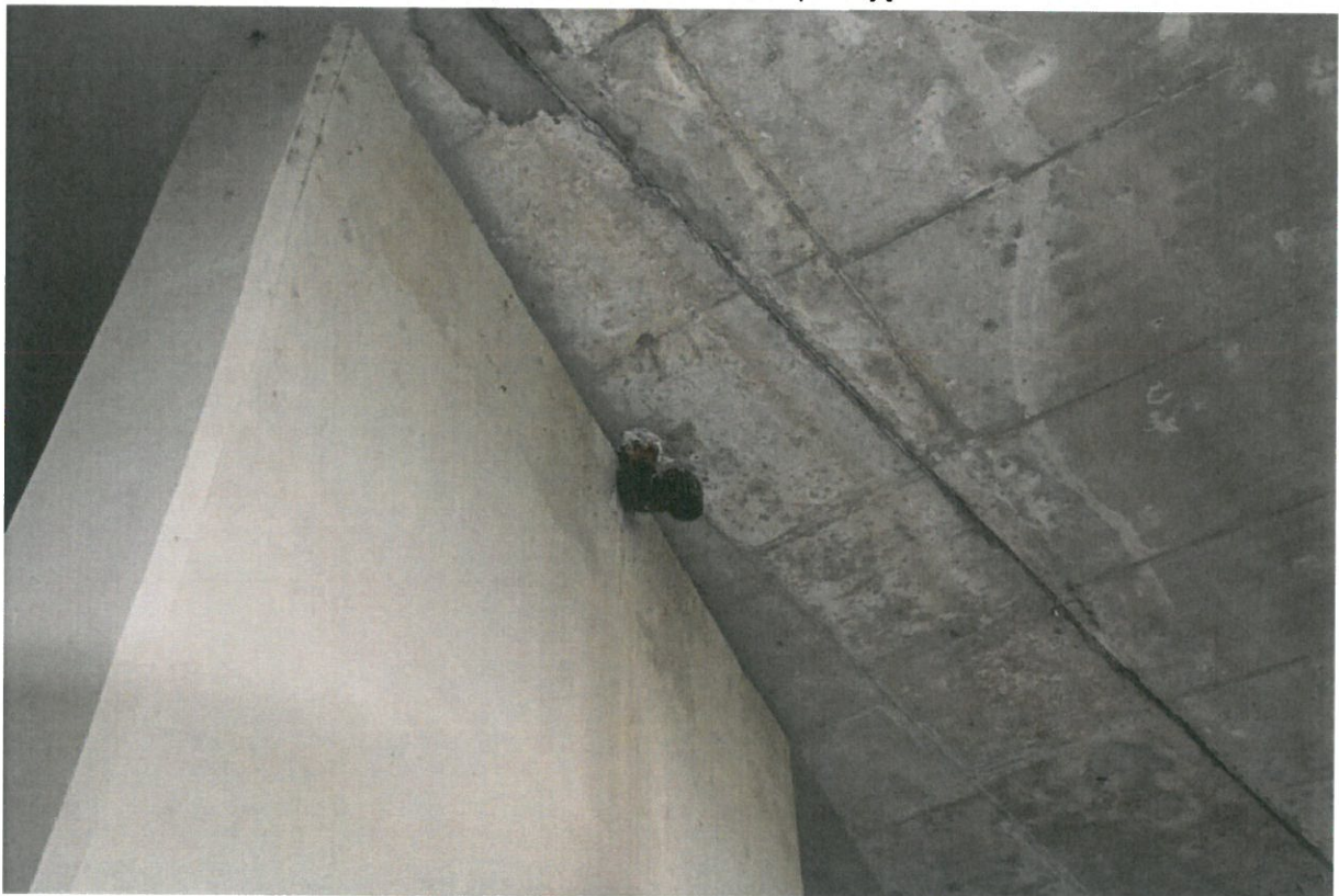
24 pav. Šulinėliai trumpi, drėkina apačioje esančias konstrukcijas
