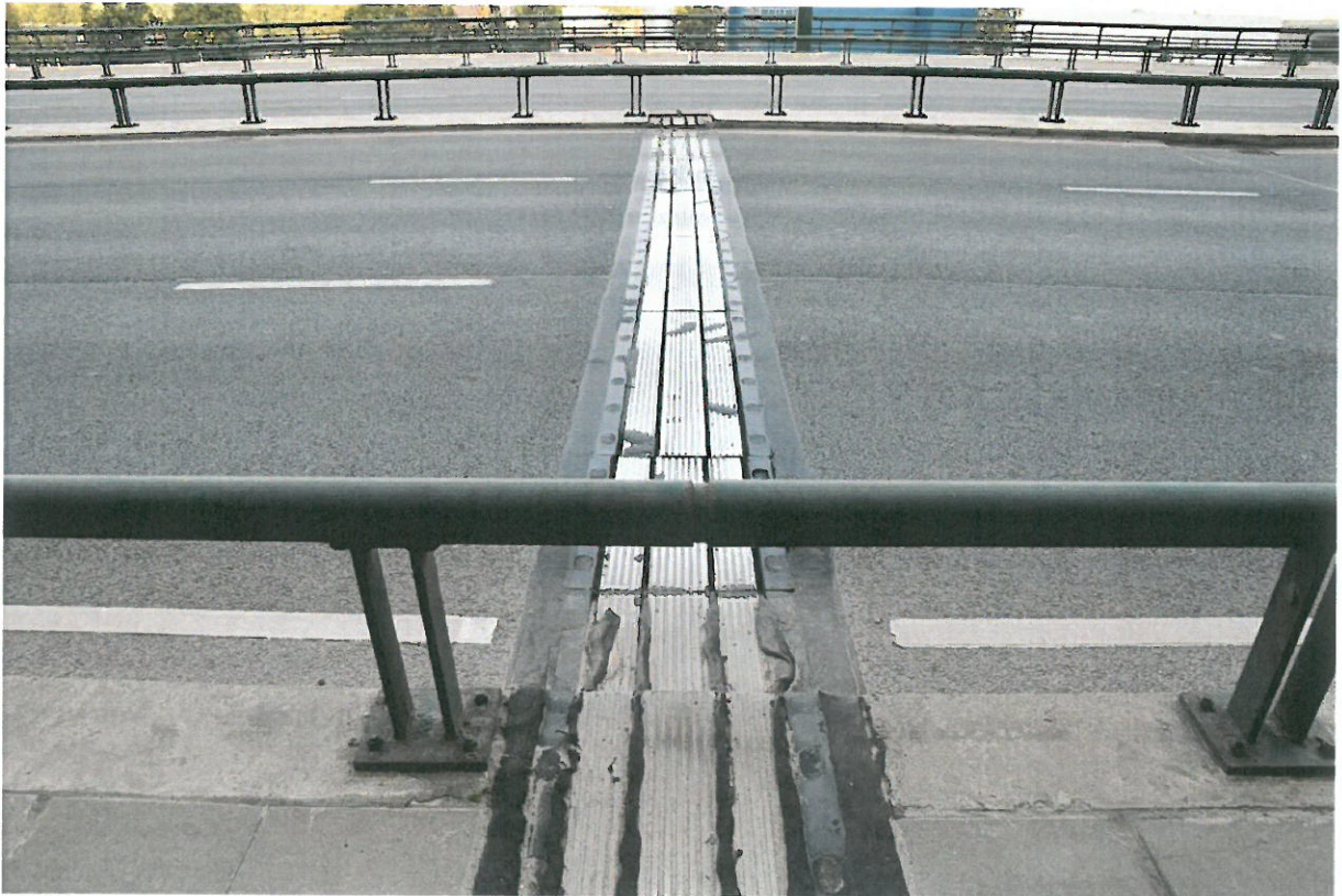
16 pav. Prieš pjūvį susiformavę kelio dangos nelygumai (siūlė link Aleksoto 2 dešinė)
