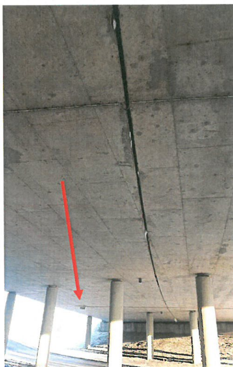
3.4 paveikslas. Deformacinis pjūvis ties dešinėsios ir kairiosios estakadų sandūra yra kiauras, nuotraukoje matyti sušalę varvekliai. Po perdanga neįrengti vandens surinkimo ir nuvedimo vamzdžiai. Rodykle parodytas šulinėlis virš važiuojamosios dalies
