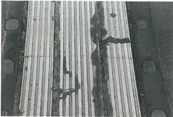
19 pav. Skilusios plokštelė, elementai juda, nėra tinkamai įtvirtinti (siūlė link CT1 kairė)
