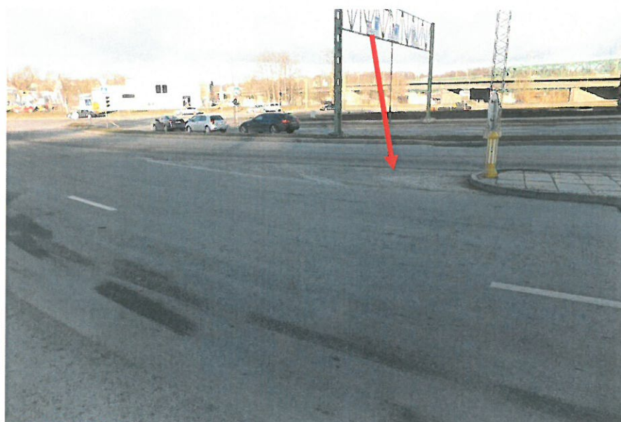
4.14 paveikslas. Nusitrynęs horizontalusis ženklavimas, netoli sankryžos su Minkovskių gatve
