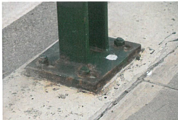
11 pav. Apsauginių atitvarų korozija
