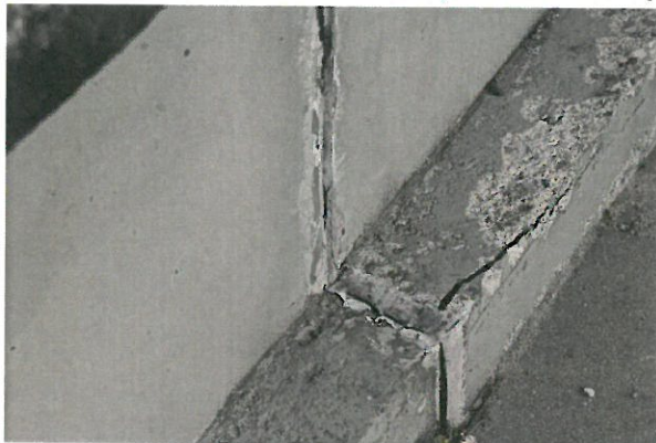
30 pav. Vietiniai betono sluoksnio pažeidimai atraminėse sienose
