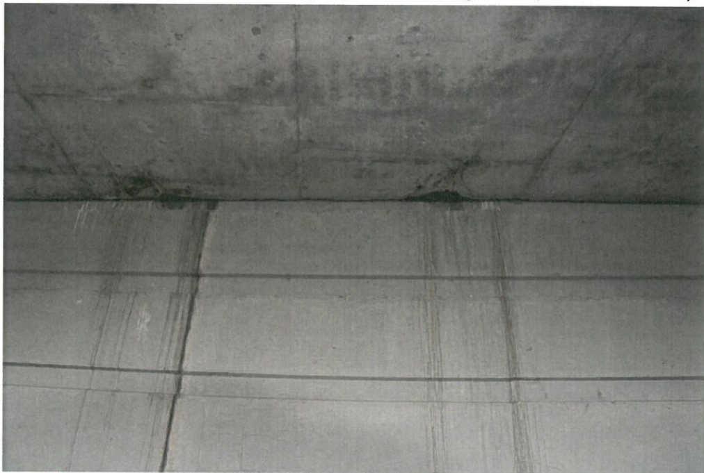
20 pav. Išilginis deformacinis pjūvis nesandarus
