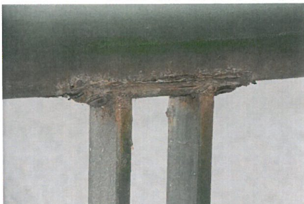
11 pav. Apsauginių atitvarų korozija
