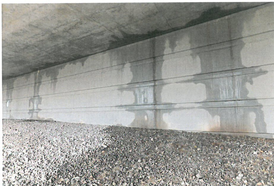
3.7 paveikslas. Bendras sienutės po estakada vaizdas. Sandūros tarp (dešinėsios estakados) perdangos ir sienutės deformacinis pjūvis kiauras, ant sienutės išplautų karbonatų dėmės
