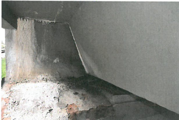
14 pav. Pjūvis nesandarus, vanduo prateka ant perdangos galinės briaunos ir atraminių dalių (Siūlė išvažiuojamas link Aleksoto)
