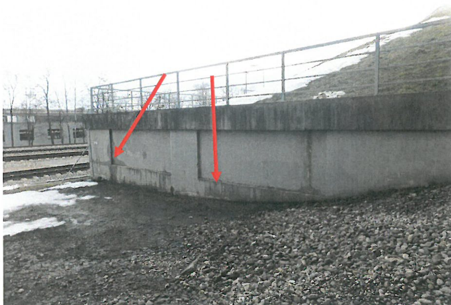
2.11 paveikslas. Šlapia sienutės prie geležinkelio apatinė dalis, neaišku ar įrengtas drenažas
