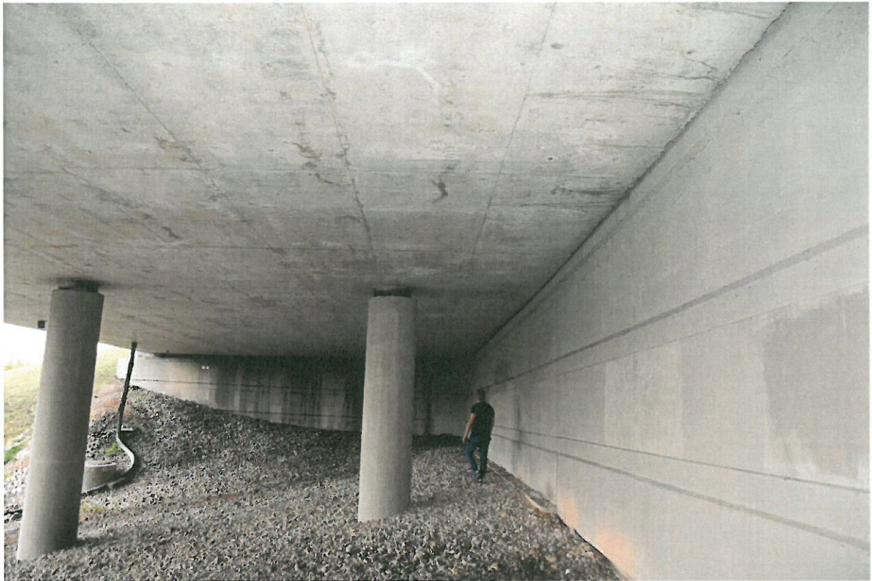
27 pav. Atraminiai guoliai ant tarpinių atramų pasislinkę
