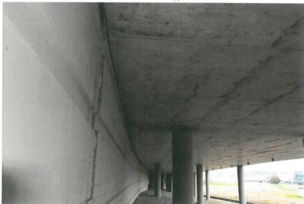
21 pav. Atraminė siena įsirėmusi į perdangą, perdangos plokštė stumiama
