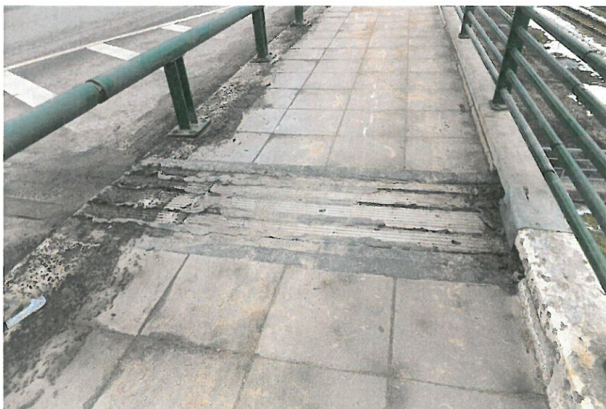
2.6 paveikslas. Pirmos atramos deformacinis pjūvis šalitiltyje. Suirę pjūvio guminiai elementai užtaisyti bitumine mastika, bet vis tiek kiauři
