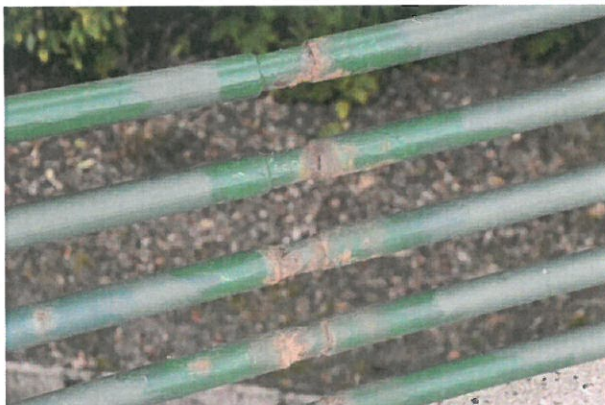
10 pav. Turėklų užpildų korozija, užstrigę paslankūs turėklų sujungimai
