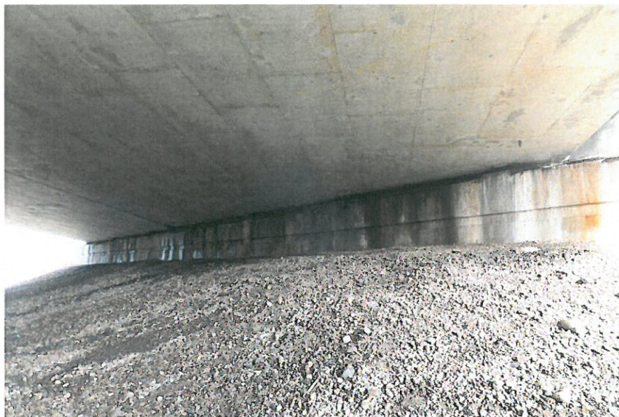
2.7 paveikslas. Atramos Nr.15 vaizdas. Kiauras deformacinis pjūvis, iš betono išplauti karbonatai
