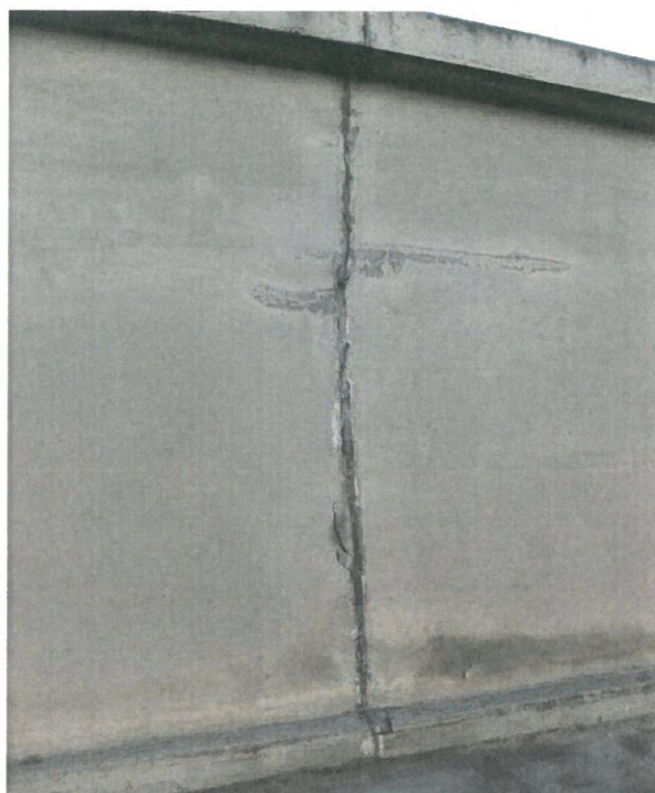
4.9 paveikslas. Sienutės „T-S“ temperatūrinės siūlės nesandarios
