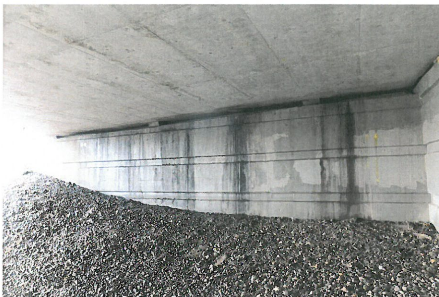
2.5 paveikslas. Dėl kiauro deformacinio pjūvio šlapia atrama Nr.1
