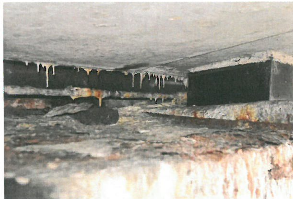
12 pav. Pjūvis nesandarus, vanduo prateka ant perdangos galinės briaunos ir atraminių dalių (ilgoji siūlė)
