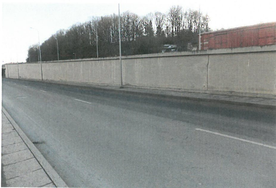
4.8 paveikslas. Sienutė „T-S“ supleišėjusi per visą ilgį vertikaliais plyšiais
