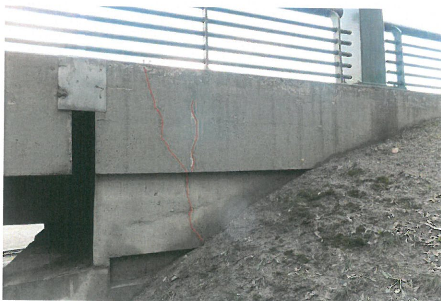
3.6 paveikslas. Supleišėjęs 5K atramos sparnas, plyšių pločiai iki 0,20 mm
