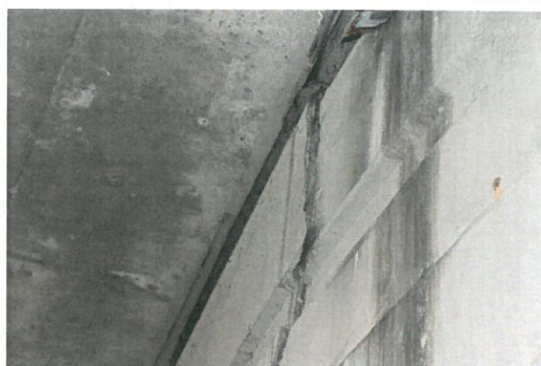
32 pav. Deformacinės siūlės nesandarios, betono sluoksnis atskilęs
