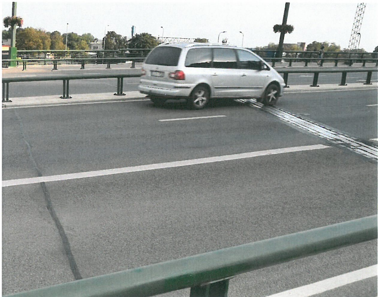
6 pav. Susiformavusios duobės prieš deformacinius pjūvius
