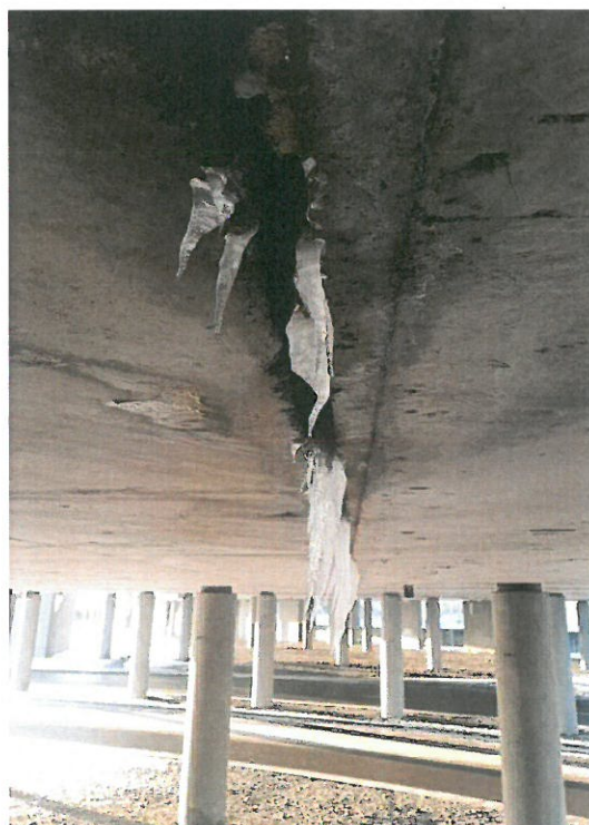
2.8 paveikslas. Dešiniosios ir kairiosios estakadų sandūroje deformacinis pjūvis nesandarus, drėkinama perdanga, prie minusinės temperatūros kabo varvekliai
