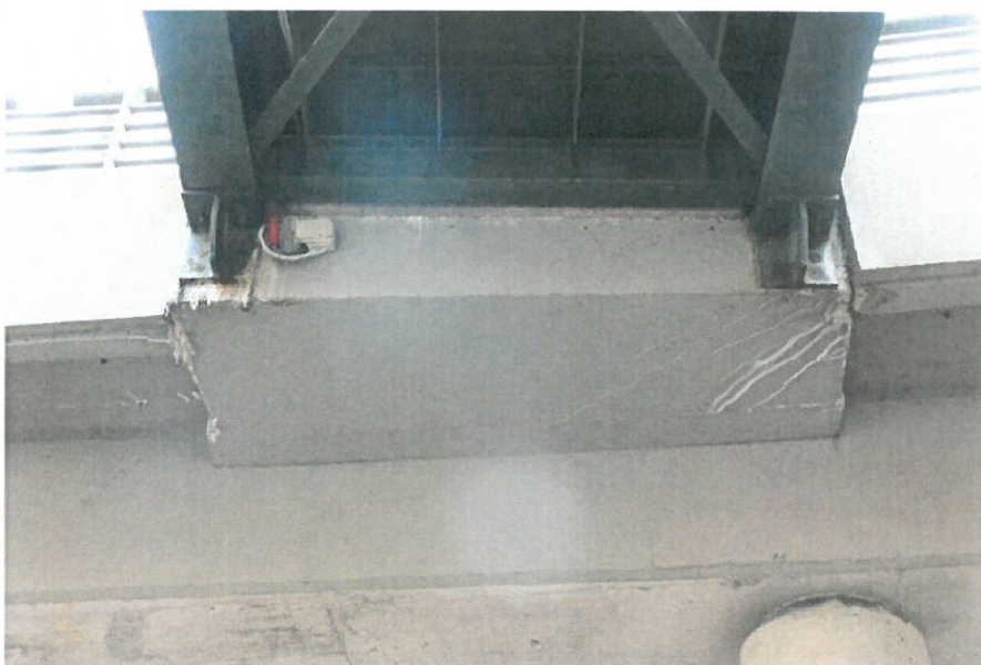
4.12 paveikslas. Balti pataikai ties tiltelio sujungimo vieta su estakada, tačiau deformaciniai pjūviai sandarūs
