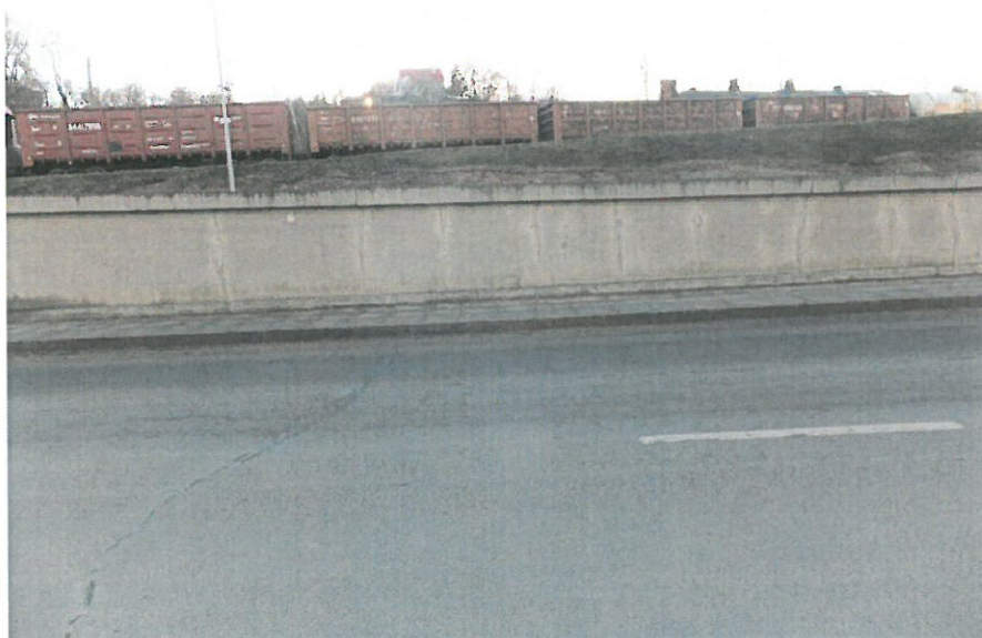
4.6 paveikslas. Sienutė „V-Z“ per visą ilgį supleišėjusi vertikaliais plyšiais
