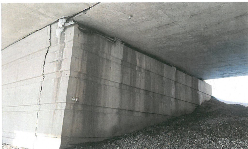
3.3 paveikslas. Deformacinis pjūvis ties 5K atrama kiauras, ramtas šlapias
