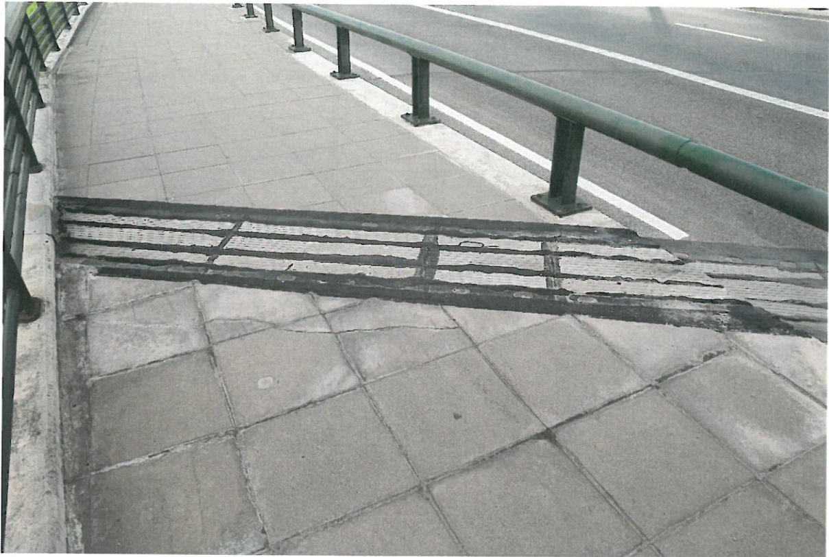
7 pav. Šaltilčio dangos pažeidimai ties deformaciniai pjūviais
