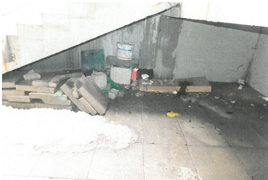
2.15 paveikslas. Po pirmuoju laiptinės maršu, betoninių plytelių atliekos ir šiukšlės, sienutė po maršu šlapia
