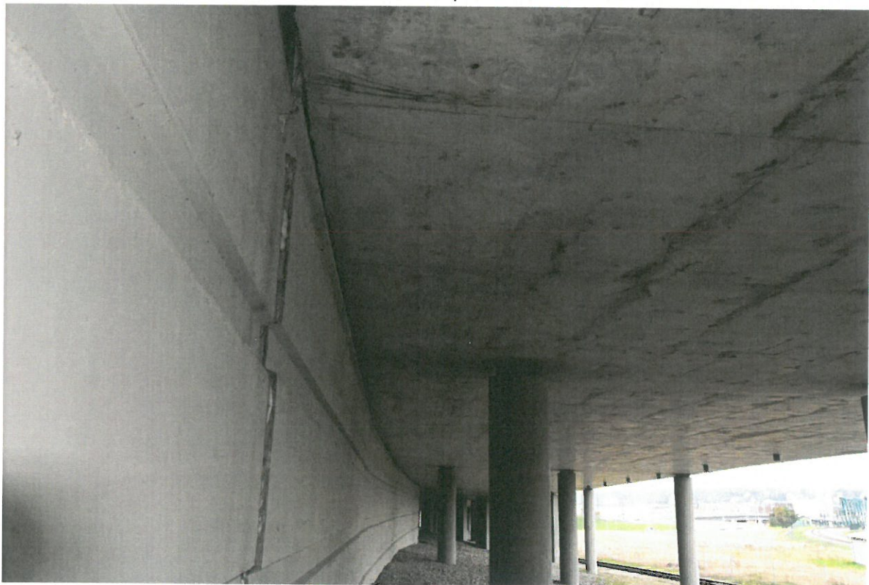
31 pav. Atraminė siena pasvirusi ir įsirėmusi į perdangos plokštę
