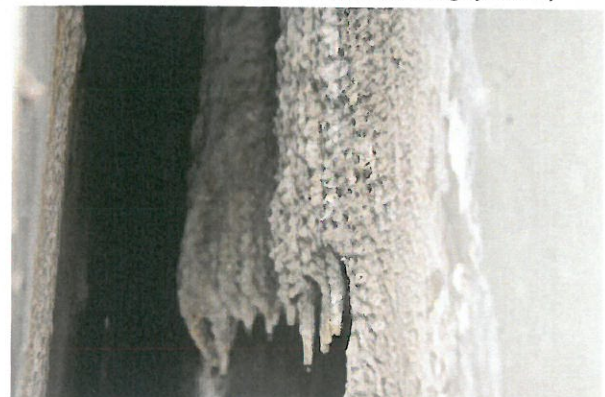
14 pav. Pjūvis nesandarus, vanduo prateka ant perdangos galinės briaunos ir atraminių dalių (Siūlė išvažiuojamas link Aleksoto)
