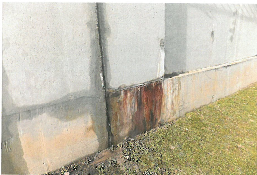
2.13 paveikslas. Šlapia sienutės apatinė dalis, spalva parodo armatūros koroziją
