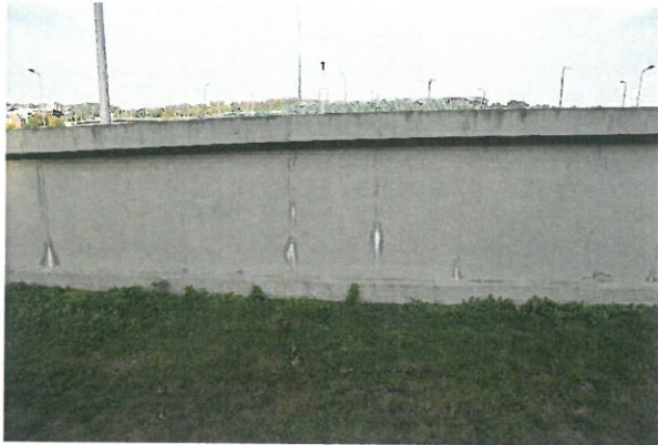
29 pav. Susiformavę tankūs vertikalūs plyšiai
