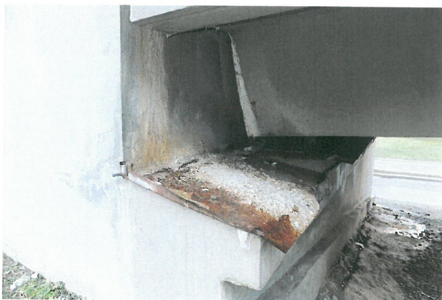
4.4 paveikslas. Per nesandarų deformacinį pjūvį atramoje Nr. 20 drėkinamos atramos ir perdangos konstrukcijos
