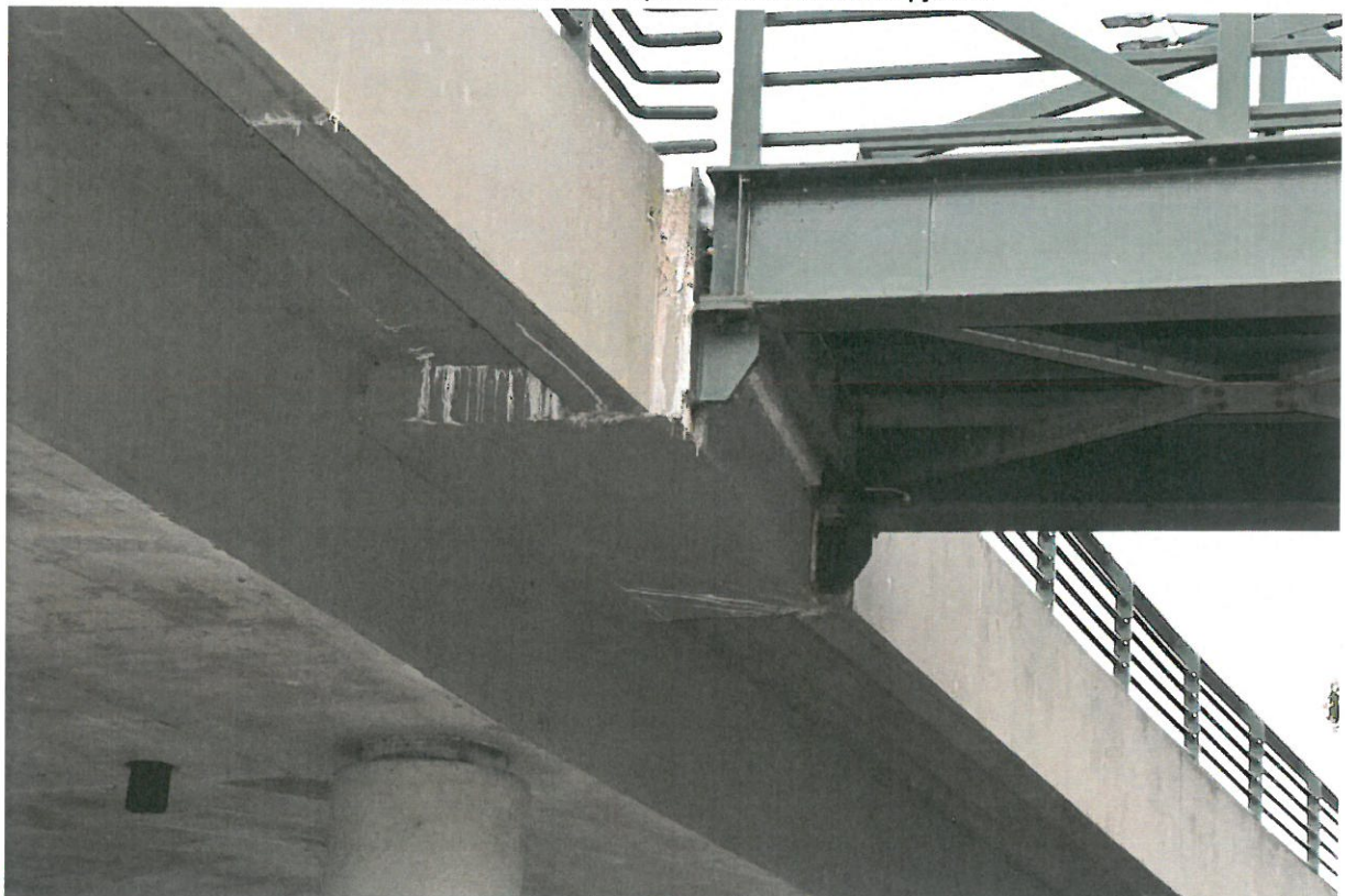
35 pav. Nesandarus tiltelio prijungimo mazgo deformacinis pjūvis
