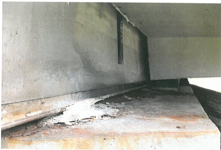
3.5 paveikslas. Deformacinis pjūvis ties 15 atrama kiauras, ant ramto ir perdangos išplautų karbonatų dėmės
