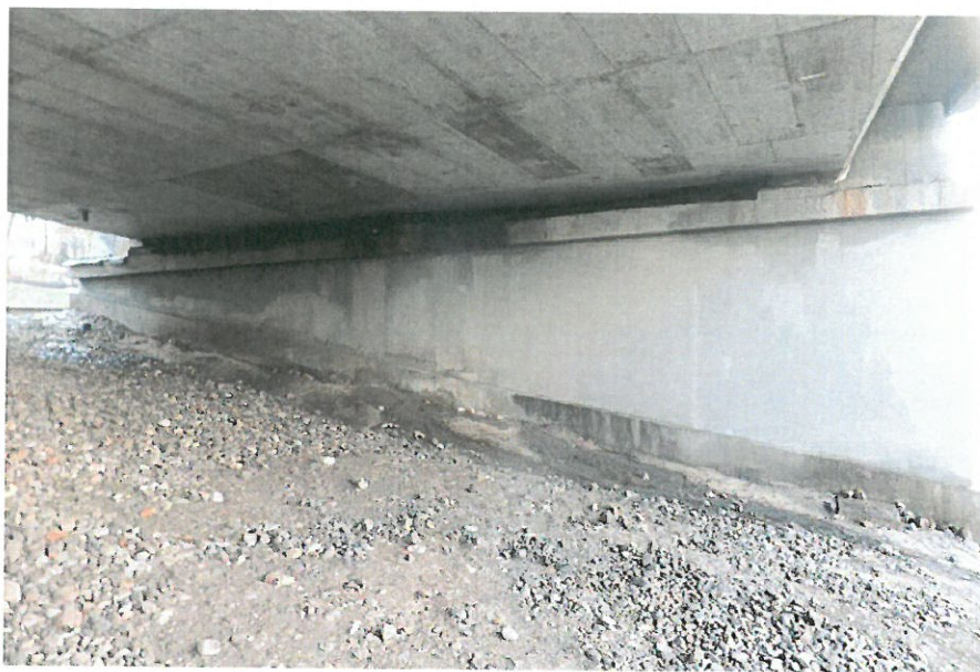
4.3 paveikslas. Deformacinis pjūvis atramoje Nr. 20 yra nesandarus
