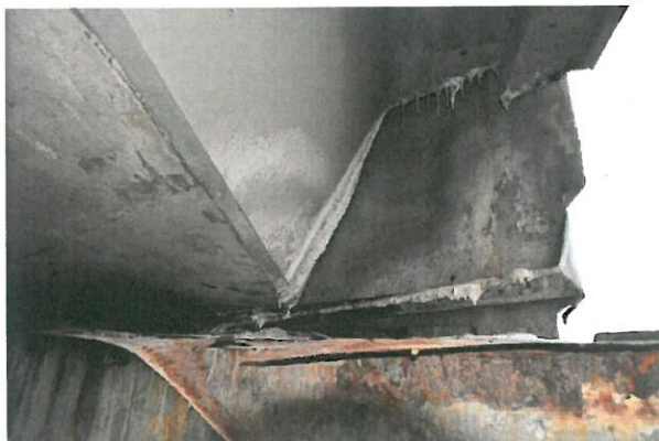
12 pav. Pjūvis nesandarus, vanduo prateka ant perdangos galinės briaunos ir atraminių dalių (ilgoji siūlė)
