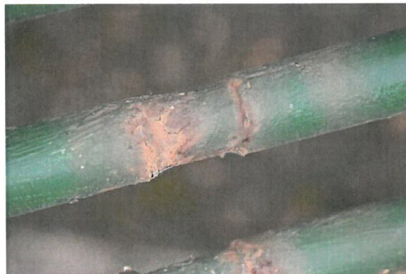
10 pav. Turėklų užpildų korozija, užstrigę paslankūs turėklų sujungimai
