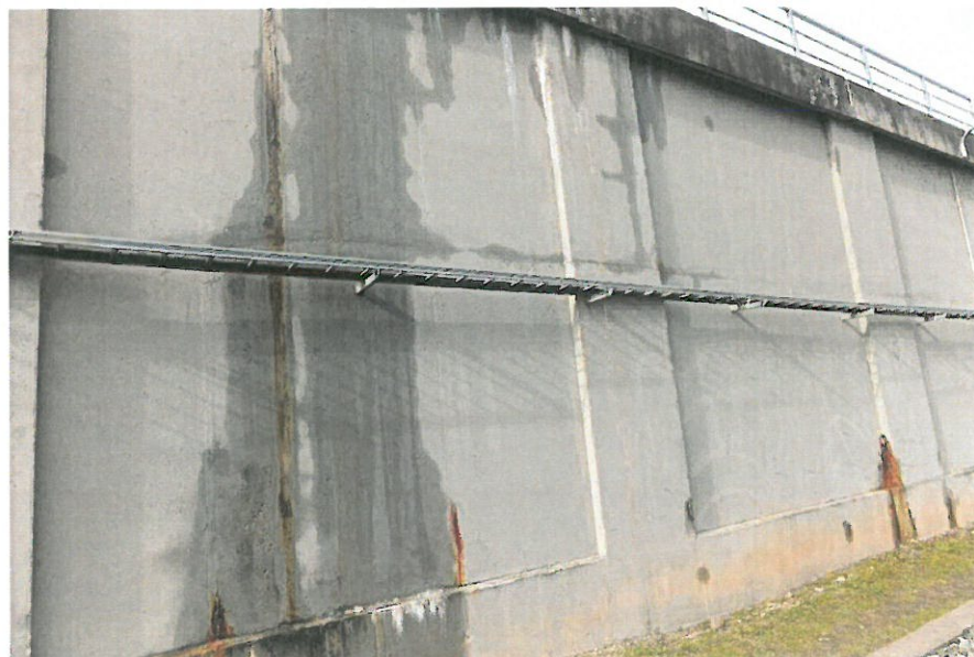
2.12 paveikslas. Atraminė sienutė nuo geležinkelio pusės. Vanduo skverbiasi per temperatūrinius deformacinius pjūvius, taip pat šlapia ir apatinėje sienutės dalyje
