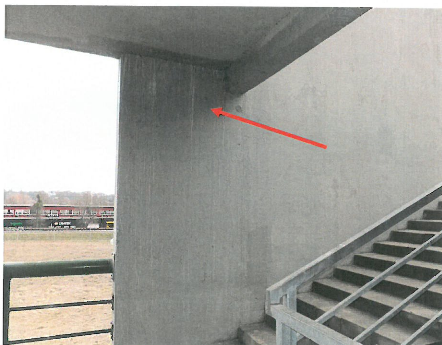
2.14 paveikslas. Laiptinės sienutėse yra karbonatinių patakų
