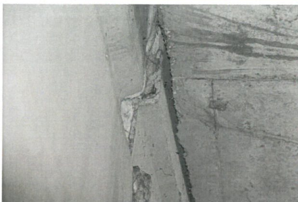
32 pav. Deformacinės siūlės nesandarios, betono sluoksnis atskilęs
