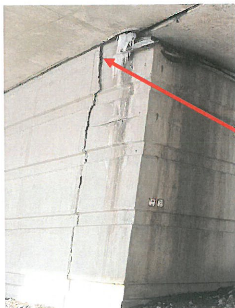
3.8 paveikslas. Atraminės sienutės viršutinė dalis atitrūkusi nuo ramto. Sienutės viršus pasislinkęs per 5,9 cm. 2013 m poslinkio dydis buvo 3 cm
