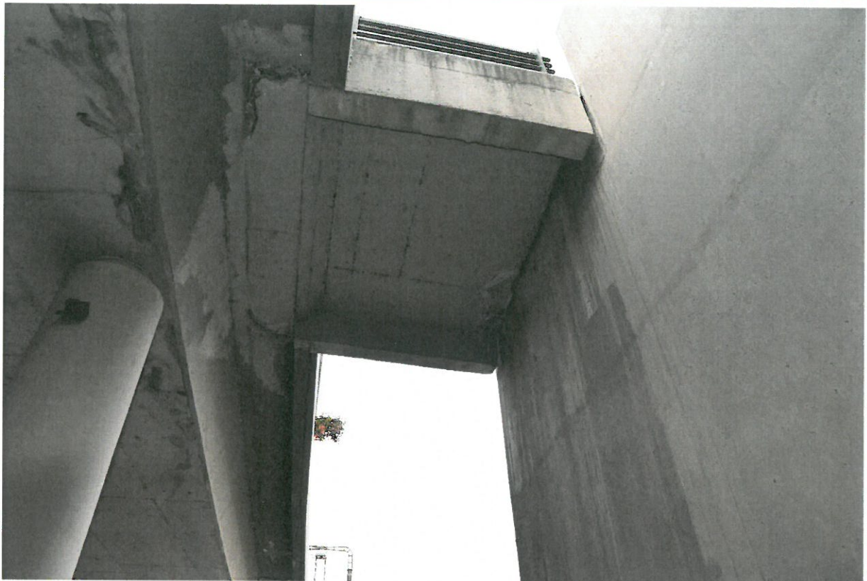
34 pav. Nesandarūs laiptinės deformaciniai pjūviai
