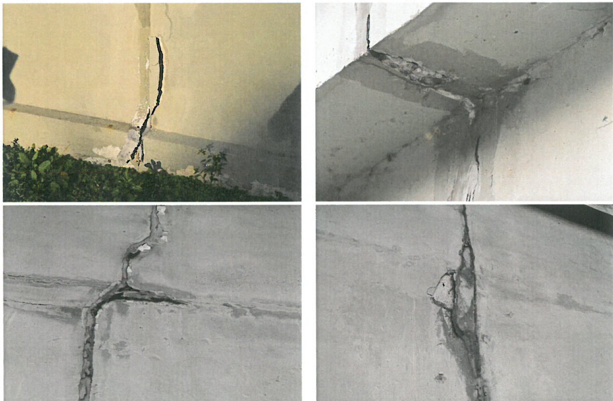
28 pav. Deformacinės siūlės nesandarios, betono sluoksnis atskilęs
