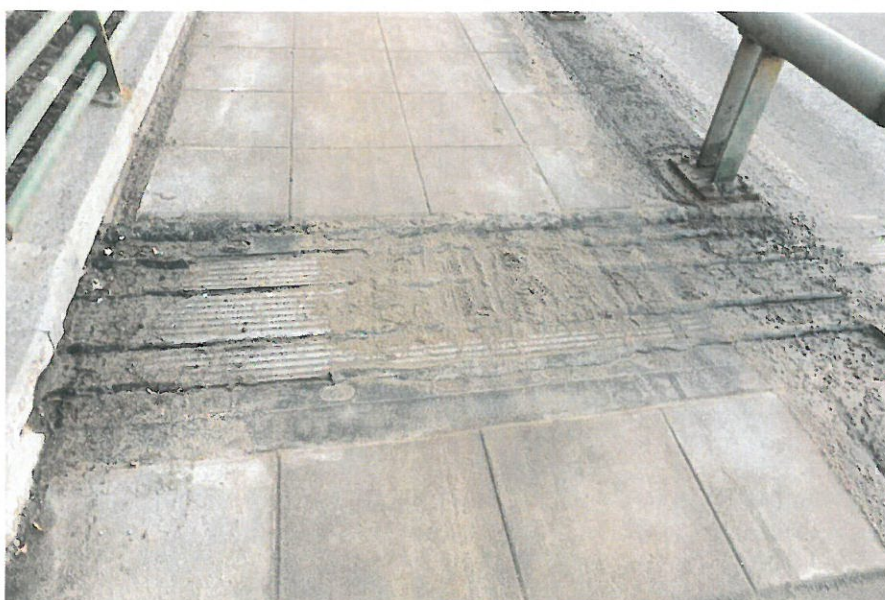
3.2 paveikslas. Dalis atitvarų stulpelių parūdiję ties įtvirtinimo į šalitiltį ir atmušą vietose. Deformacinis pjūvis kiauras, bandyta užsandarinti bitumine mastika. Vaizdas ties šalitilčiu, 5K atrama
