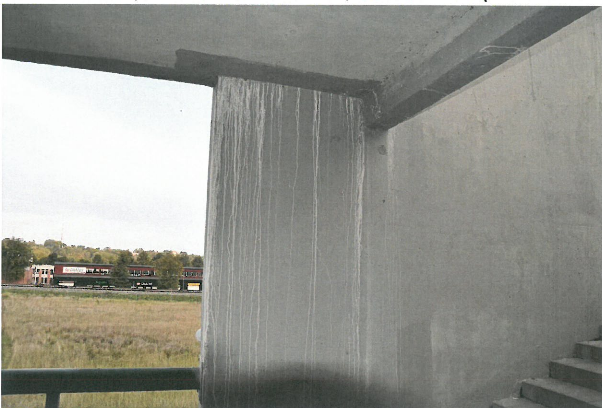
33 pav. Lietaus vanduo teka tiesiai per laiptinės sienų paviršius
