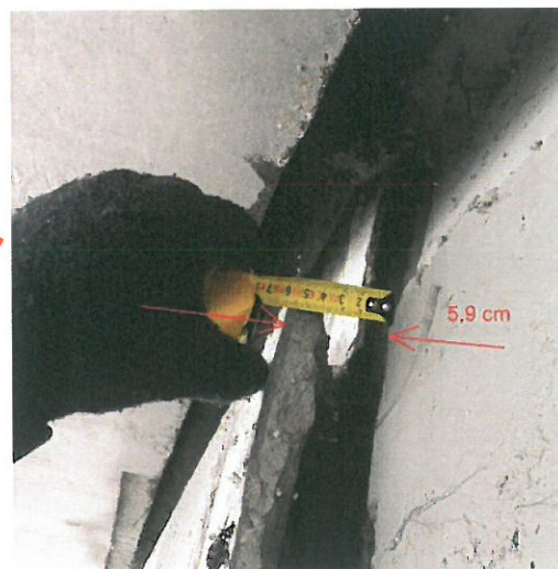
3.8 paveikslas. Atraminės sienutės viršutinė dalis atitrūkusi nuo ramto. Sienutės viršus pasislinkęs per 5,9 cm. 2013 m poslinkio dydis buvo 3 cm
