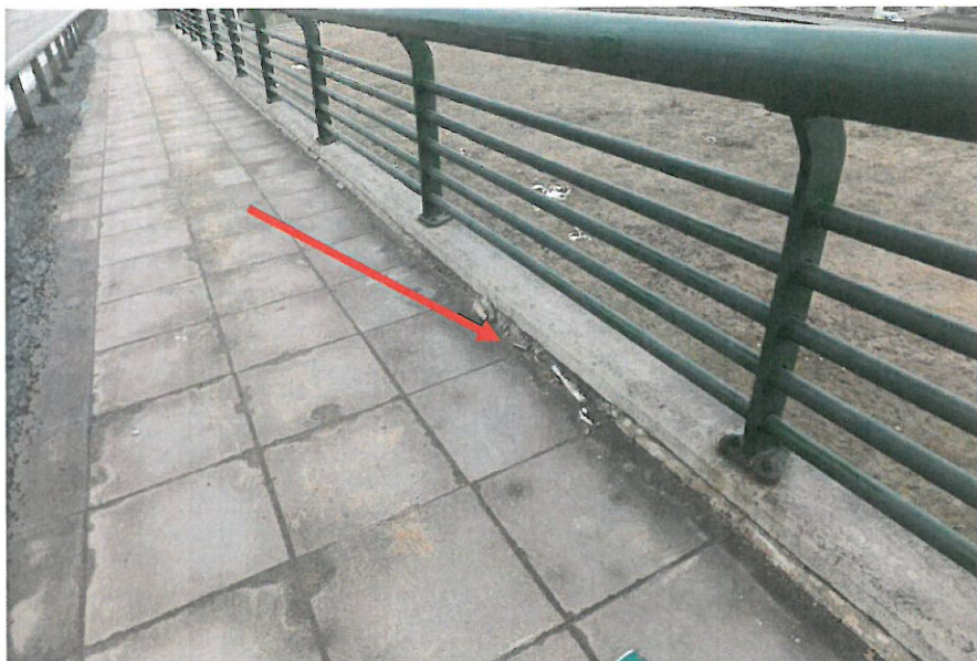
2.3 paveikslas. Suiręs užsandinimas ties turėkliniu bloku, turėklų būklė gera
