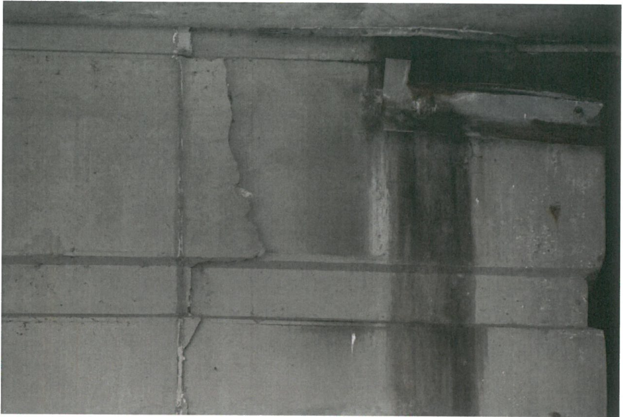
15 pav. Pjūvis nesandarus, vanduo prateka ant perdangos galinės briaunos ir atraminių dalių (Siūlė link Aleksoto 2 dešinė)
