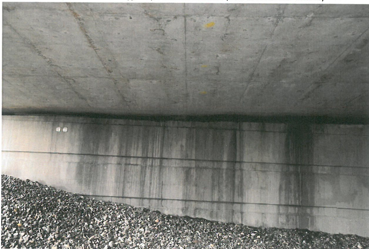
18 pav. Pjūvis nesandarus, vanduo prateka ant perdangos galinės briaunos ir atraminių dalių (siūlė link CT1 kairė)
