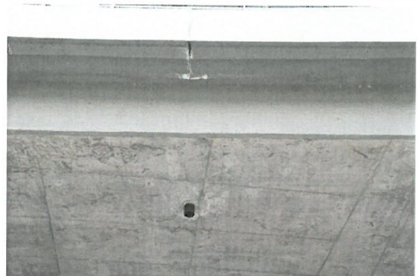
22 pav. Ties šulinėliais ir perdangos kraštuose matosi vandens prasisunkimas per hidroizoliaciją
