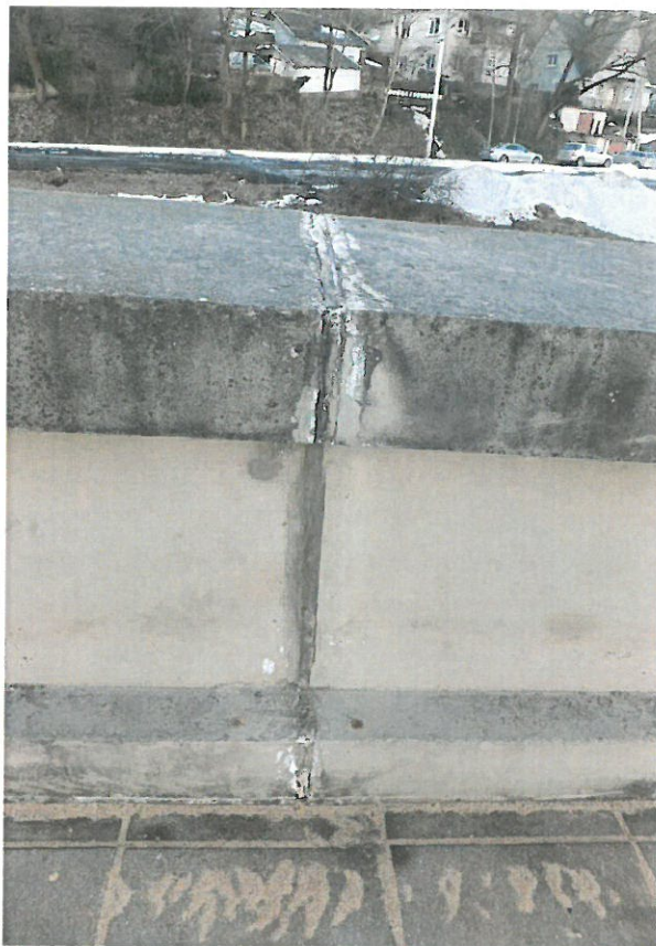
4.7 paveikslas. Sienutės „V-Z“ temperatūrinės siūlės nesandarios
