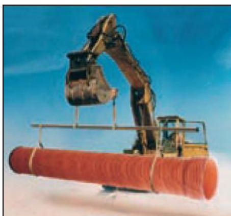
2 paveikslas. Mechanizuotas vamzdžių krovimas.
