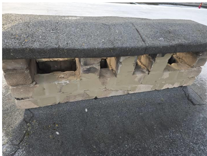
58. Suremontuotas kaminėlio mūras.
