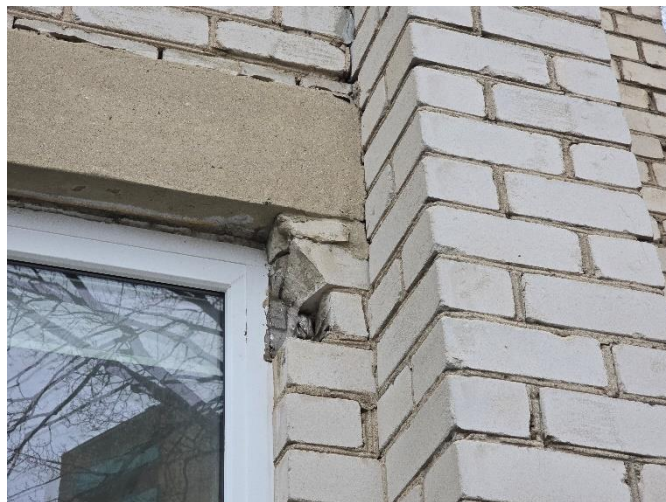
55 pav. Nuskilęs mūras sąramos atraminėje zonoje.
