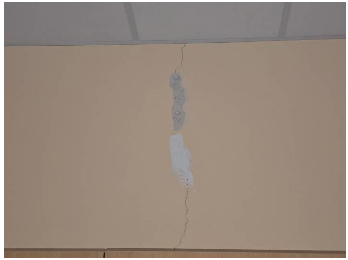
76. Plyšys patalpos 3-1 skersinėje vidinėje sienoje.
