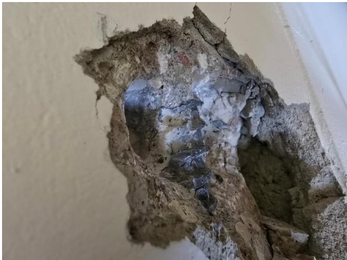
48 pav. Atidengta denginio plokštės armatūra.
