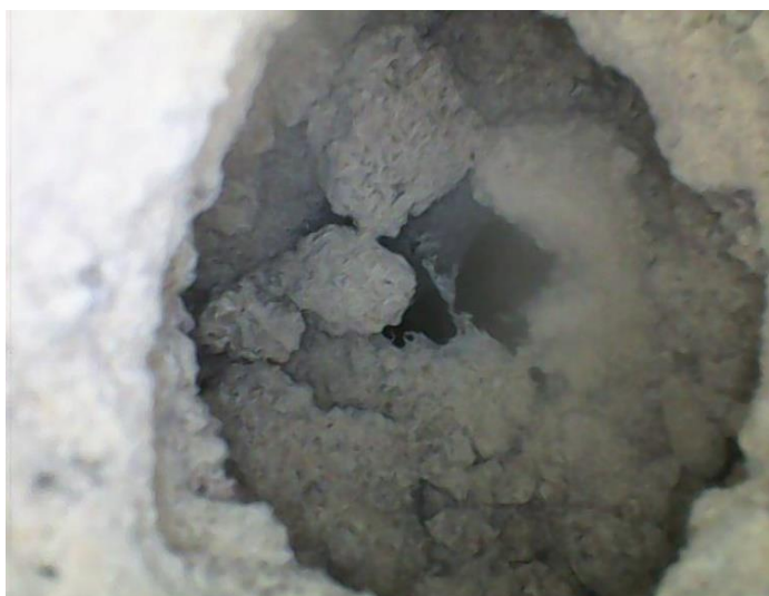
28 pav. Grindų sluoksnių tyrimas endoskopu, matomas cementinio skiedinio plėvelės sluoksniai.
