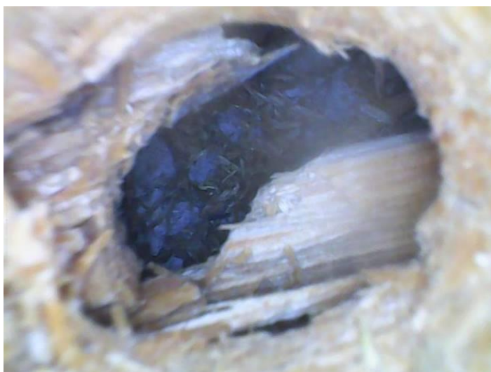
89. Grindų sluoksnių tyrimas endoskopu.
