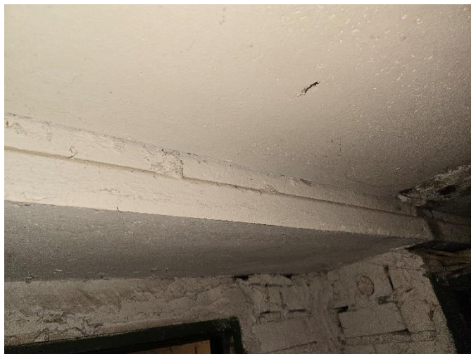
51 pav. Skirtinguose lygiuose sumontuotos perdangos plokštės (virš rūsio.)
