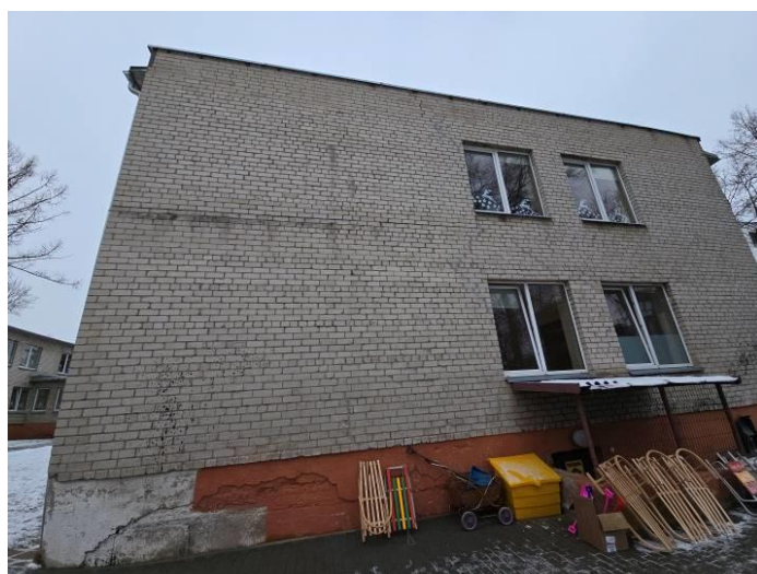
6. Šiaurinio korpuso rytinis fasadas.
