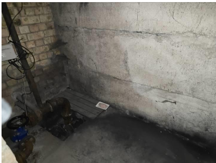
69. Rūsio siena įrengta iš gelžbetoninių blokų.
