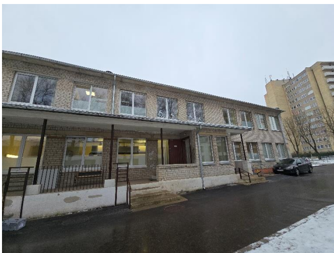
5 pav. Šiaurinio korpuso šiaurinis fasadas.
