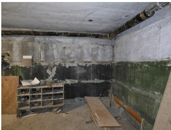
38 pav. Rūsio sienų bendras vaizdas, matomi gelžbetoniniai blokai.
