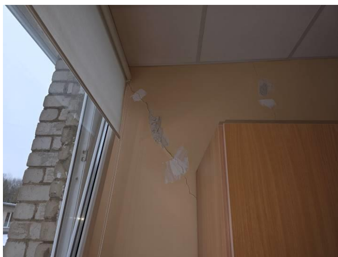
71. Plyšys patalpos 3-1 skersinėje vidinėje sienoje.
