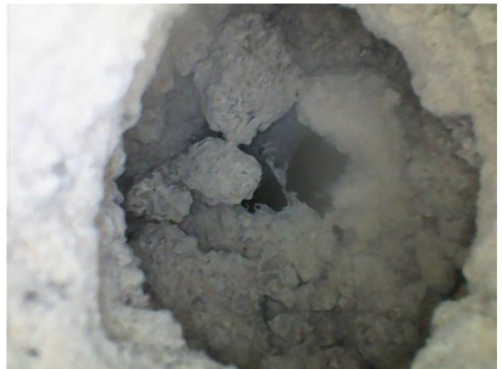
88. Grindų sluoksnių tyrimas endoskopu.
