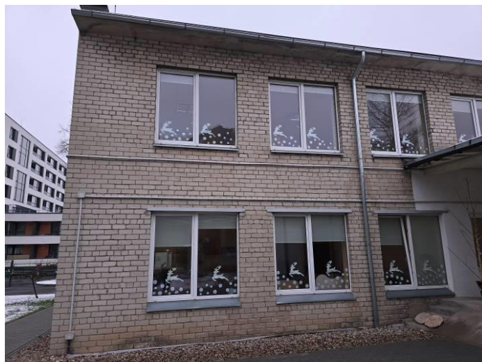
2. Bendras šiaurinio korpuso fasado vaizdas.
