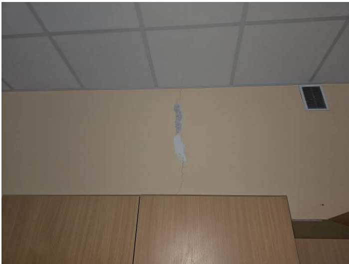
75. Plyšys patalpos 3-1 skersinėje vidinėje sienoje.
