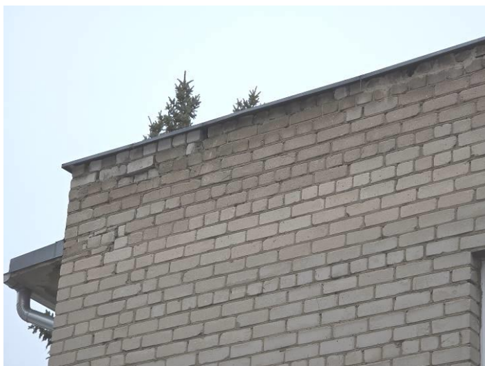
51. Bendras mūro ties patalpa 2-5 mūro vaizdas.
