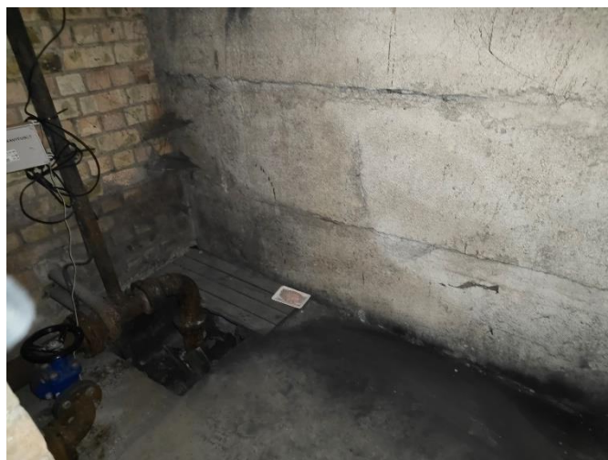
39 pav. Rūsio sienų bendras vaizdas, matoma išorinė siena iš gelžbetoninių blokų ir vidinė mūrinė siena.
