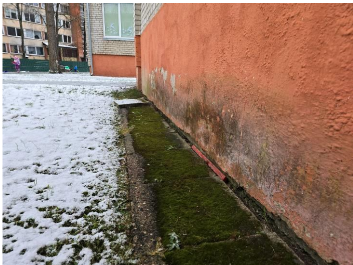
35. Bendras nuogrindos iš šaligatvio plytelių vaizdas.
