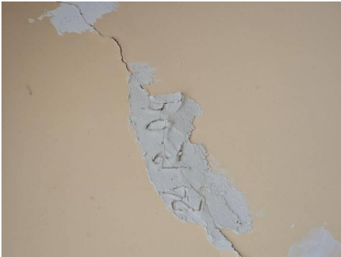
73. Plyšys patalpos 3-1 skersinėje vidinėje sienoje. Uždėta markiruotė sutrūkusi.
