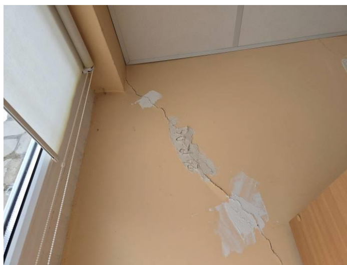
72. Plyšys patalpos 3-1 skersinėje vidinėje sienoje.
