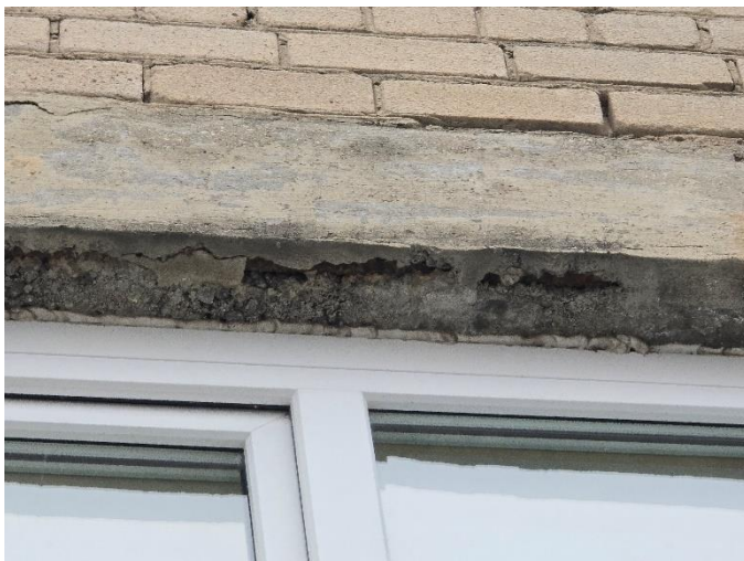
54 pav. Matoma atvira sąramos virš lango armatūra.
