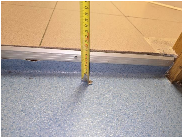
87. Tarp dalies patalpų esantis grindų aukščių skirtumas.
