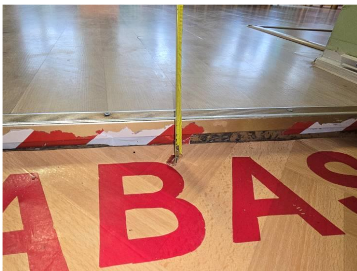
83. Tarp dalies patalpų esantis grindų aukščių skirtumas.
