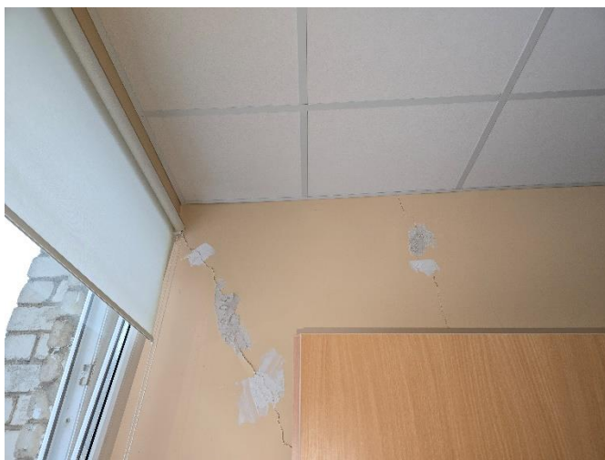
42 pav. Vidinėje skersinėje sienoje matomas plyšys (antro aukšto patalpa 3-1).
